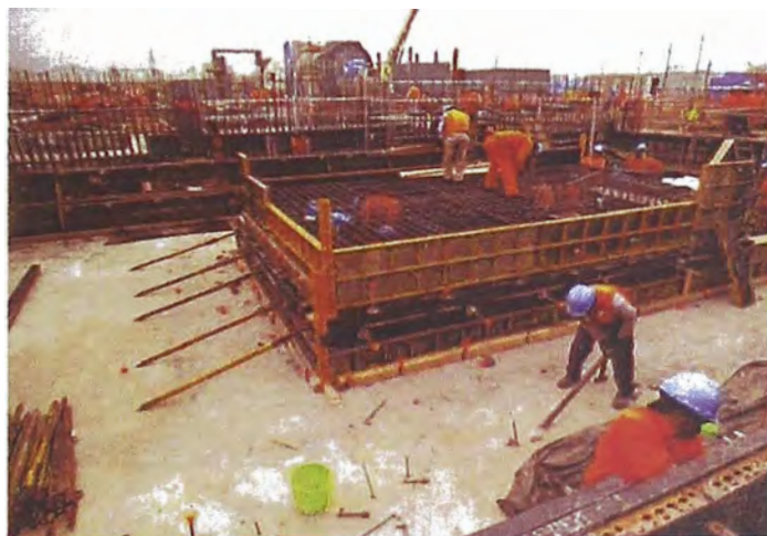
Figura 6: Colocación de encofrado en fundaciones
