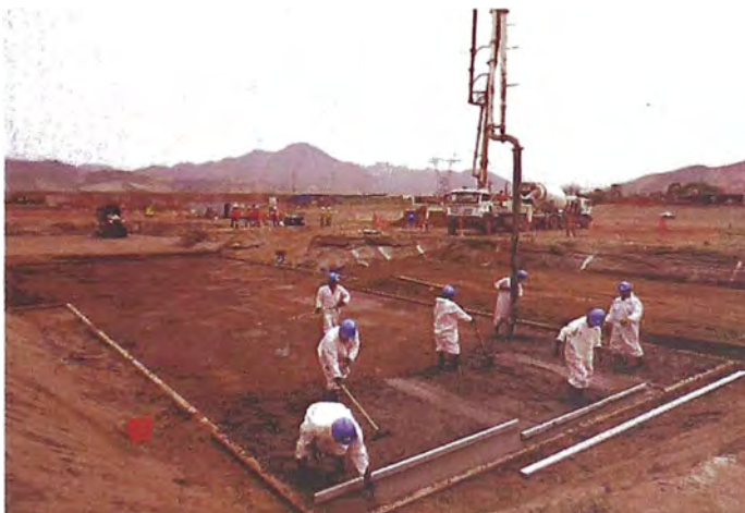
Figura 3: Vaciado de Solado ( f_c \sim 140 \text{ kg/cm}^2 )
