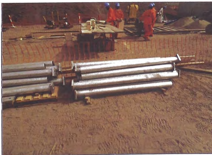
Figura 4.12: Habilitación de Pernos de Anclaje para los Pedestales de la Fundación Gas Turbine.
