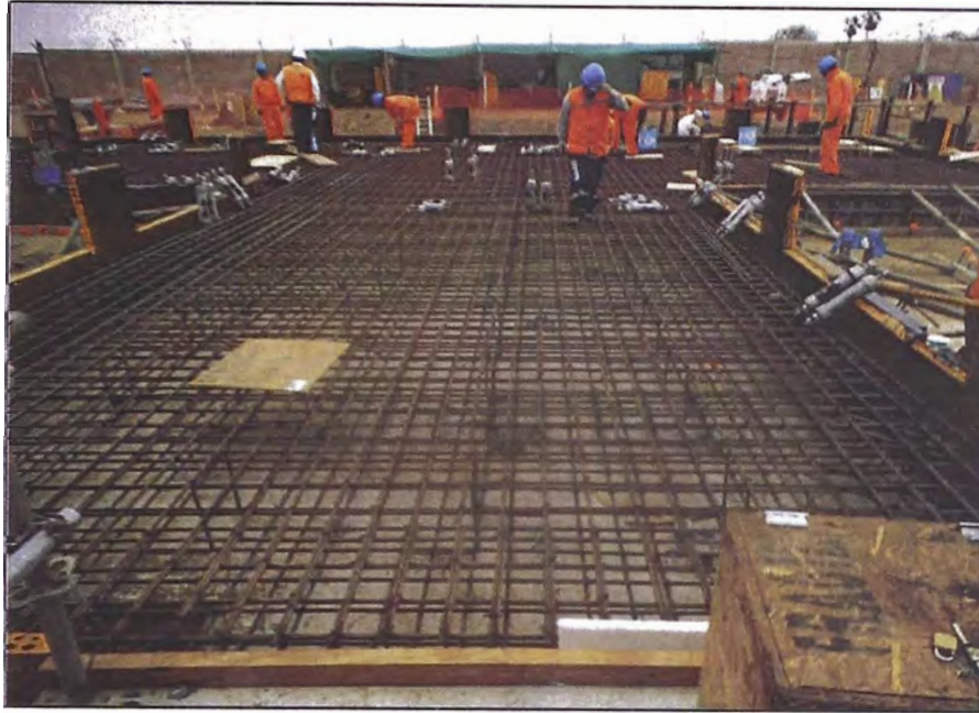
Figura 4.7: Colocación de acero dimensionado en Fundación Gas Turbine.
