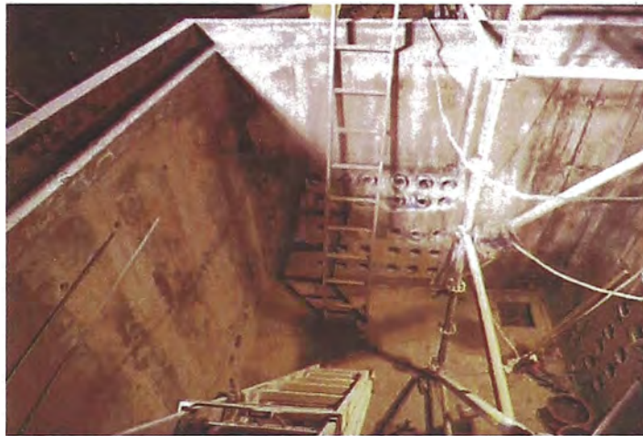
Figura 14: Vaciado de Manholes
