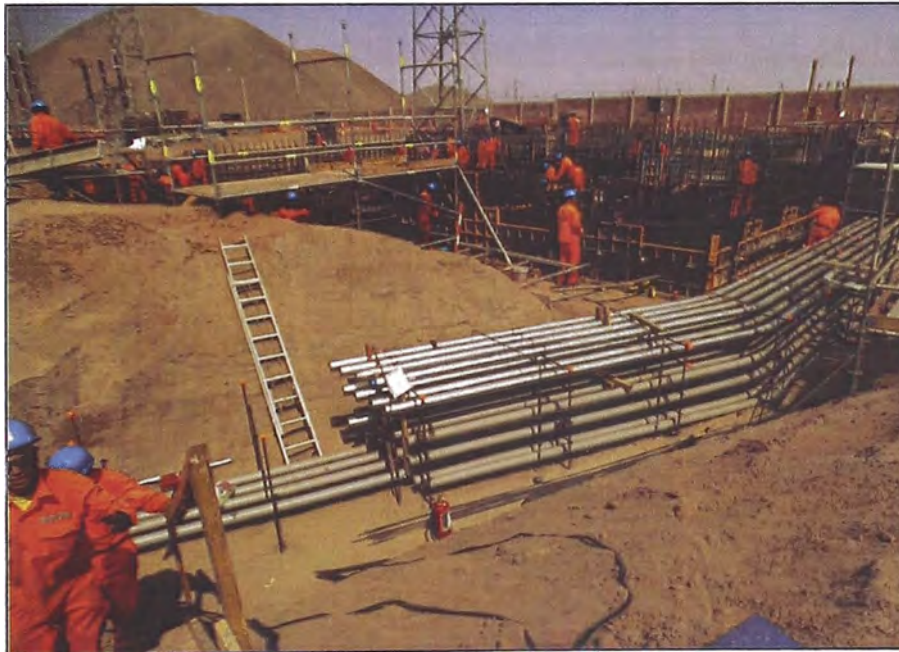
Figura 4.8: Colocación de tuberías conduit hacia el banco de ductos.
