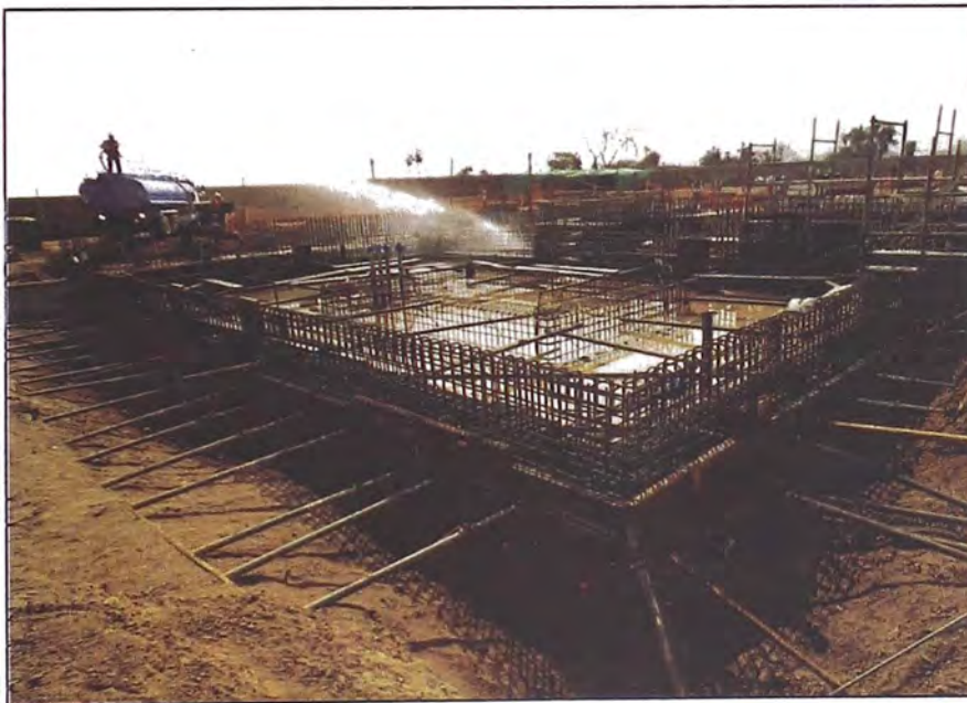
Figura 4.18: Curado de Losa de Cimentación usando agua potable.
