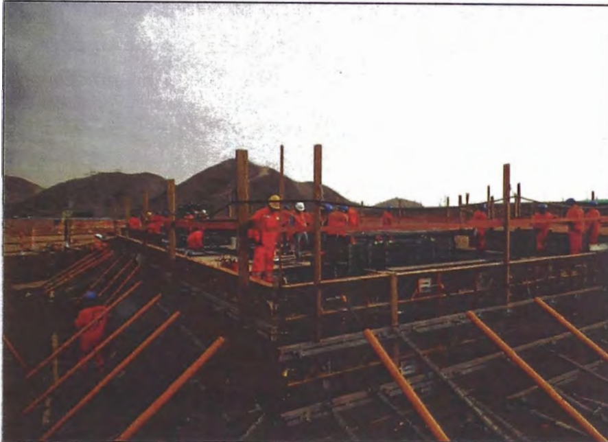
Figura 4.10: Apuntalamiento y Encofrado de Fundación Gas Turbine.
