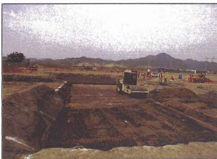
Figura 4.3: Nivelación y Compactación del Terreno de Fundación.
