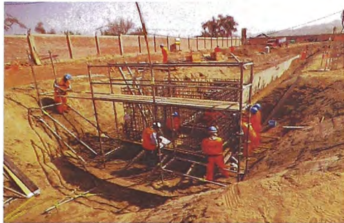
Figura 13: Colocación de acero de Manholes
