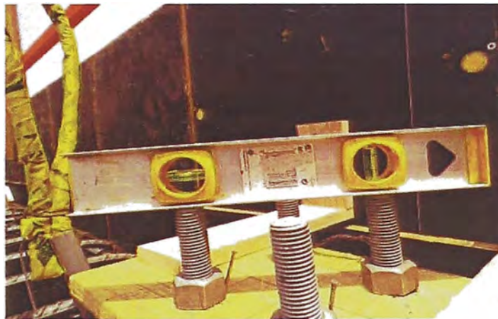
Figura 8: Colocación y nivelación de pernos de anclaje
