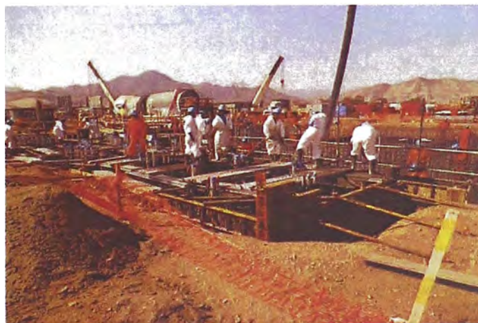
Figura 9: Vaciado de Fundaciones
