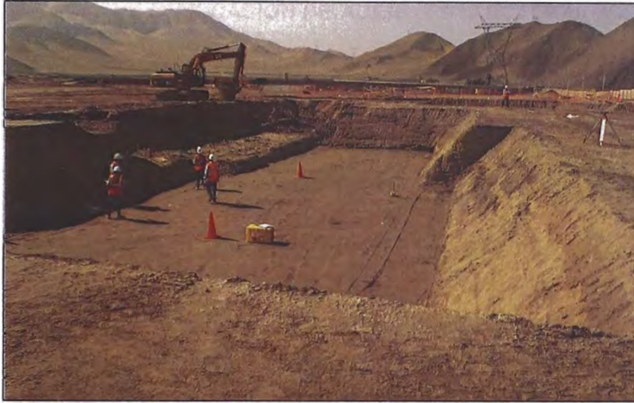
Figura 4.4: Prueba de Compactación en fundación con densímetro nuclear.
