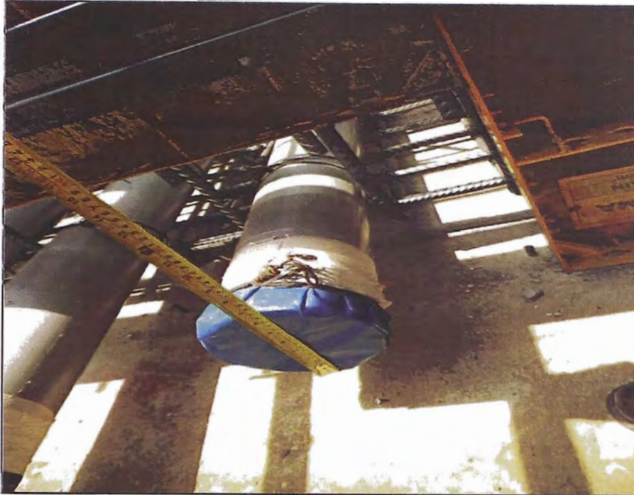
Figura 4.9: Verificación de niveles de tuberías Conduit en la Fundación.
