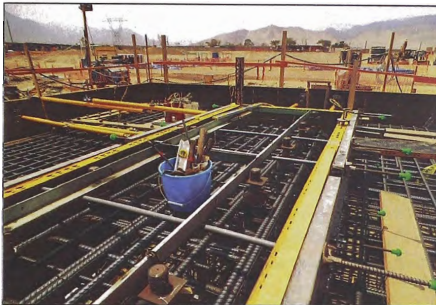
Figura 4.13: Colocación de Pernos de Anclaje en Pedestales.
