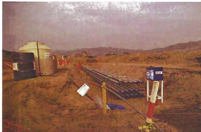
Figura 11: Colocación de tuberías para banco de ductos
