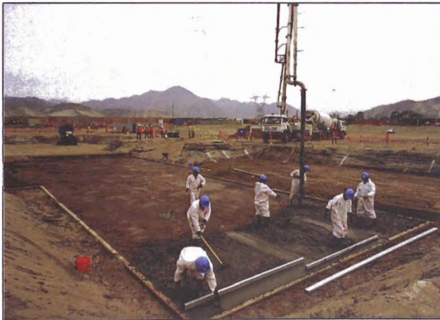
Figura 4.5: Vaciado de Solado en Fundación Gas Turbine.
