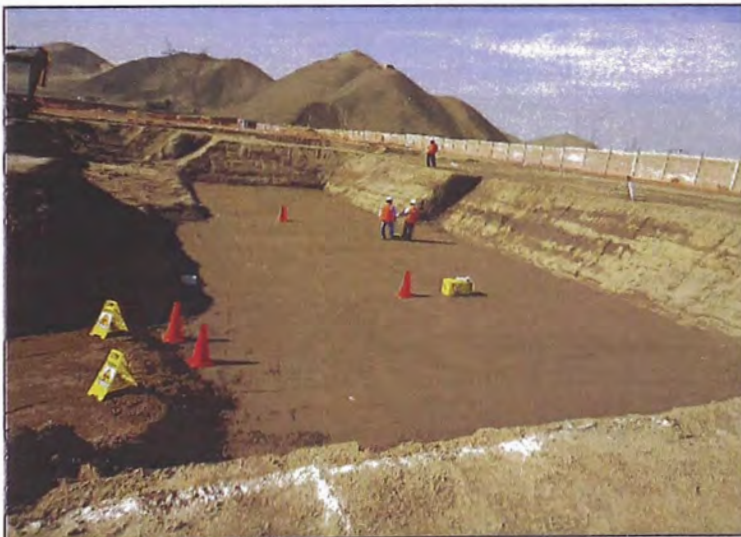
Figura 3.3: Señalización del área de trabajo.
