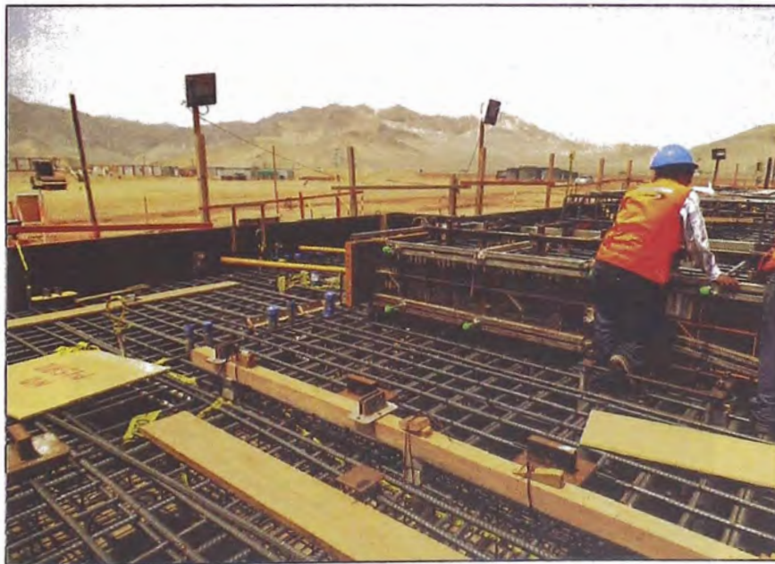
Figura 4.11: Encofrado de Pedestales de la Fundación Gas Turbine.
