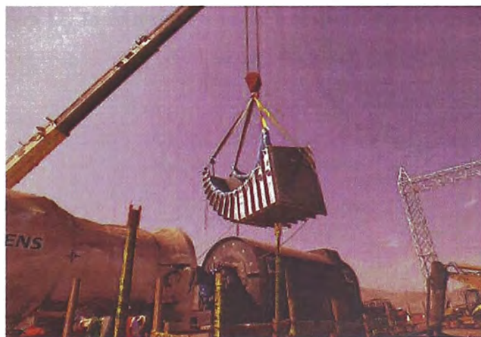
Figura 15: Montaje de las estructuras electromecánicas
