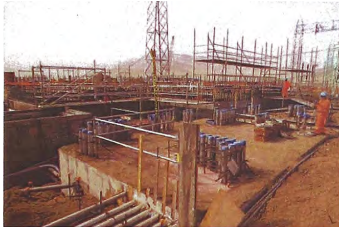
Figura 10: Losa de cimentaciones vaciadas y curadas
