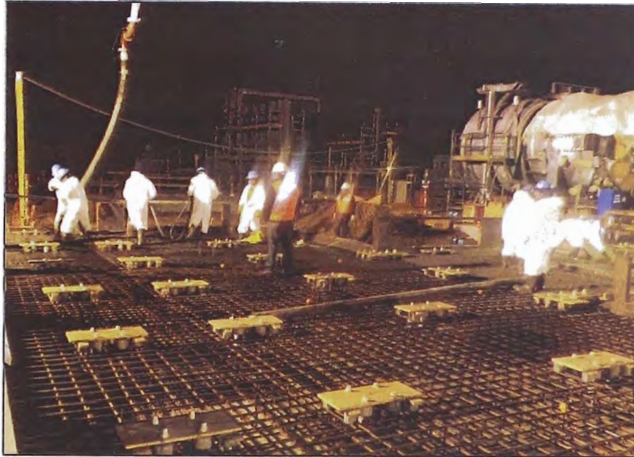
Figura 4.16: Vertido de concreto premezclado en Fundación.
