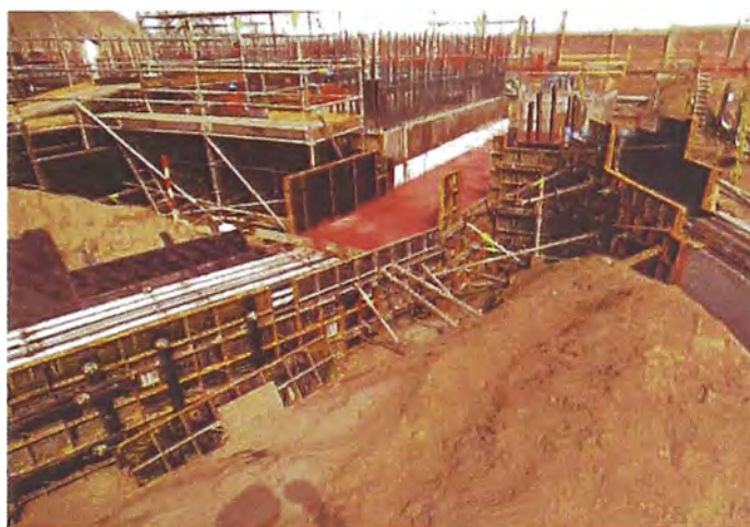
Figura 12: vaciado de Banco de Ductos y pintado con ocre rojo en la superficie
