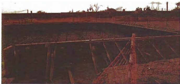
Figura 5: Colocación de acero estructural
