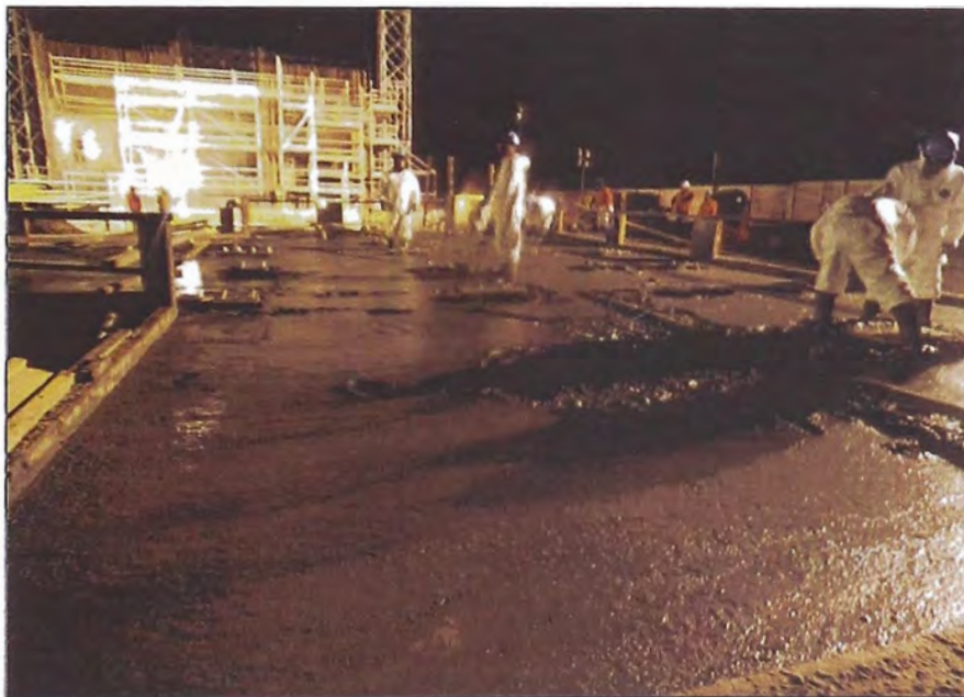
Figura 4.17: Acabado de la Losa de Cimentación en Fundación.
