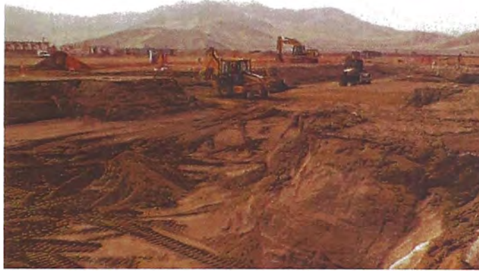
Figura 1: Excavación, nivelación y compactación de terreno
