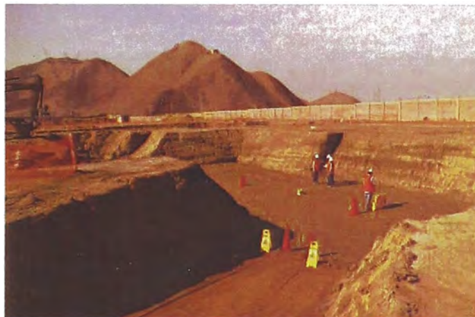
Figura 2: Prueba de compactación por capas empleando un densímetro
