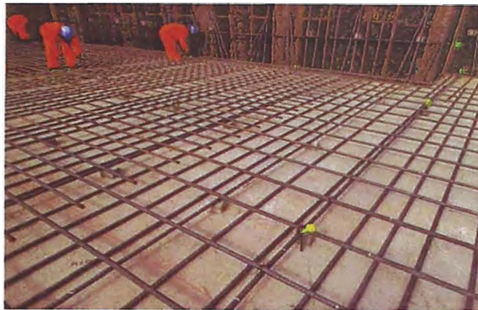
Figura 4: Colocación de acero estructural
