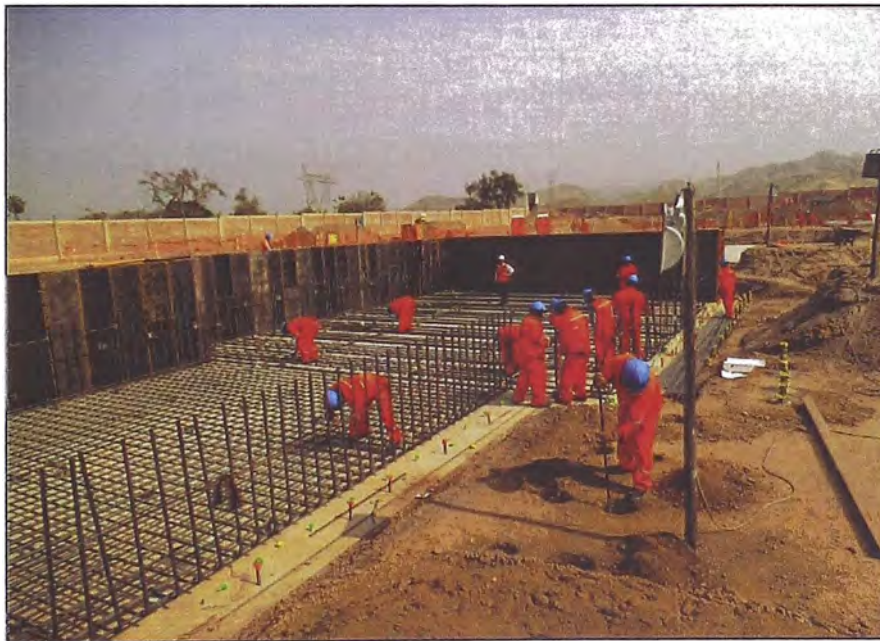
Figura 4.6: Colocación de acero dimensionado en Fundación Gas Turbine.
