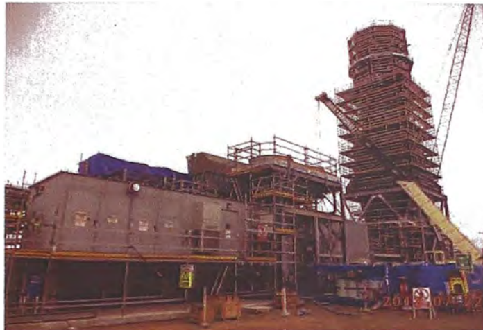
Figura 16: Montaje de las estructuras electromecánicas
