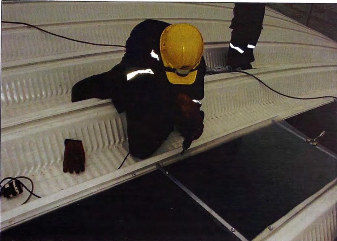
Fotografía N° 3.11. Instalación simétrica de paneles traslúcidos (Referencia 10)
