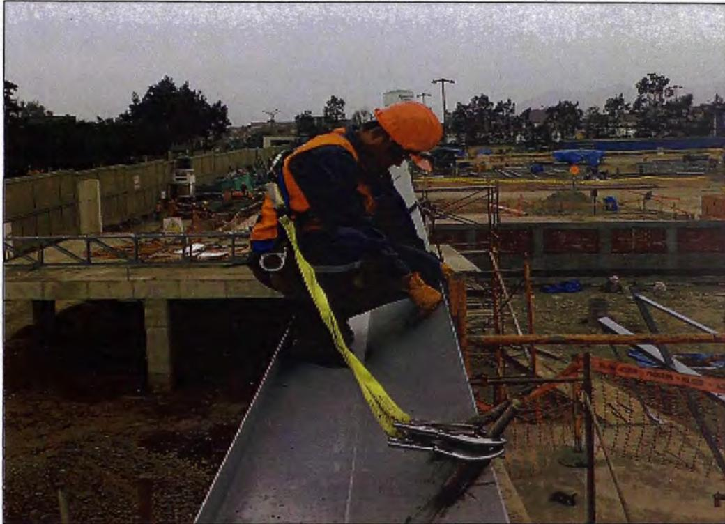
Fotografía N° 4.9. Trazado en viga canal metálica (Referencia 12)
