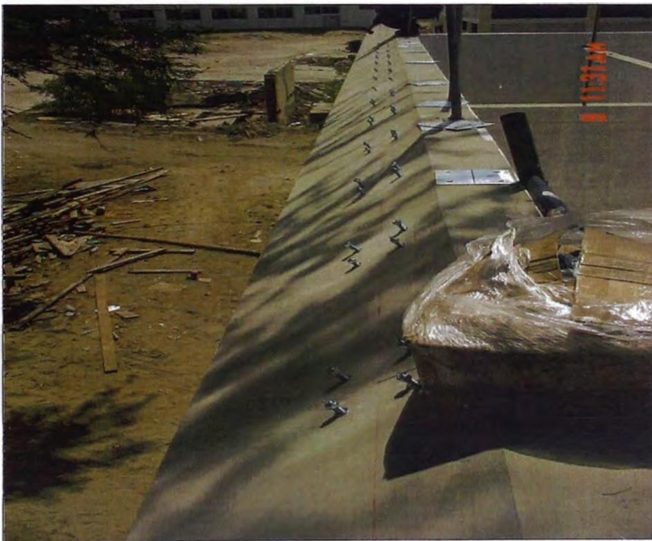
Fotografía N° 2.10. Colocación de pernos de fijación en viga de concreto
