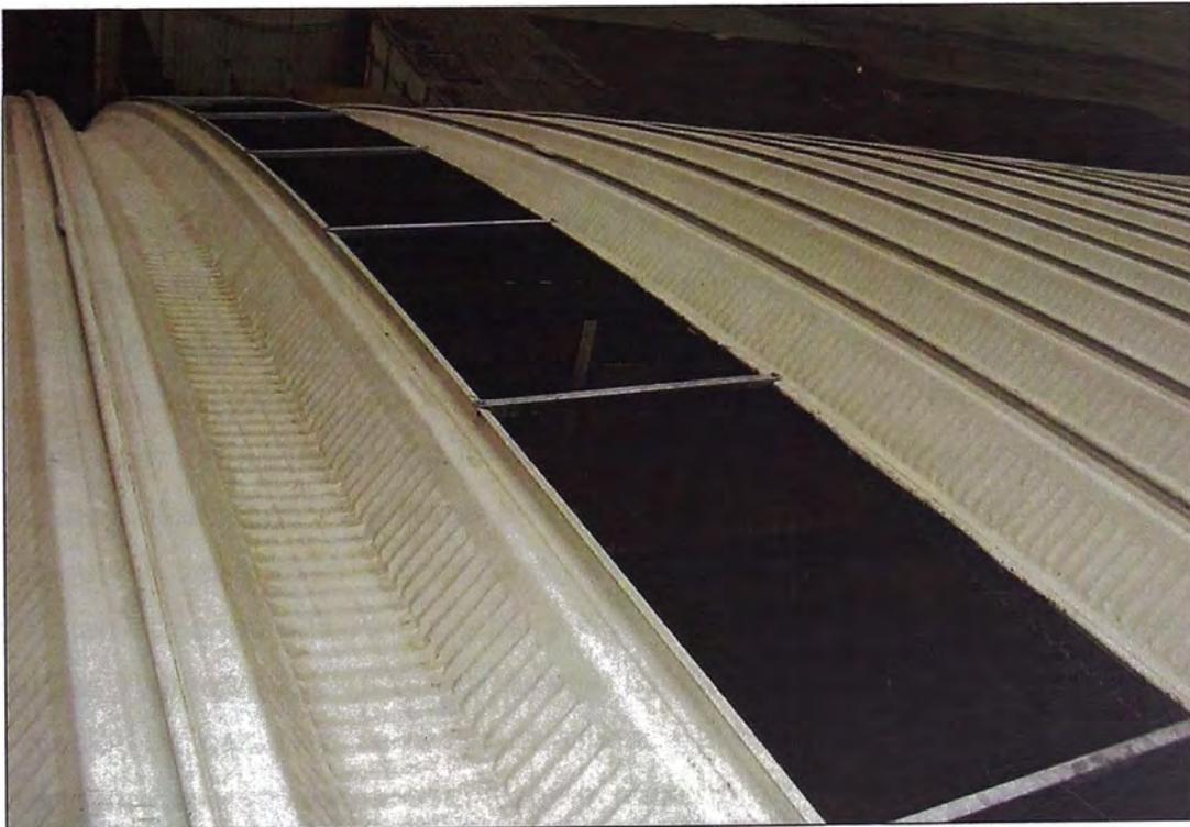
Fotografía N° 3.10. Instalación de ángulos galvanizados (Referencia 10)
