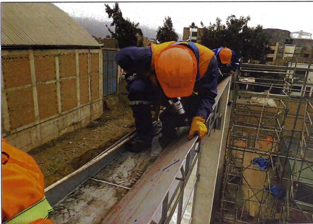
Fotografía N° 3.6. Perforación en viga canal metálica (Referencia 12)
