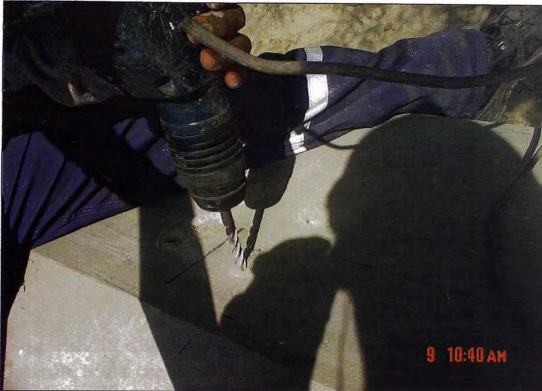
Fotografía N° 2.8. Perforación de viga de concreto (Referencia 13)
