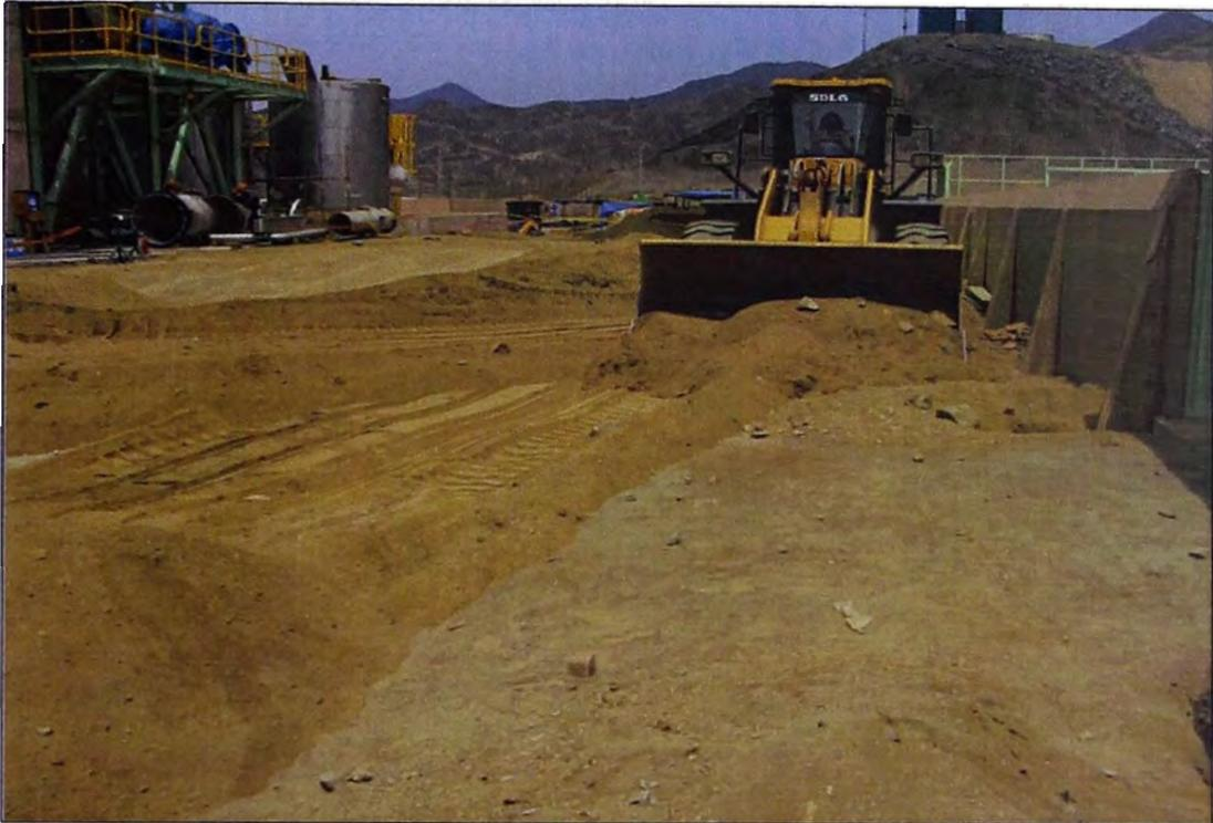
Fotografía N° 4.16. Nivelación del terreno antes de ubicar la máquina conformadora (Referencia 15).
