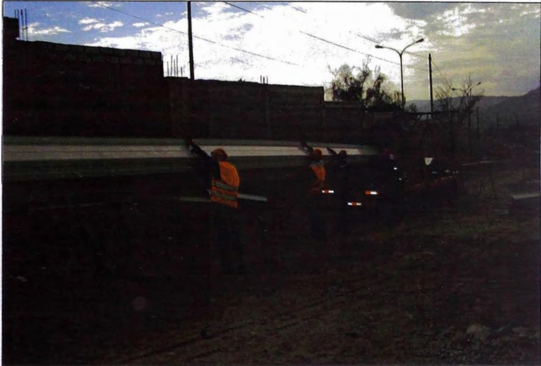
Fotografía N° 4.5. Panel plano ingresando para el curvado (Referencia 16)
