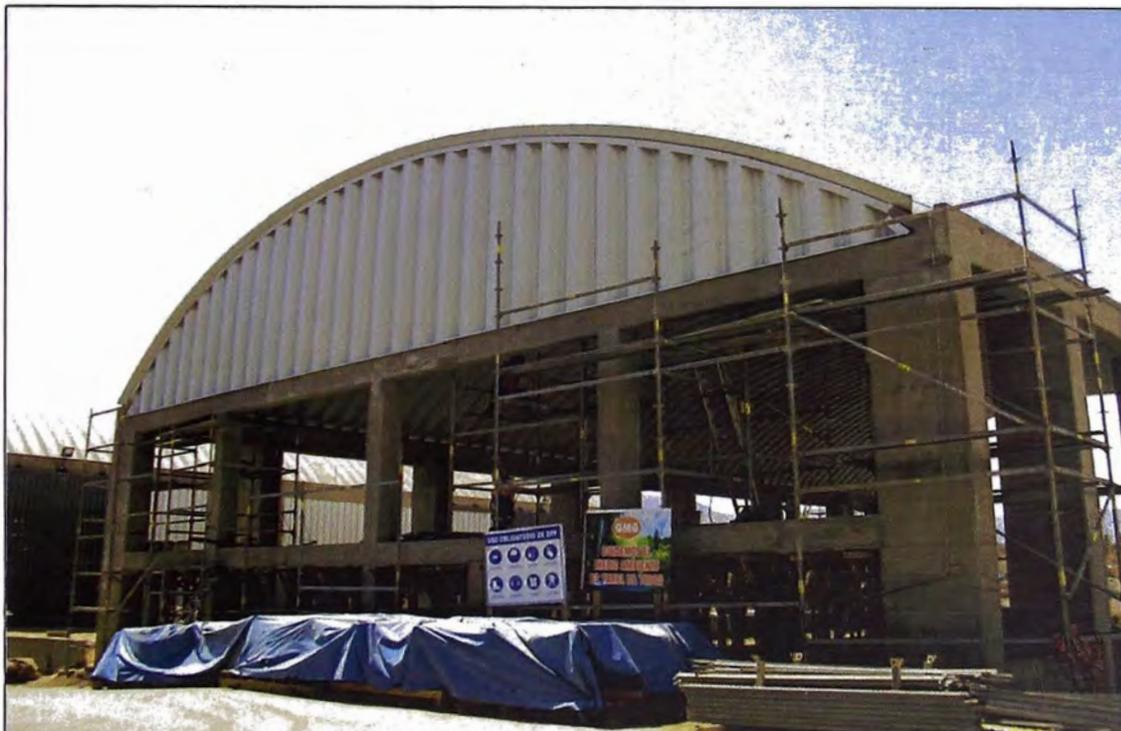
Fotografía N° 4.37. Verificación de sellado interior de paneles planos en tímpano
