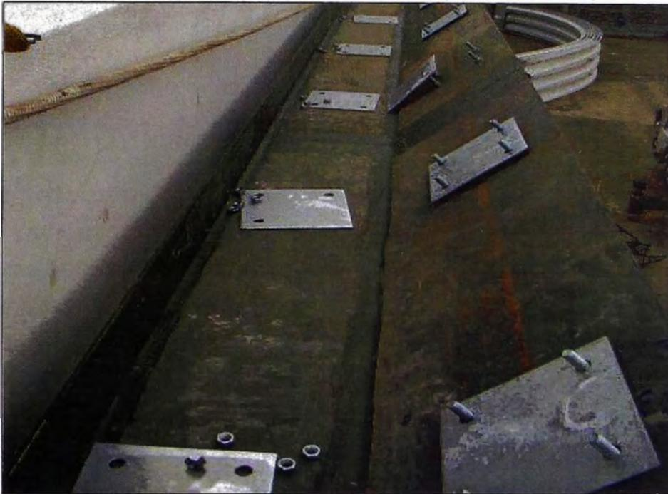
Fotografía N° 2.9. Colocación de pernos y placa de fijación en viga metálica
