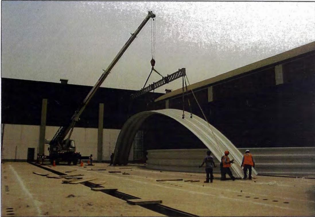
Fotografía N°4.30. Estabilizando terceta con cuerdas de viento y guía
