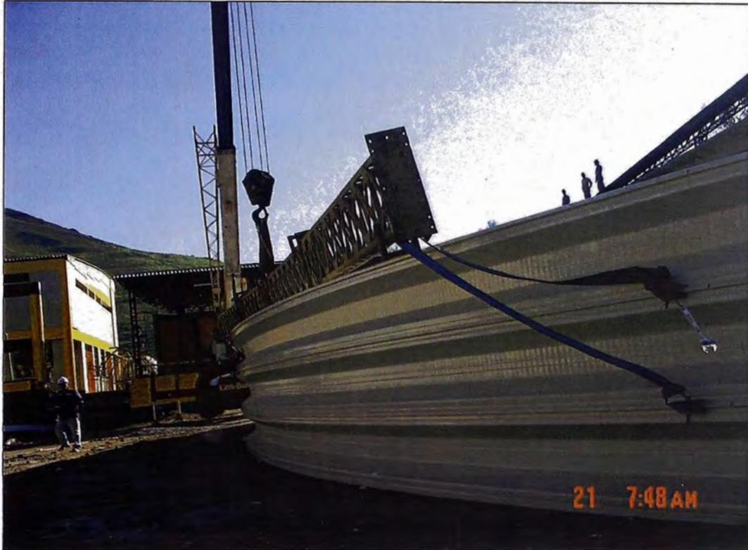
Fotografía N° 4.11. Enganche de terceta con pinza de izaje (Referencia 11)
