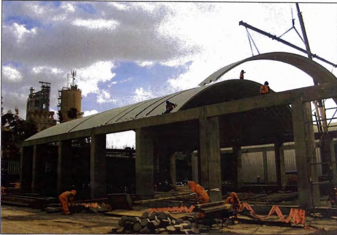
Fotografía N° 4.34. Montaje total de tercetas (Referencia 19)
