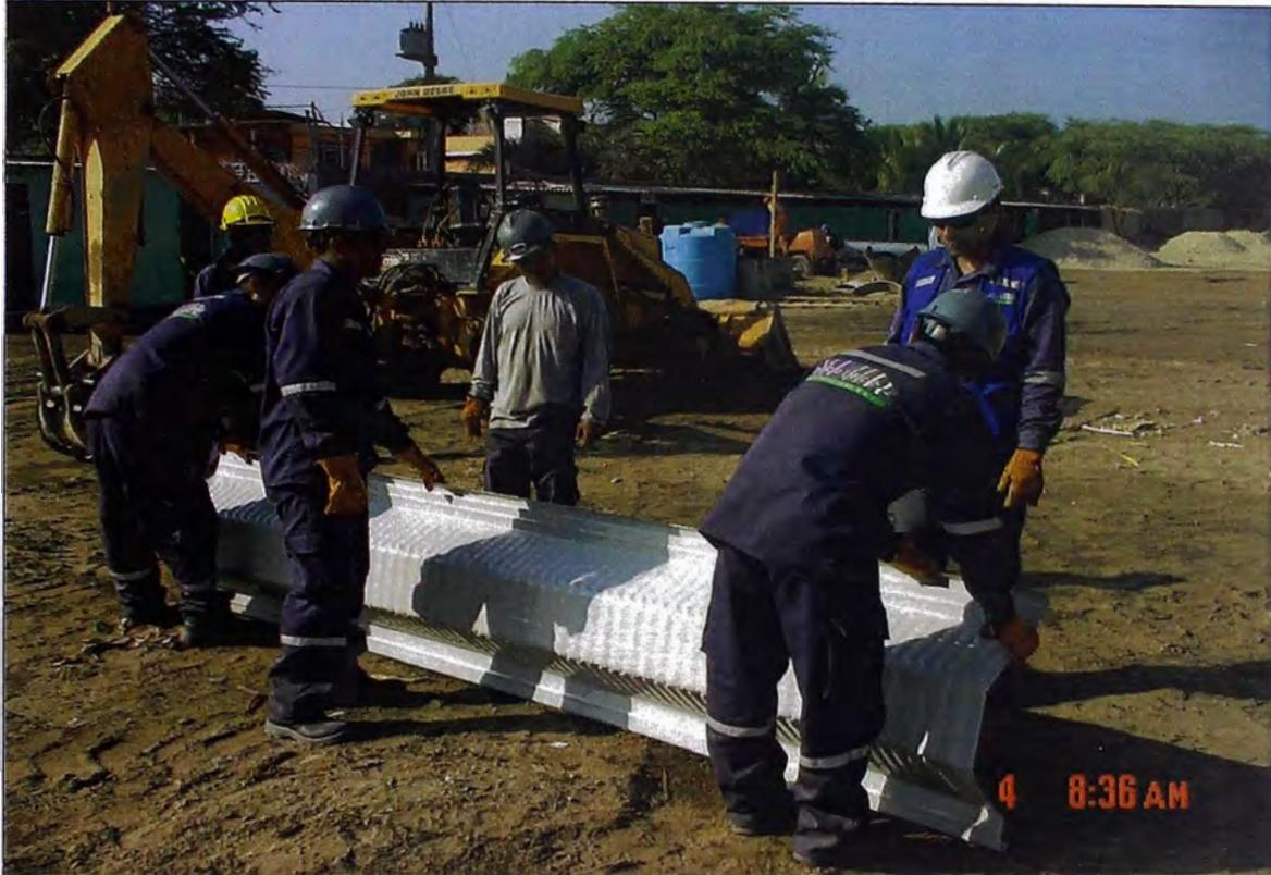
Fotografía N° 4.22. Arco de prueba de 3 metros (Referencia 13)
