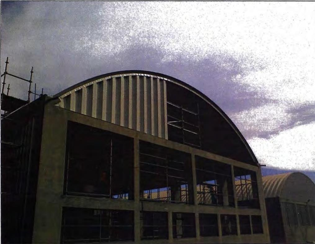
Fotografía N° 2.14. Instalación de paneles planos en tímpano (Referencia 15)
