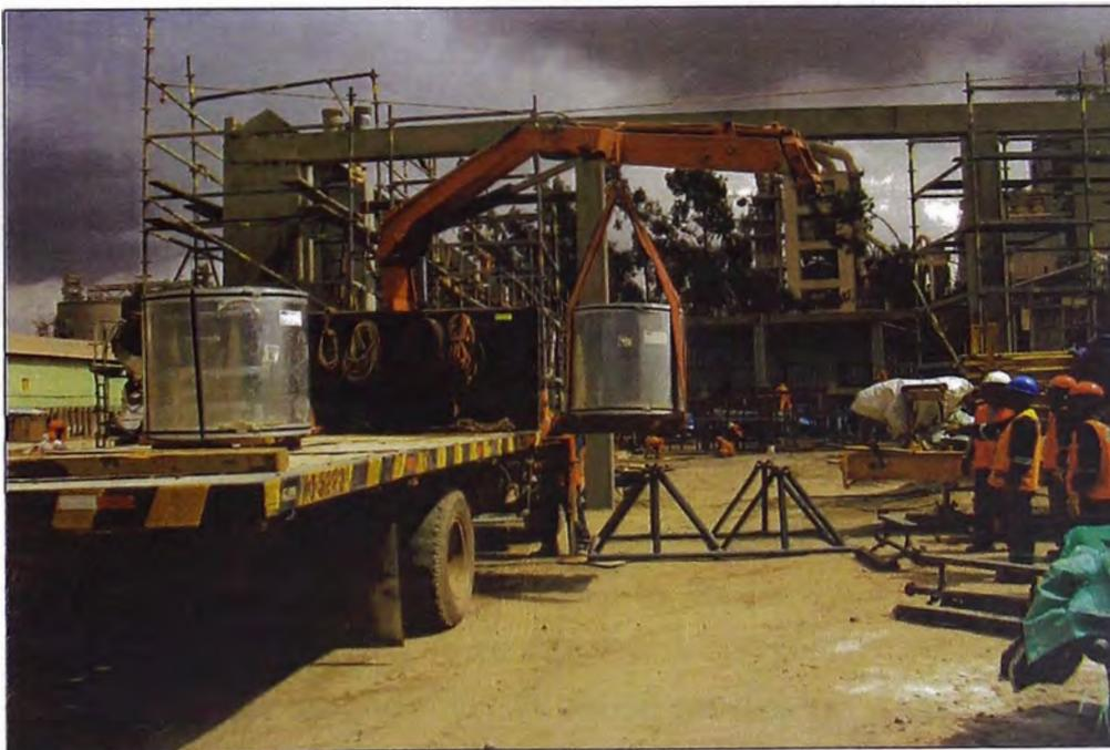
Fotografía N° 3.2. Traslado e izaje de bobinas (Referencia 19)
