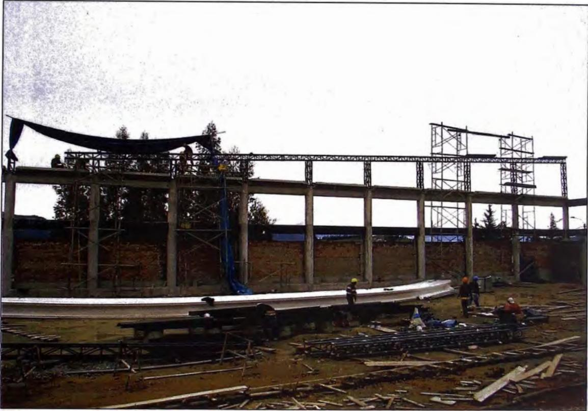
Fotografía N° 3.19. Viga metálica de soporte en área a techar irregular
