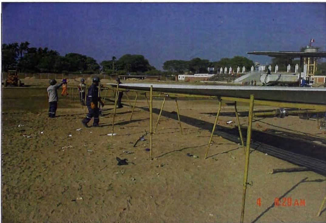
Fotografía N° 4.17. Nivelación de máquina conformadora y mesas de soporte (Referencia 13)
