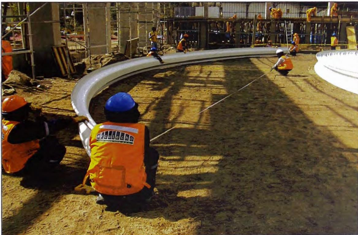
Fotografía N° 4.23. Verificación de luz y flecha (Referencia 19)
