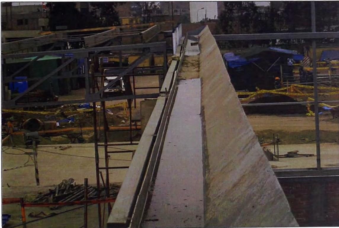
Fotografía N° 3.5. Angulo de inclinación de viga canal (Referencia 12)
