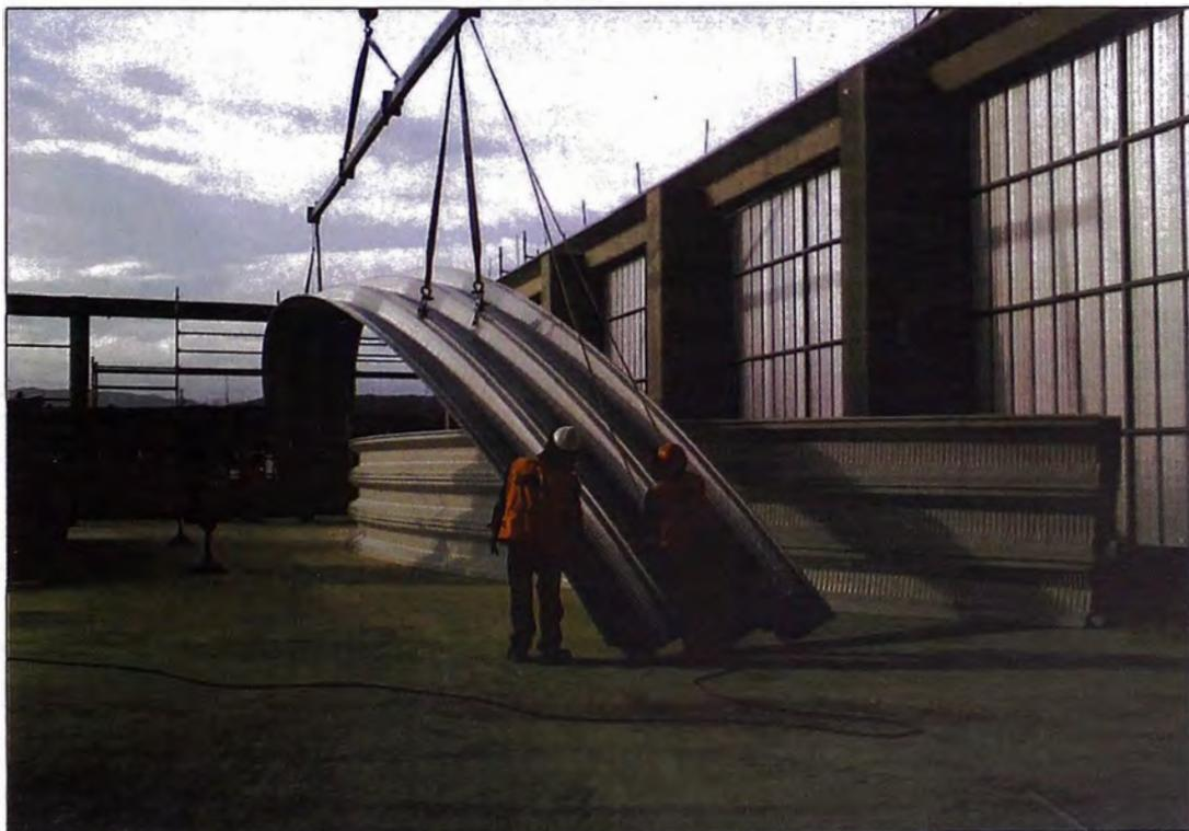
Fotografía N° 4.12. Asegurando guías de viento en terceta (Referencia 15)
