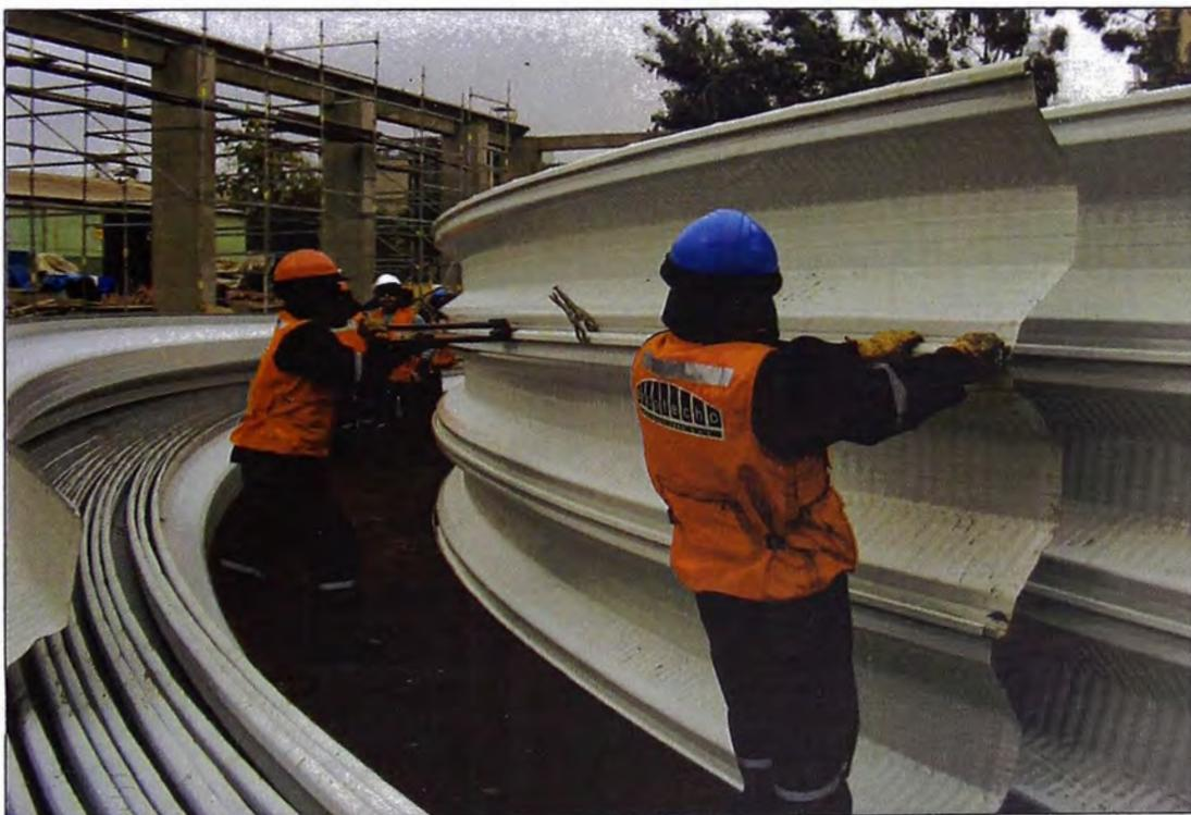
Fotografía N° 4.25. Sellado manual de tercer arco (Referencia 19)
