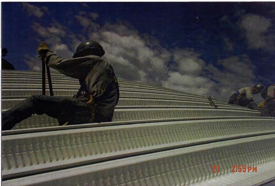
Fotografía N° 4.33. Sellado manual de tercetas en montaje (Referencia 12)
