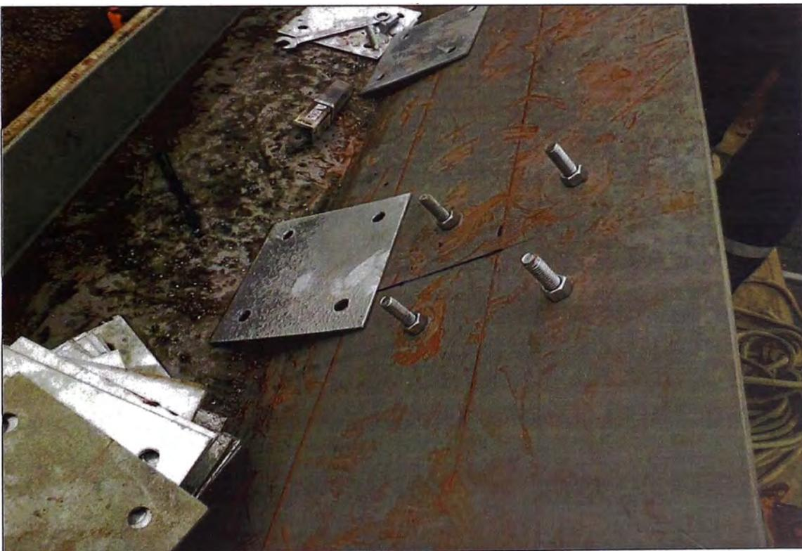
Fotografía N° 3.7. Pernos y placas de fijación en viga metálica (Referencia 12)
