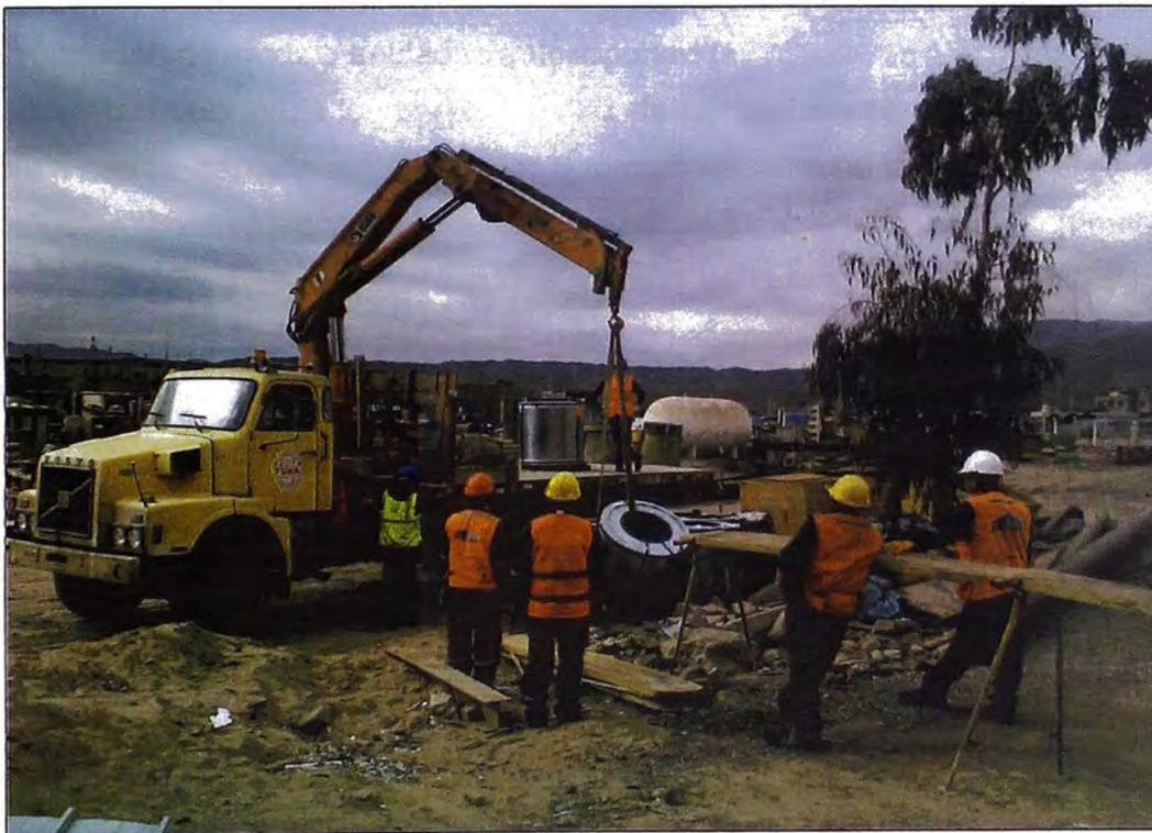
Fotografía N° 2.3. Izaje de bobinas (Referencia 15)
