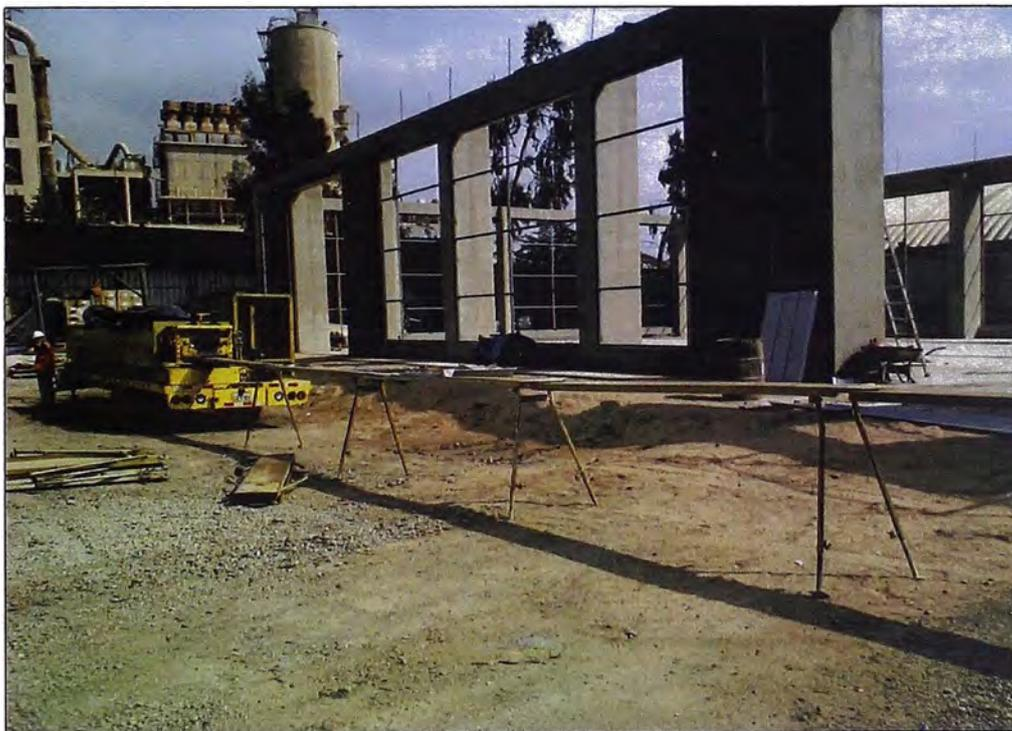
Fotografía N° 2.2. Nivelación de máquina conformadora y tendido de mesas de soporte (Referencia 15)
