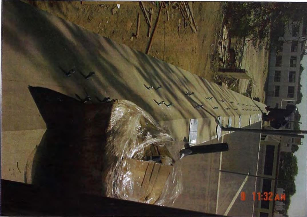
Fotografía N° 3.8. Pernos y placas de fijación en viga de concreto
