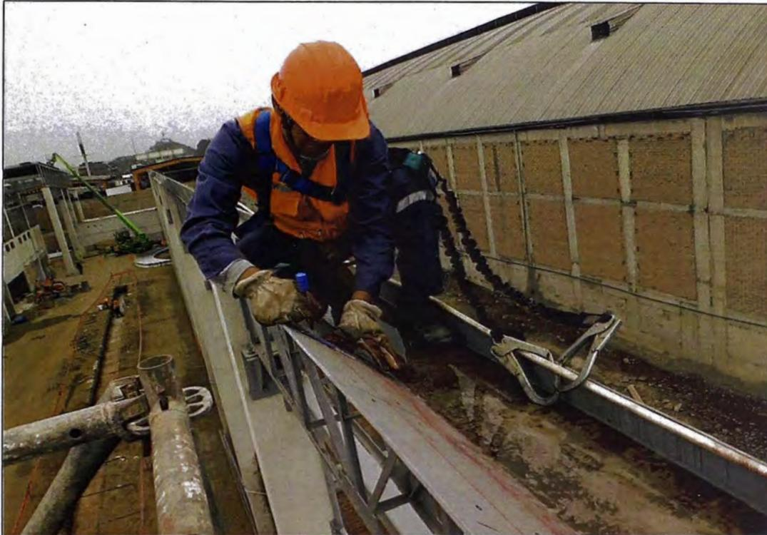
Fotografía N° 4.28. Trazo de ejes de instalación de arcos (Referencia 12)
