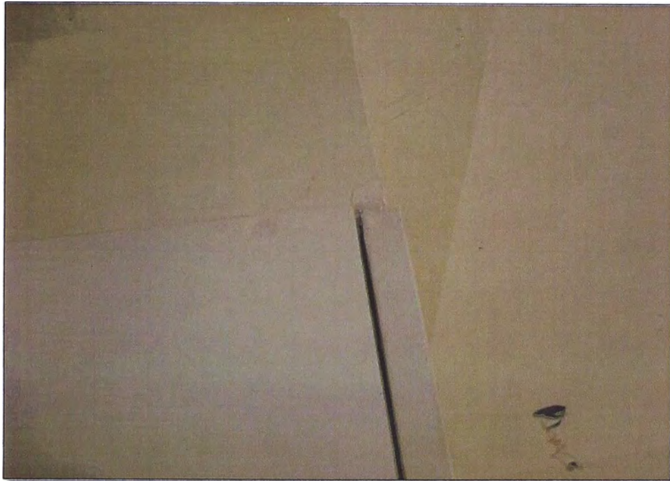
Foto 5.4: No coincide puerta con pared (en la vertical).
