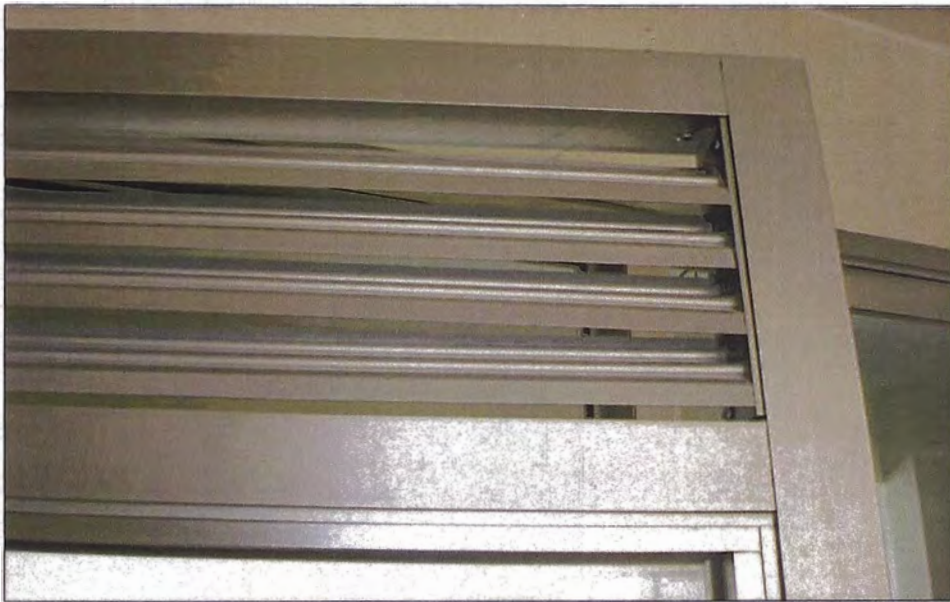
Foto 2.4: La celosía no debe tener el marco y los tornillos no son los adecuados.
