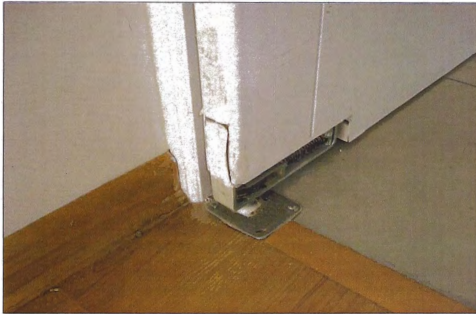
Foto 1.6: Falta un accesorio de la bisagra vaivén.
