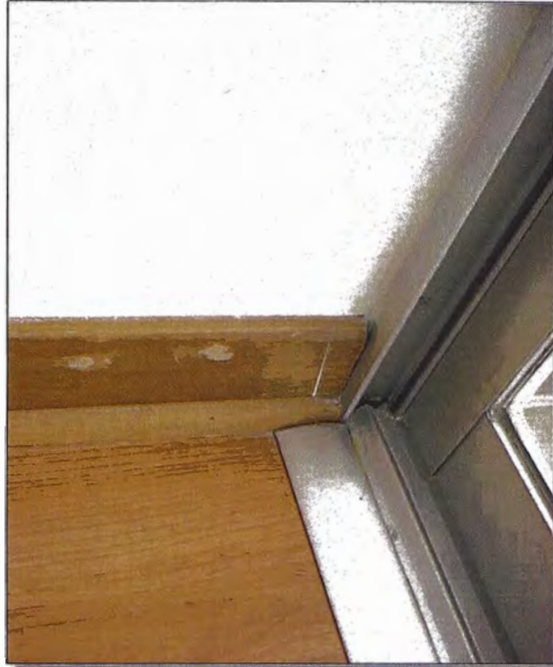
Foto 4.5: Mal matizado para ocultar cabezas de clavos.
