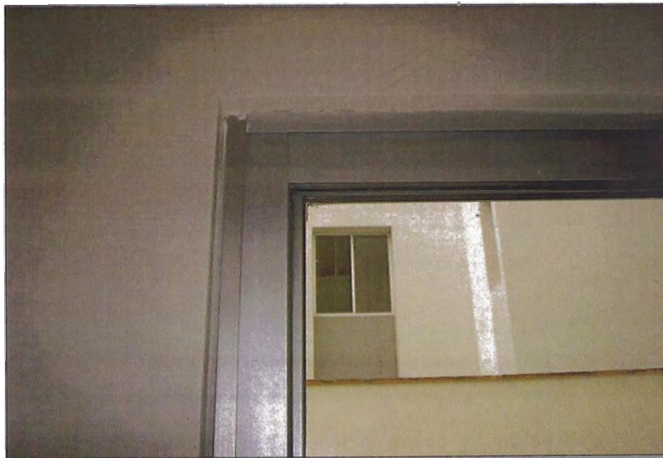
Foto 2.2: La unión entre el vertical y horizontal debe ser en 45°.
