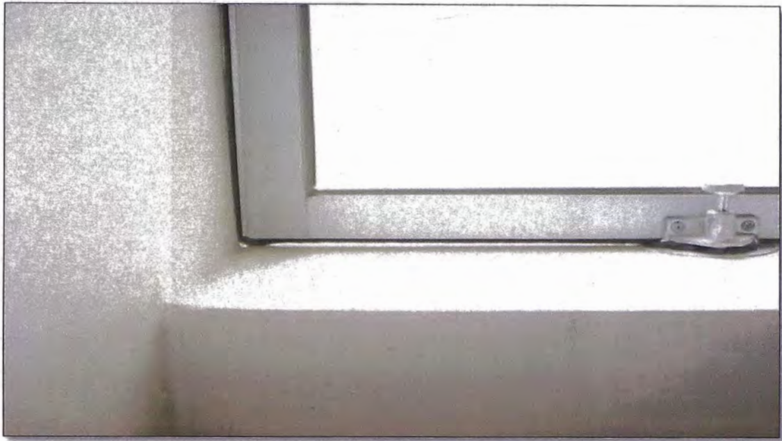
Foto 2.3: la felpa de la parte inferior quedo corta.
