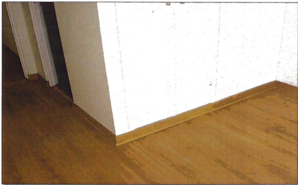
Foto 5.6: Existe una parte del poyo que se observa de color cemento.
