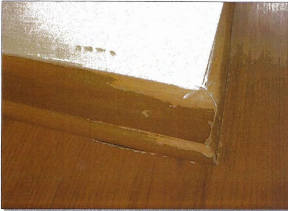
Foto 4.1: Quedo corto el piso laminado debajo del rodón.
