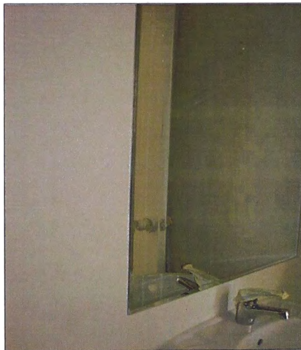
-Foto 3.2: Encuentro entre pared y espejo queda un vacío.
