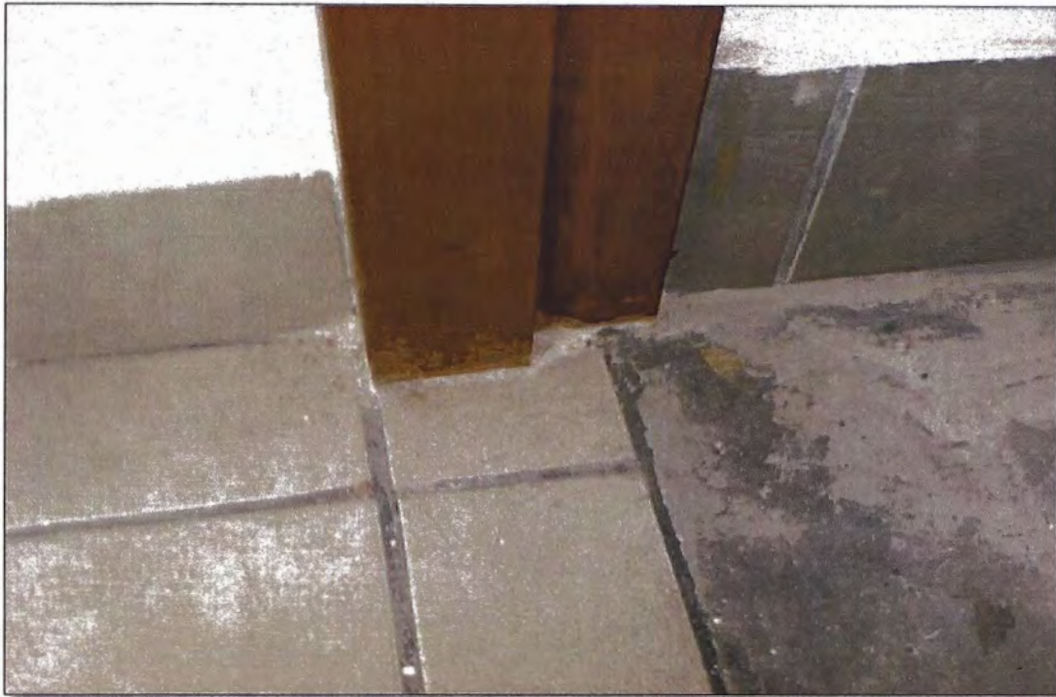
Foto 1.1: Mala terminación entre marco de madera con cerámico.
