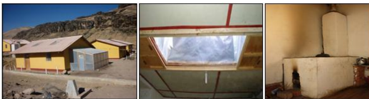
Figura 10. (Izq.) vista de casas Care Perú, (Cen.) ducto solar en el techo, (Der.) cocina mejorada. (Harman L, 2010).
