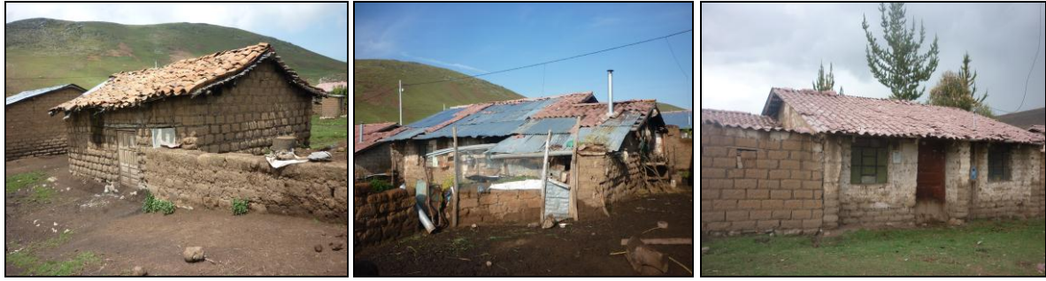
Figura 55. Vistas de algunas viviendas típicas en San Francisco de Raymina.
