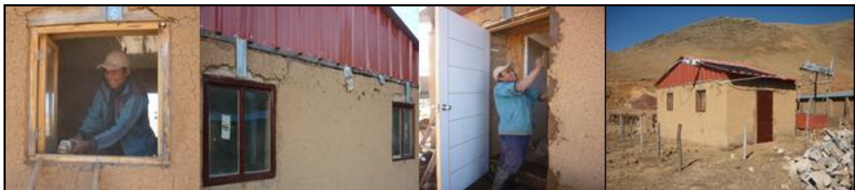
Figura 68. Vistas de las reparaciones realizadas en ventanas y puertas del MEV.
