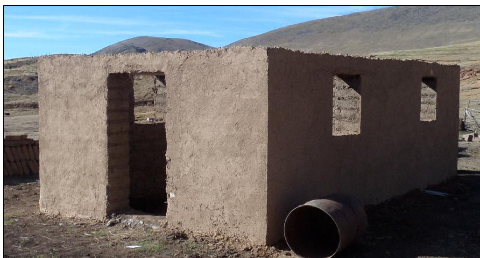
Figura 59. Vista de las paredes de adobes del MEV.
