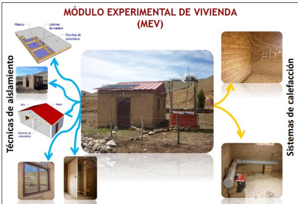
Figura 57. MEV con las técnicas arquitectónicas de aislamiento pasivo y sistemas activos de calefacción solar.
