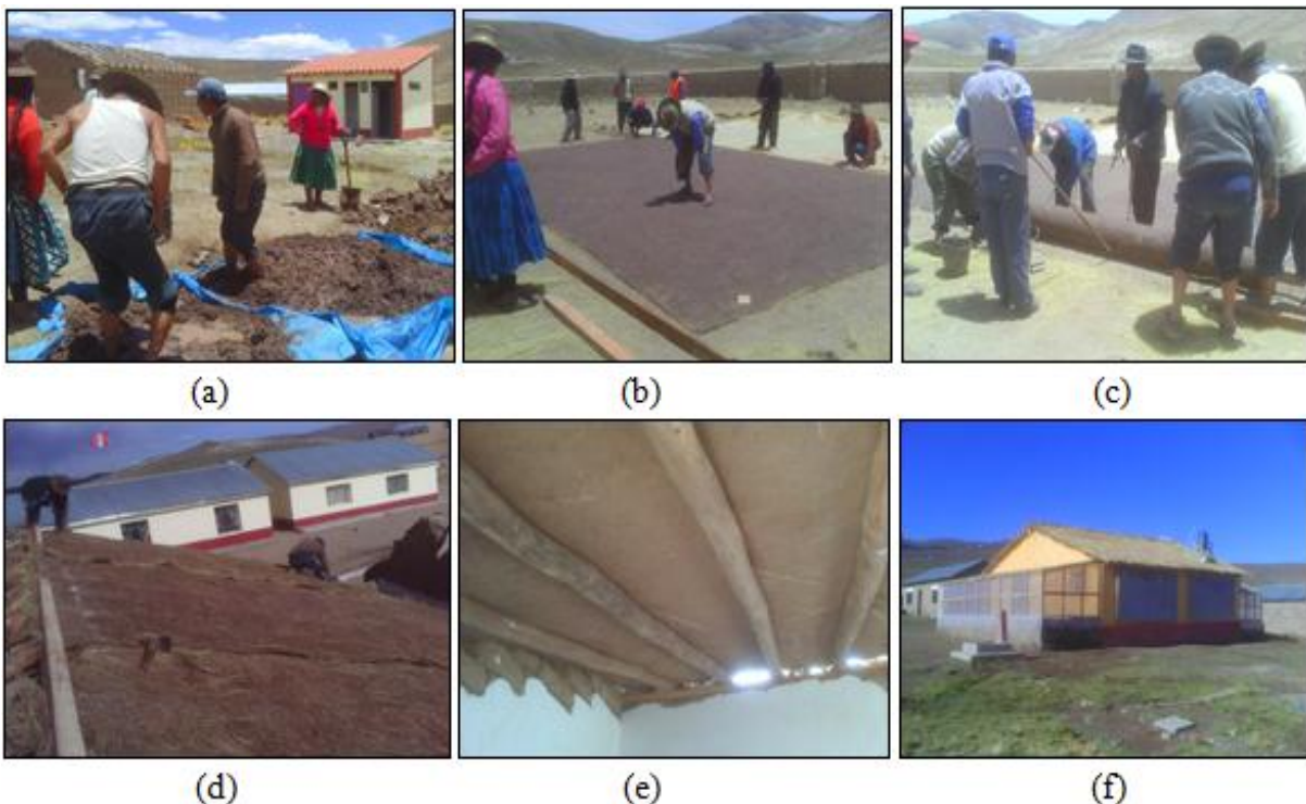
Figura 7. (a) preparación del barro, (b) manto de barro "tumbao", (c) traslado del "tumbao", (d) colocación del "tumbao", (e) vista del "tumbao" desde el interior, (f) vista de la vivienda construida en Puno.
