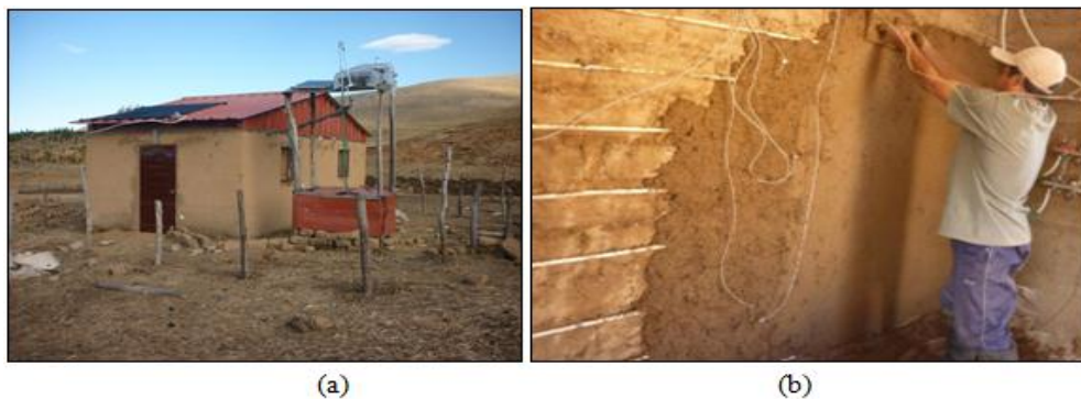
Figura 4. (a) Vista exterior del MEV. (b) Tarrajeo con barro del serpiente adosado al muro divisorio entre los ambientes del MEV.
