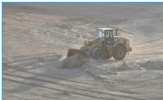
Figura 30.- Equipo Auxiliar Realizando la Preparación de Plataforma de Perforación.
