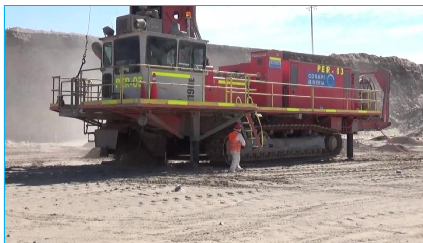
Figura 33.- Perforación Rotativa de Taladros por una Perforadora Sandvik 1190E.
