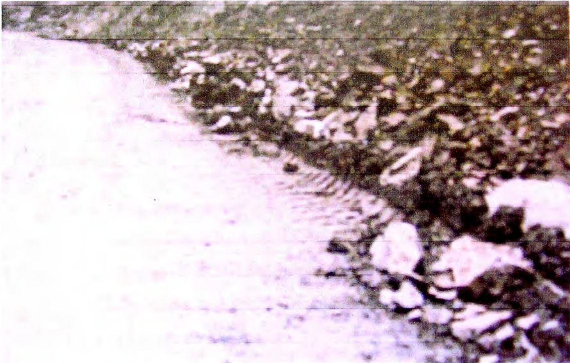
Fotografía 4.7 Vía angosta daña los neumáticos
