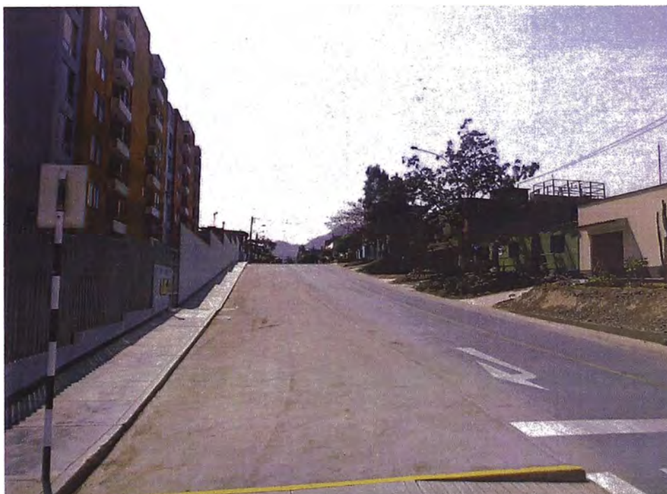
Fotos N°8 de la Av. Central cuando se terminó el Proyecto.
