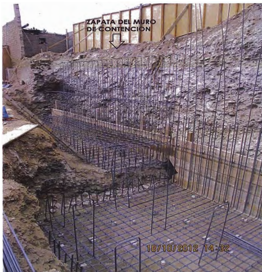
Grafico N° 3.32 – (Zapata del muro de contención).
