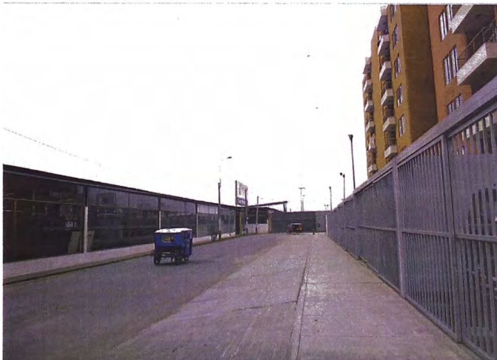
Fotos N°6 de la Av. 28 de Julio cuando se terminó el Proyecto.
