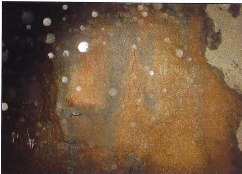
**Figura N°4.4.- Shotcrete con Fisuras. Fotografía Tomada en Hastial Izquierdo.**
