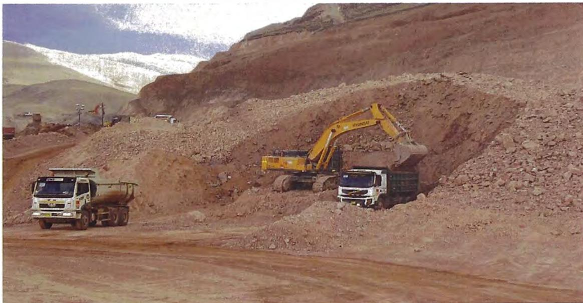
Figura 3.30. Corte y carguío de roca suelta con excavadora Hyundai RX-500.
