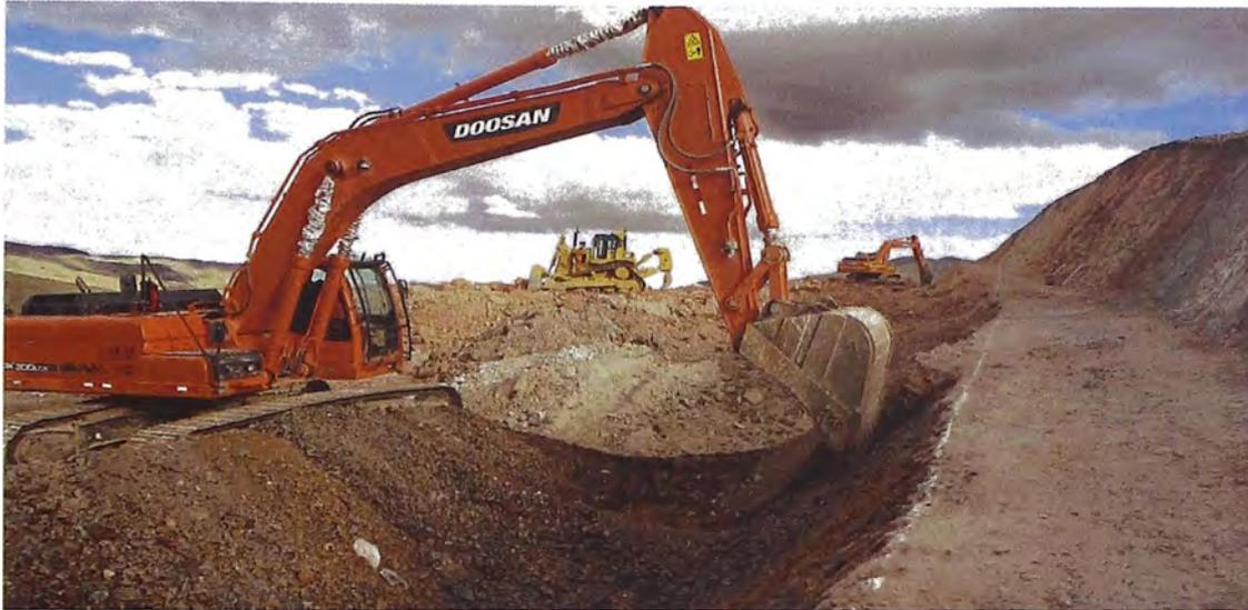
Figura 3.21. Corte con excavadoras y tractores.
