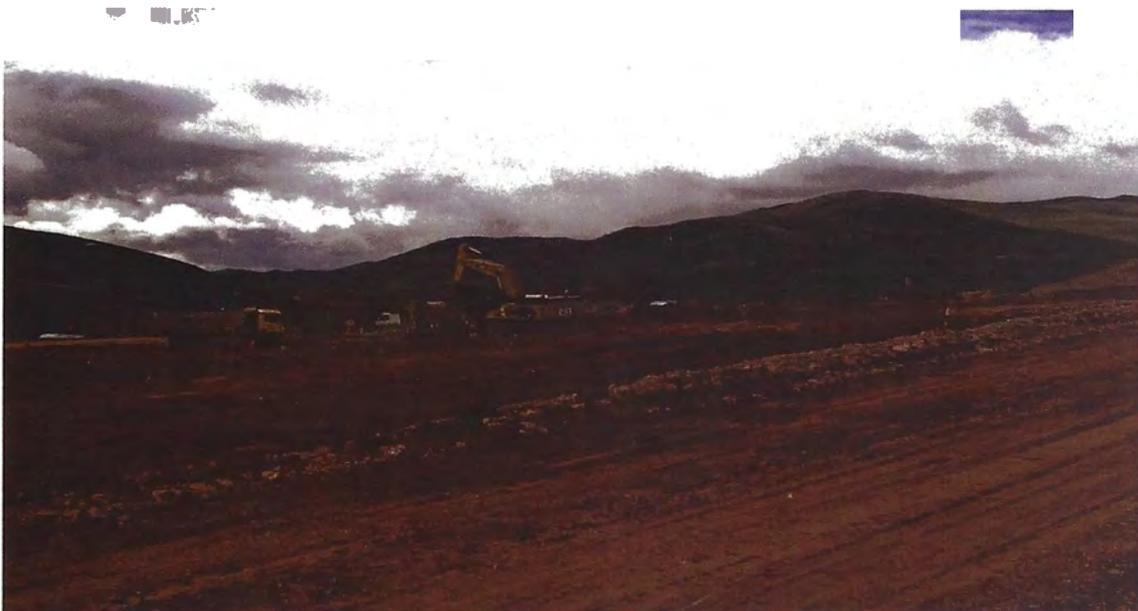
Figura 3.23. Excavación de mejoramiento por terreno no competente.
