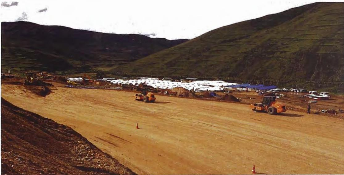
Figura 3.26. Conformación de terraplenes en áreas liberadas grandes
