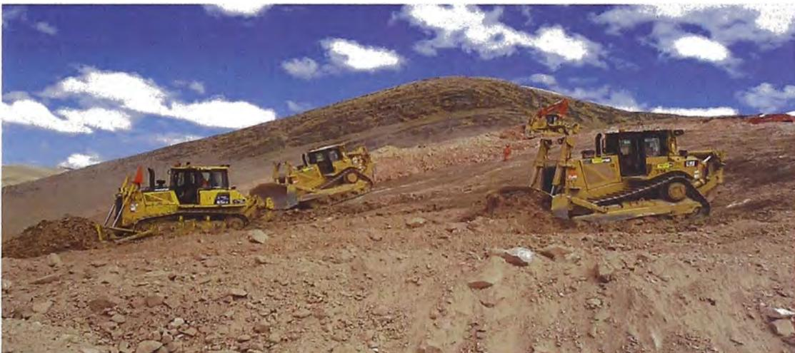
Figura 3.20. Corte inicial de terreno con tractores D8.
