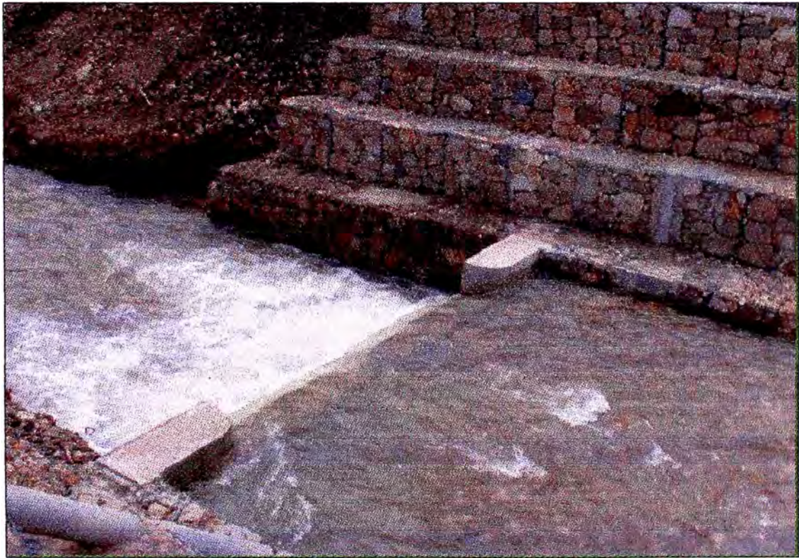
Fig 11: Vista tomada aguas arriba del vertedero.
