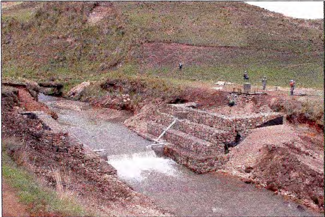
Fig 12: Vista panorámica del vertedero con el área de control de gaviones.
