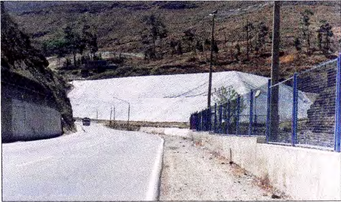
Fig 2: Cancha de Relaves 1 ( cubierta )
