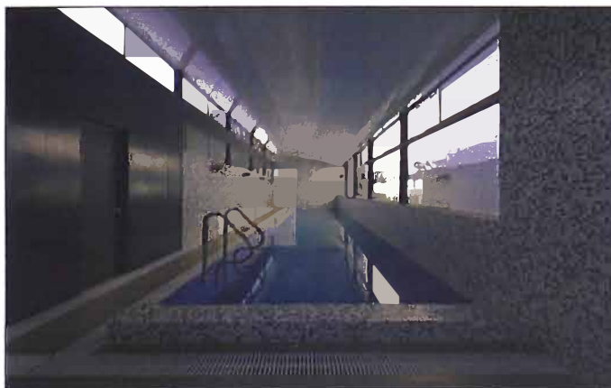
Figura 14 – Vista del ambiente de piscina
