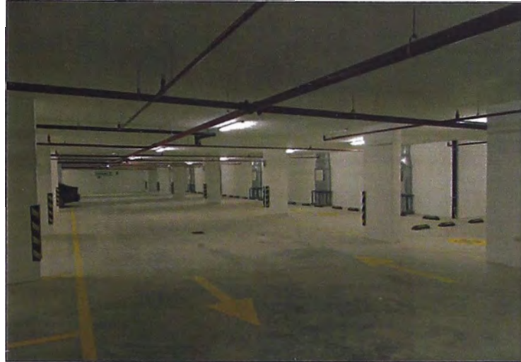
Figura 10 – Vista del sótano 01
