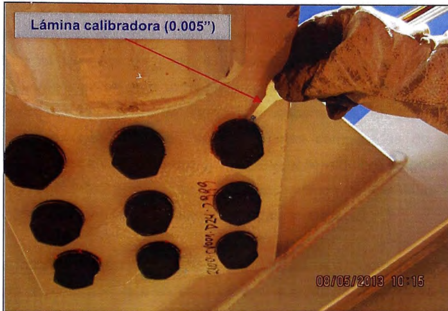
Figura N°3.22.- Inspección con una lámina o galga, de un perno pretensado con IDT Squiter
