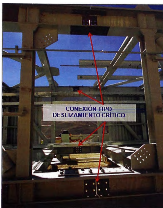
Figura N°2.14.- Conexión de tipo deslizamiento crítico
