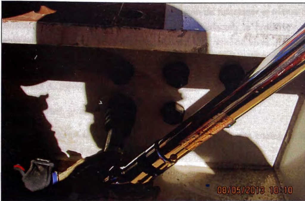
Figura N°3.7.- Acople del dado del torquímetro en el perno
