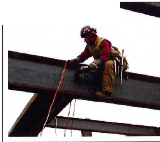
Figura N°2.8.- Conexión con apriete ajustado – Usando llave de impacto
