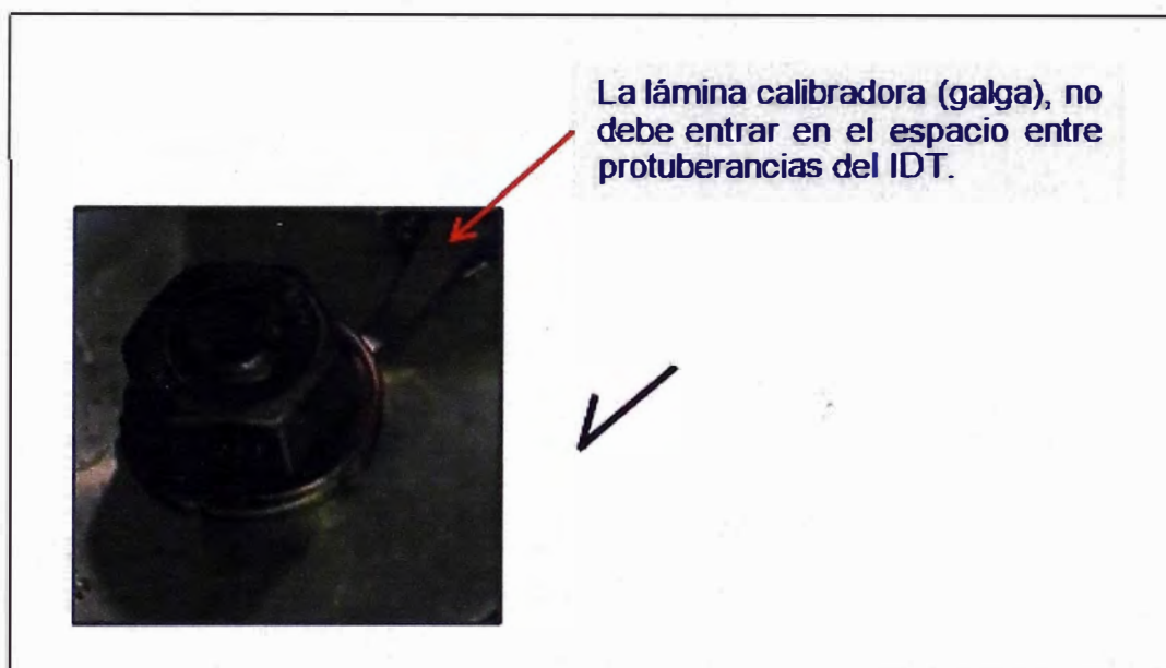
Figura N°3.15.- Inspección de instalación con lámina calibradora (galga)
