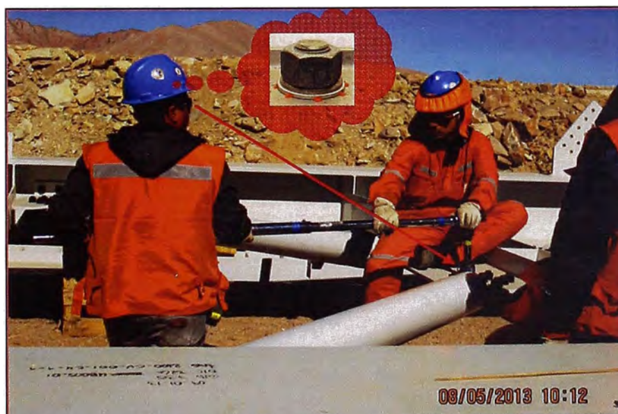
Figura N°3.21.- Pretensión del perno con IDT “Squirter”
