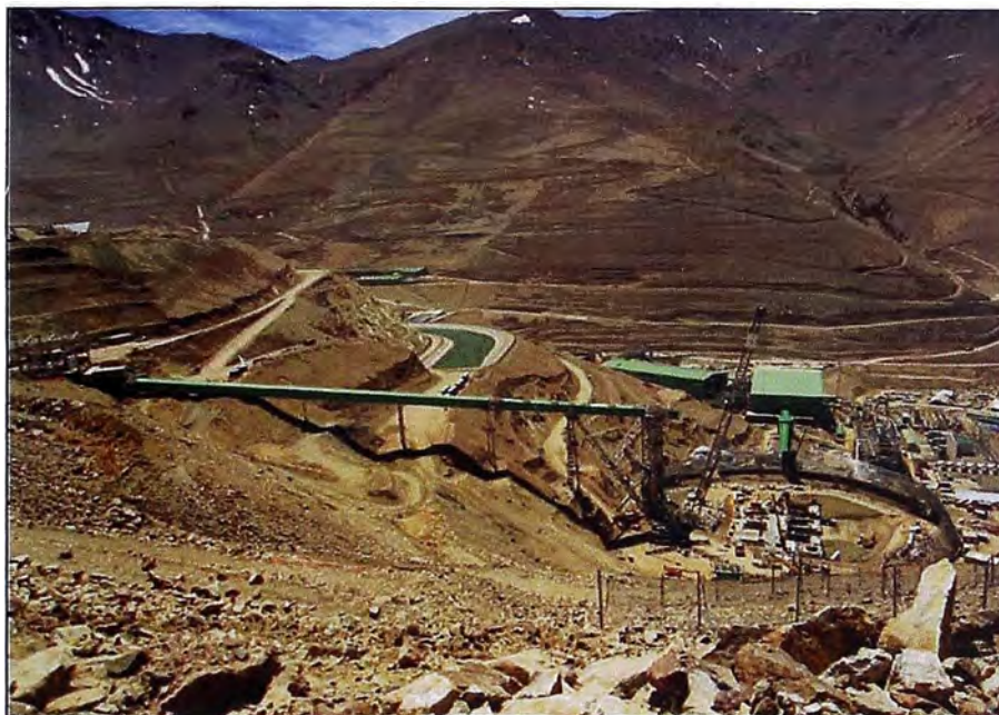
Figura N°A-13.- Vista Panorámica – Estructura total para correa transportadora (Overland)
