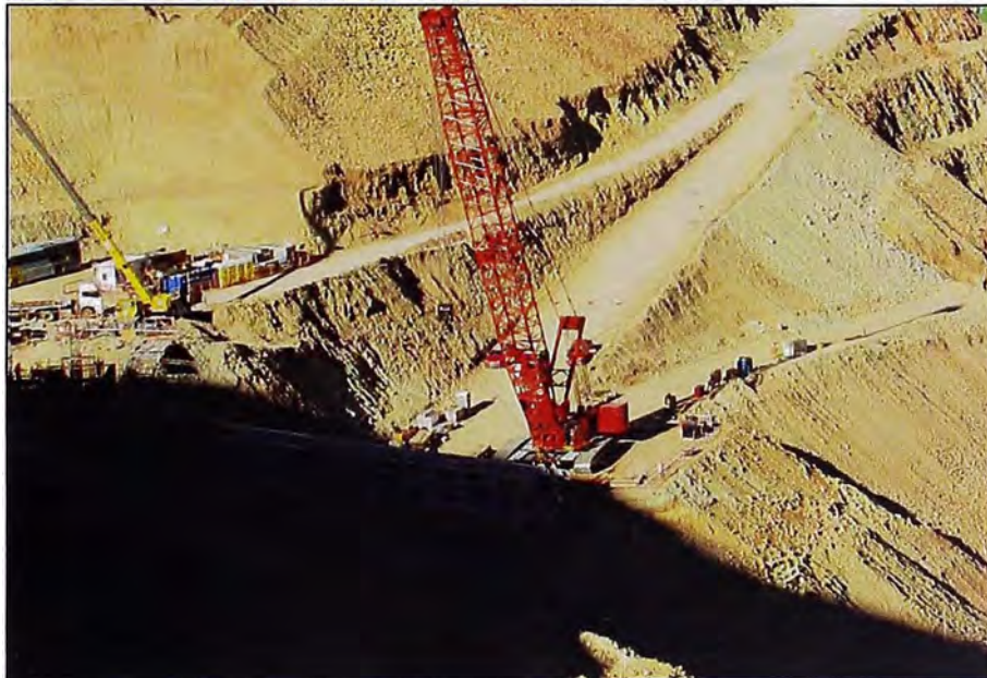
Figura N°A-10.- Montaje de una galería para la correa transportadora
