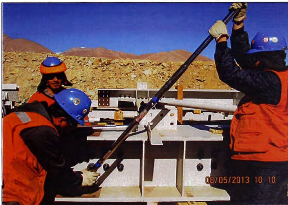
Figura N°3.8.- Pretensado del perno con torquímetro mecánico
