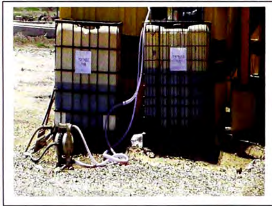
Tanque de almacenamiento de los Aditivos, en este caso Polyheed 770 R de Basf
