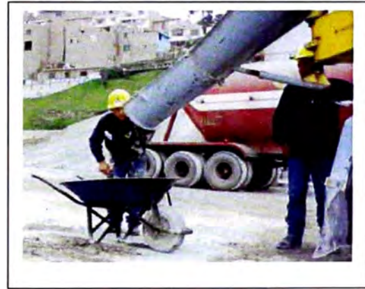
Después del carguío se extrae un bugui de mezcla para hacer las pruebas al concreto fresco
