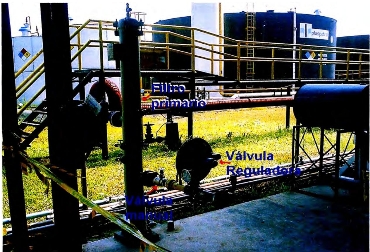
**Figura N° 4.18 Instalación del filtro primario y la válvula reguladora**
