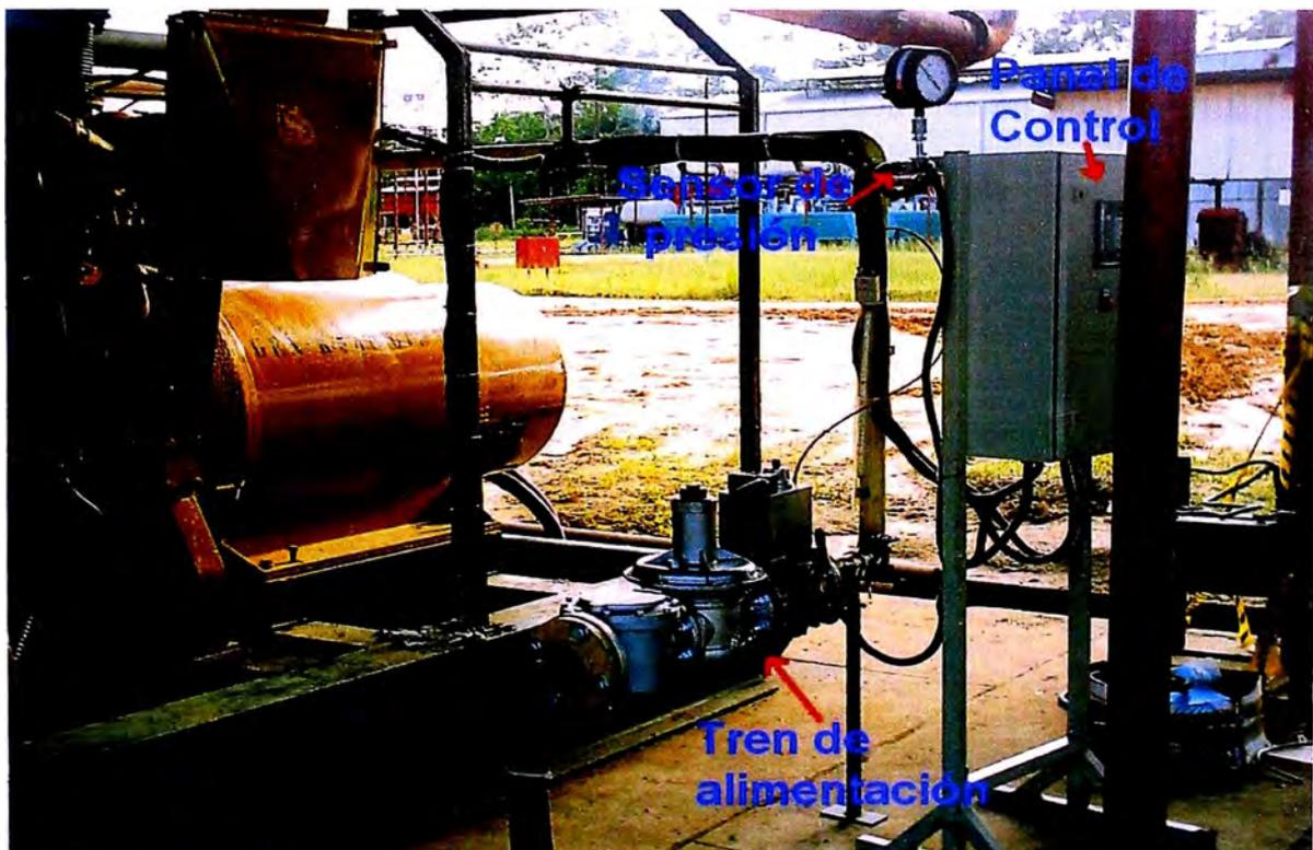
**Figura N° 4.19 Instalación del tren de alimentación de gas**
