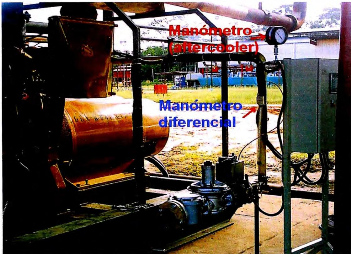
**Figura 5.1 Conexión del manómetro diferencial**
