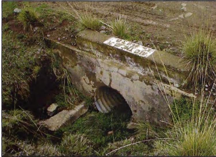
**Foto 03** Se observa una alcantarilla tipo TMC de 24", la cual se reemplazará por una tipo TMC de 48" con un cabezal a la salida con aleros abiertos.
