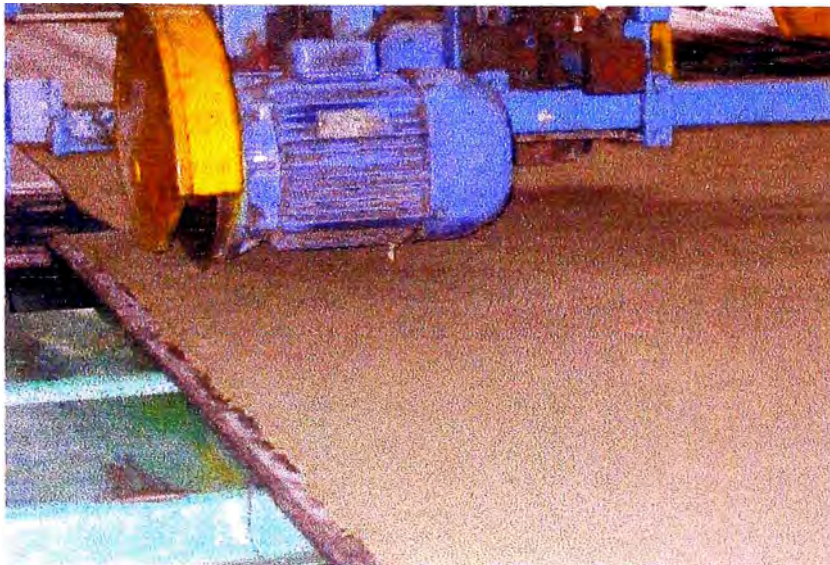
Figura 7.2 – Maquina Apiladora en funcionamiento.
