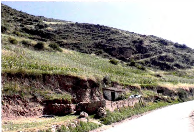
Figura N°2.6.- Muro Tapial, ubicado en Km. 0+050, afectado por los límites del Derecho de Vía
