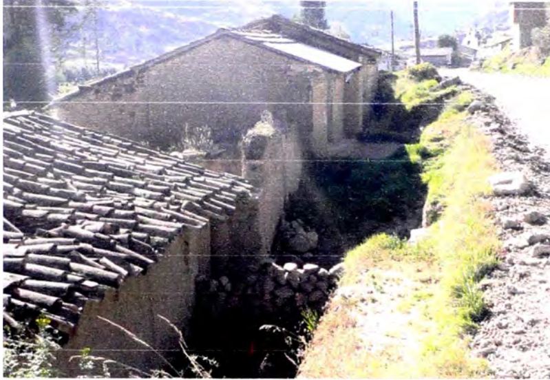
Figura N°2.3.- Vivienda ubicada en Km. 0+265, afectada por ensanche de plataforma
