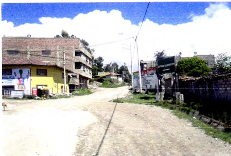
Figura N°2.2.- Fin del Tramo (Km. 16+300)
