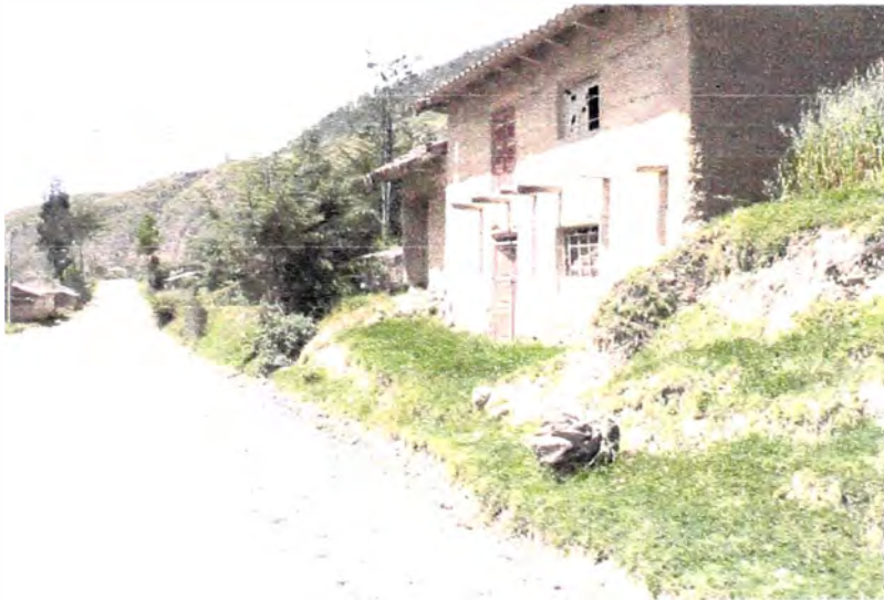
Figura N°2.4.- Vivienda ubicada en Km. 6+550, afectada por trabajos de ampliación de la plataforma
