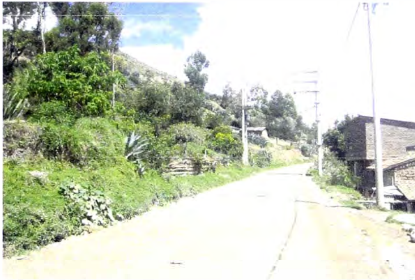
Figura N°2.09.- Postes ubicados dentro del Derecho de Vía, km 15+900 - Km.16+500
