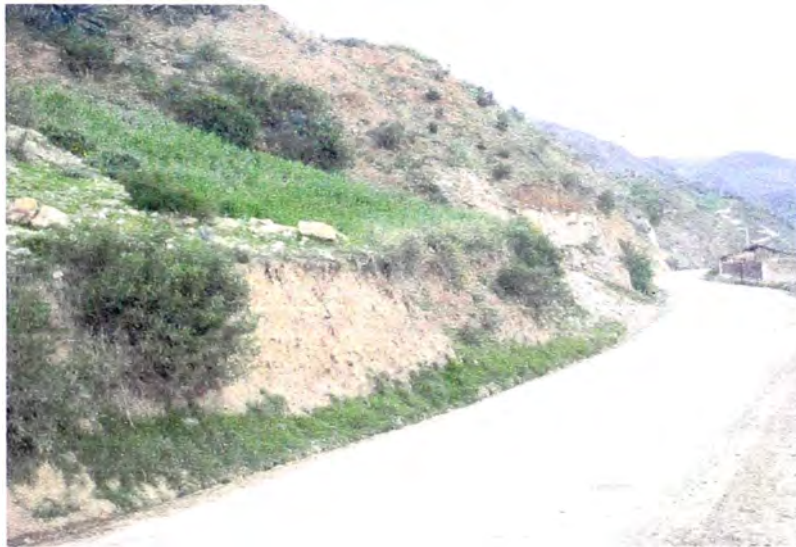
Figura N°2.8.- Cultivos, ubicados en Km. km. 8+020, afectados por corte de talud en la ampliación de la plataforma
