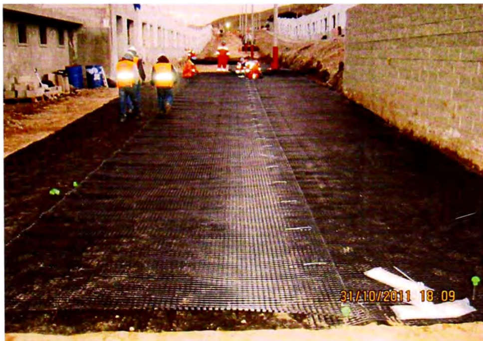
Figura 3 4 - Colocación de geomalla sobre geotextil
