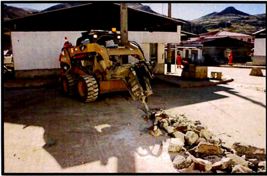
Picado de pavimentos fisurados – Calle 5
