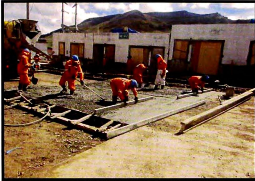
Vaciado de pavimento – Av. Principal
