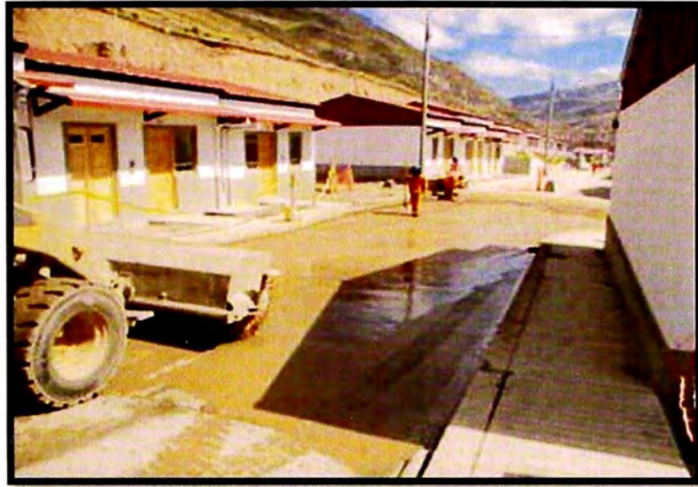
Limpieza de pavimento – Calle 8
