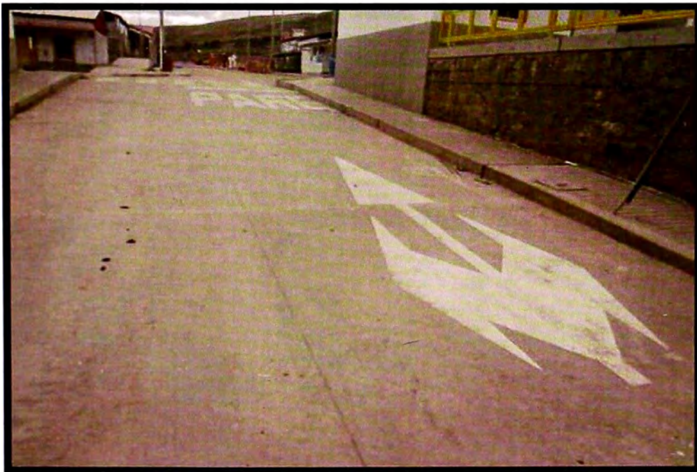
Pintado de pavimento – Calle 6
