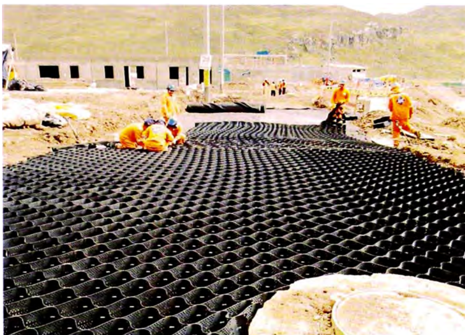
Figura 3.3 - Colocación de geoweb sobre geotextil
