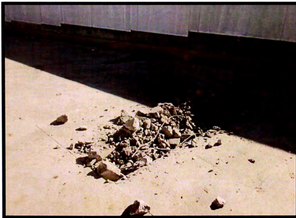
Escarificación de pavimento para reparación de fisuras – Calle 3
