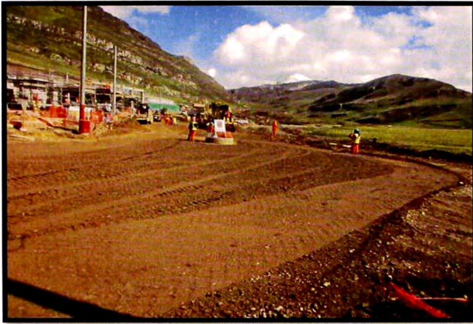
Conformación del terreno de fundación – Av. Principal
