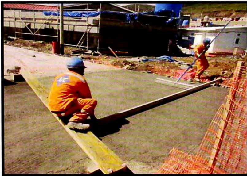
Texturado de pavimento – Calle 1
