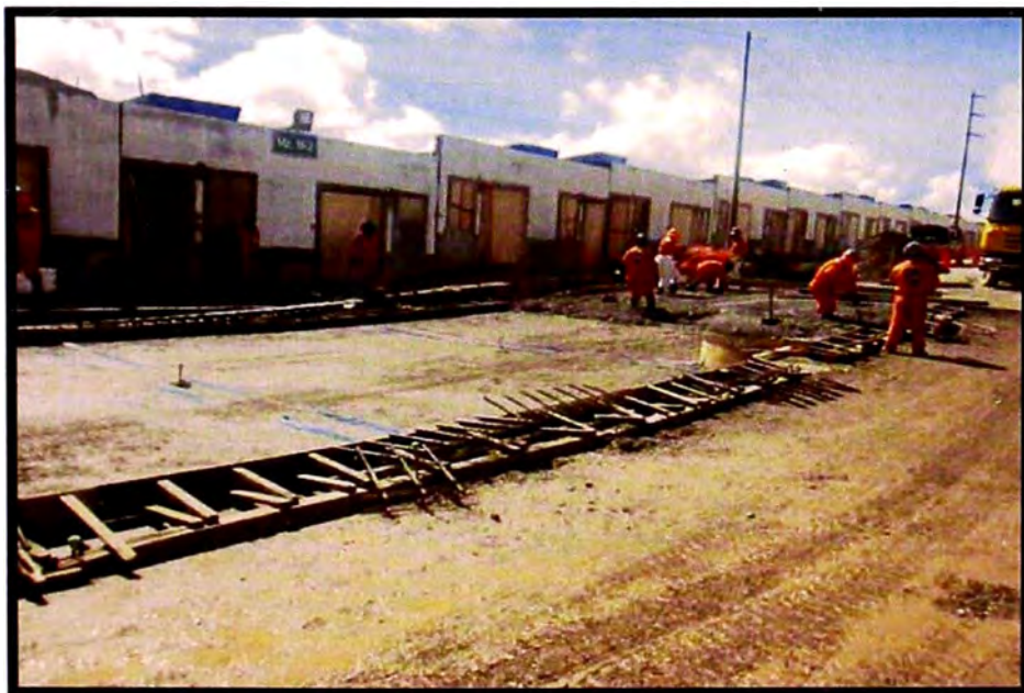
Encofrado para vaciado de pavimento Carril Izquierdo – Av. Principal
