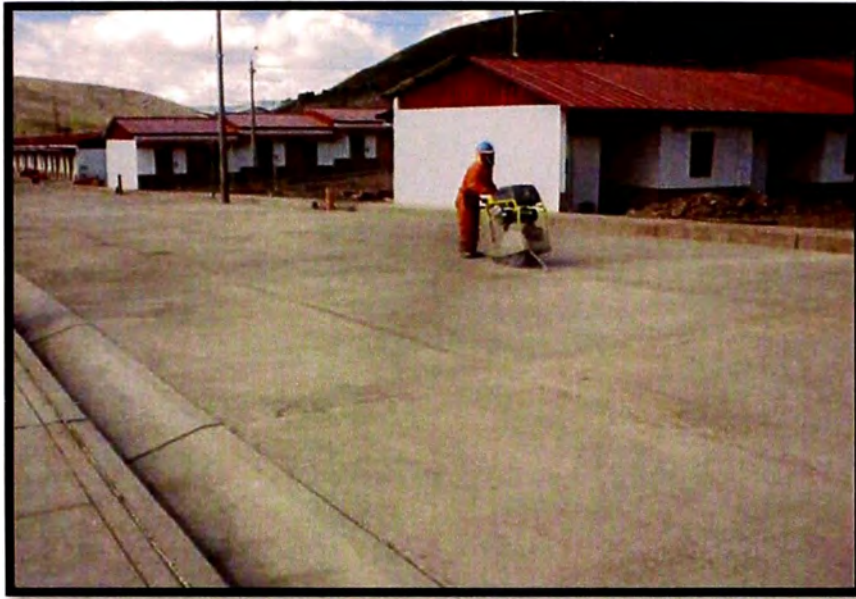
Corte de pavimento – Calle 10
