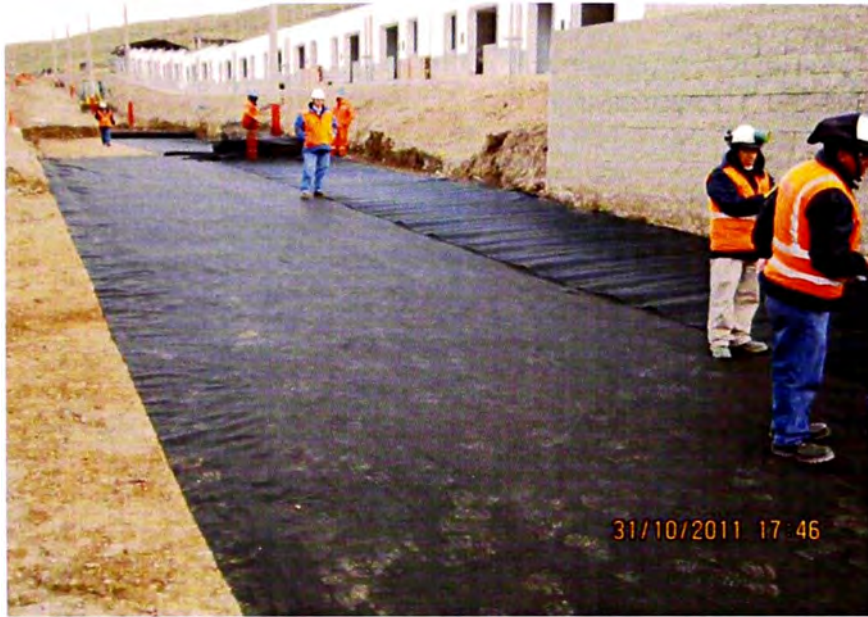
Colocación de geomalla sobre geotextil – Calle 6
