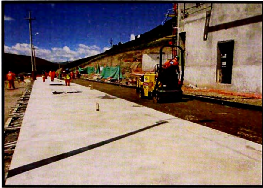
Compactación del firme – Av. Principal (coliseo)
