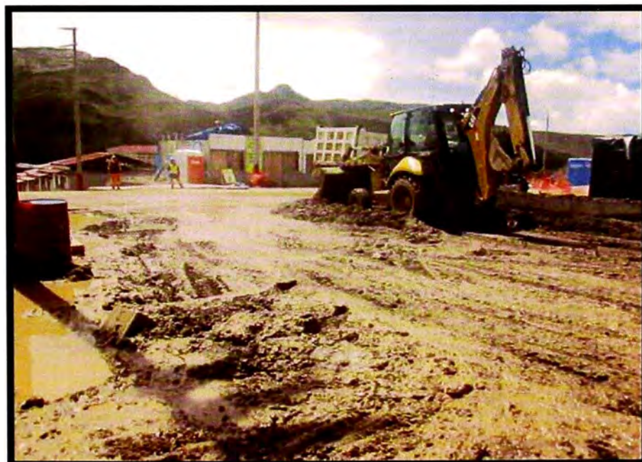
Eliminación de material saturado para conformación del terreno de fundación – Calle C
