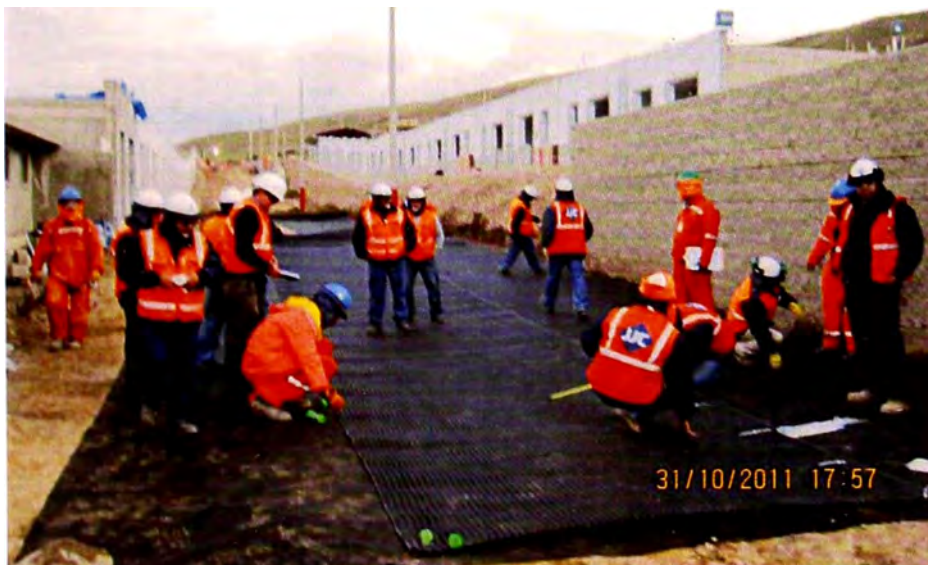
Revisión con supervisión del procedimiento de colocado de geomalla – Calle 6
