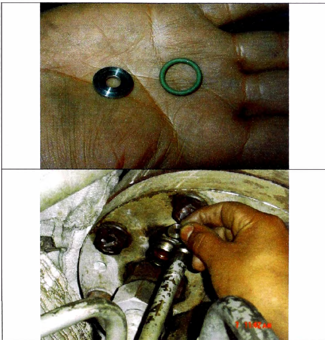
Figura 59: Instalación de placas orificio en las tuberías de gas piloto
