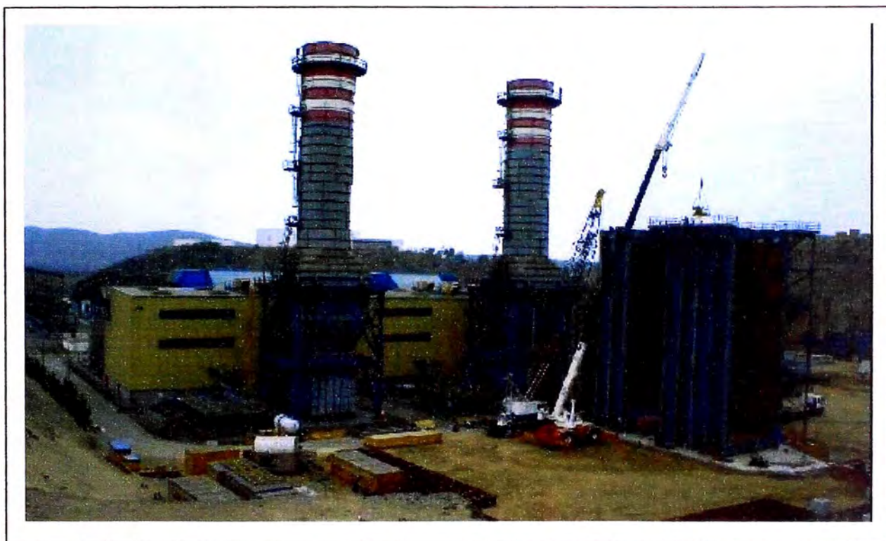
Figura 14: Proyecto de Ciclo Combinado – Avance de Obras
