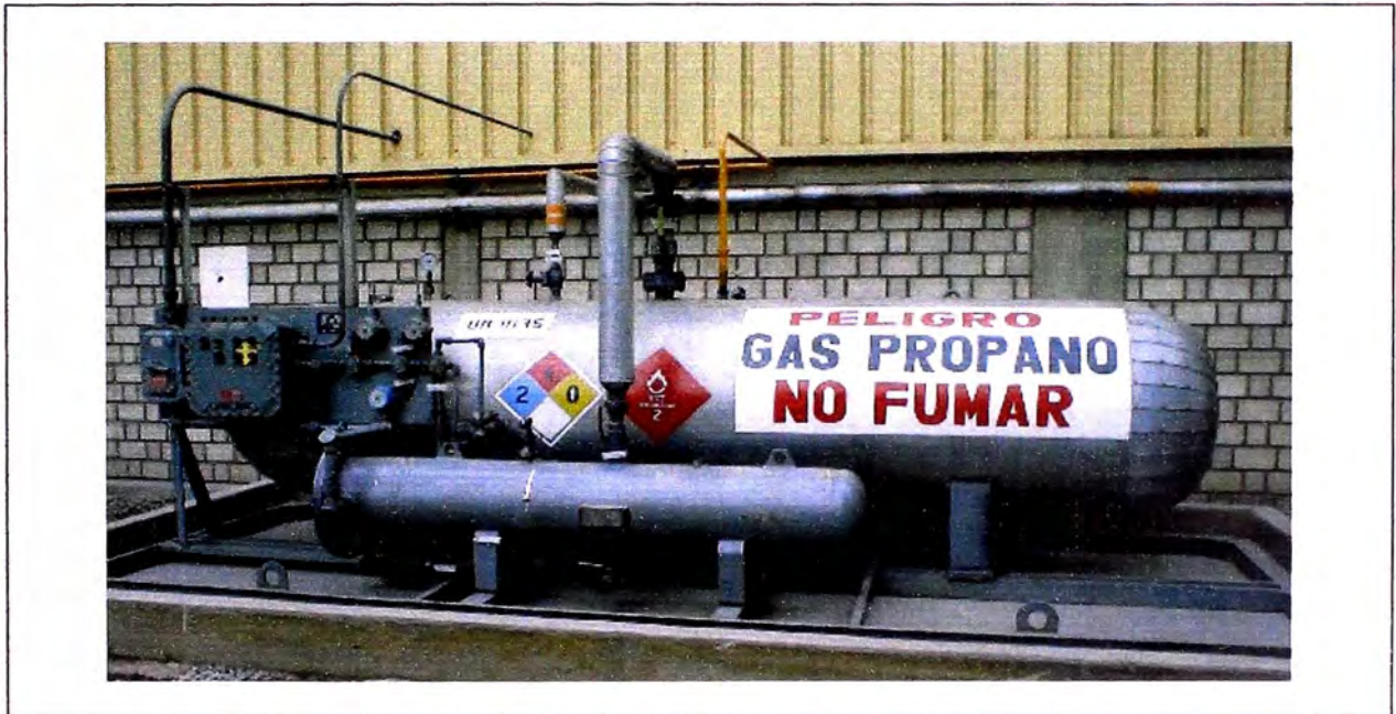
Figura 08: Sistema de Ignición de Combustible
