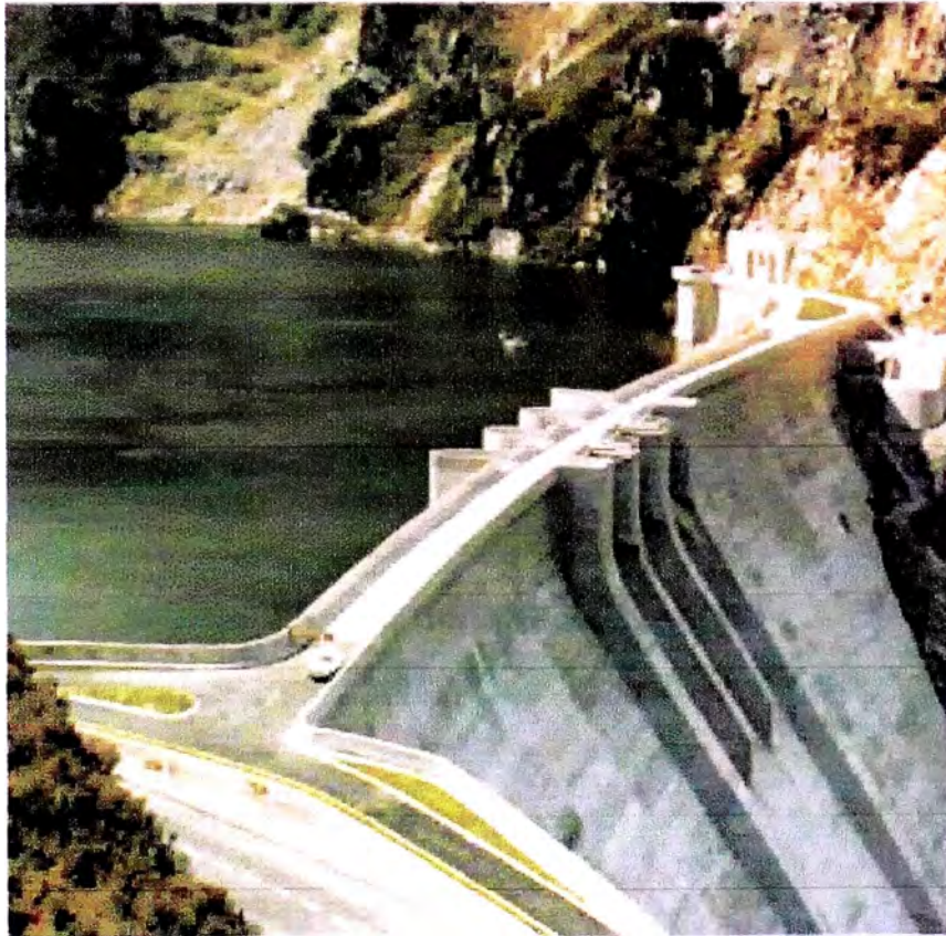
Fig.2.4. Central de agua embalsada
