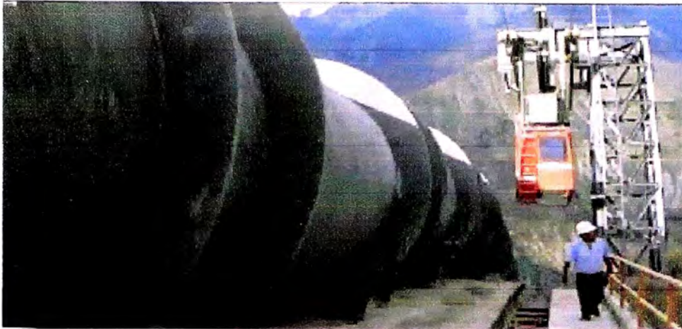
Fig.3.6. Obras de mantenimiento
