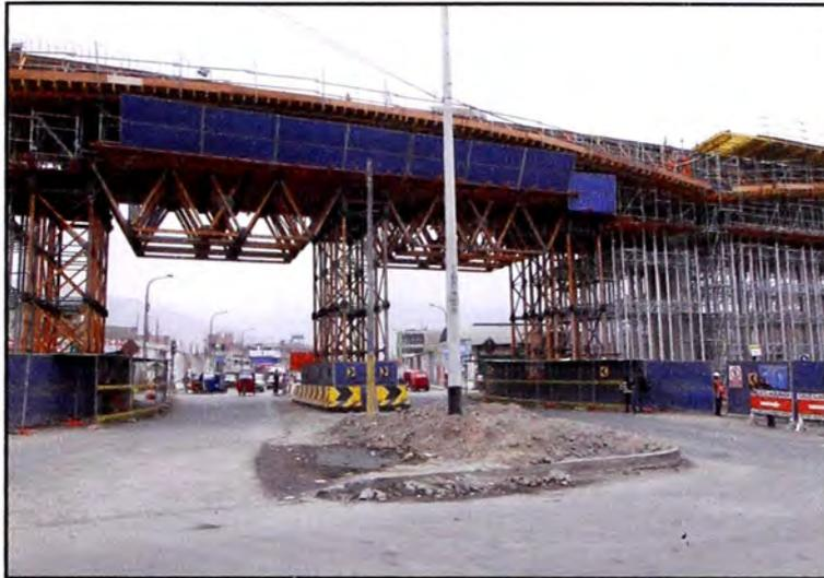
Foto N°10.- Soporte de losa inferior: Falso puente MK, torre Aluprop y cimbra Brio.
