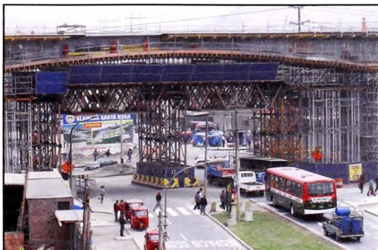
Foto N°12.- Losa inferior, hastiales y losa superior vaciados.
