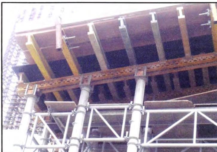
Foto N°15.- Detalle de unión entre vigas VM20 y riostras MK sobre torre Alupro.
