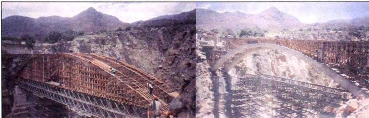
**Figura N°1.2.- Soporte y encofrado de madera. Puente "Tsejtsi"- Huancavelica.
