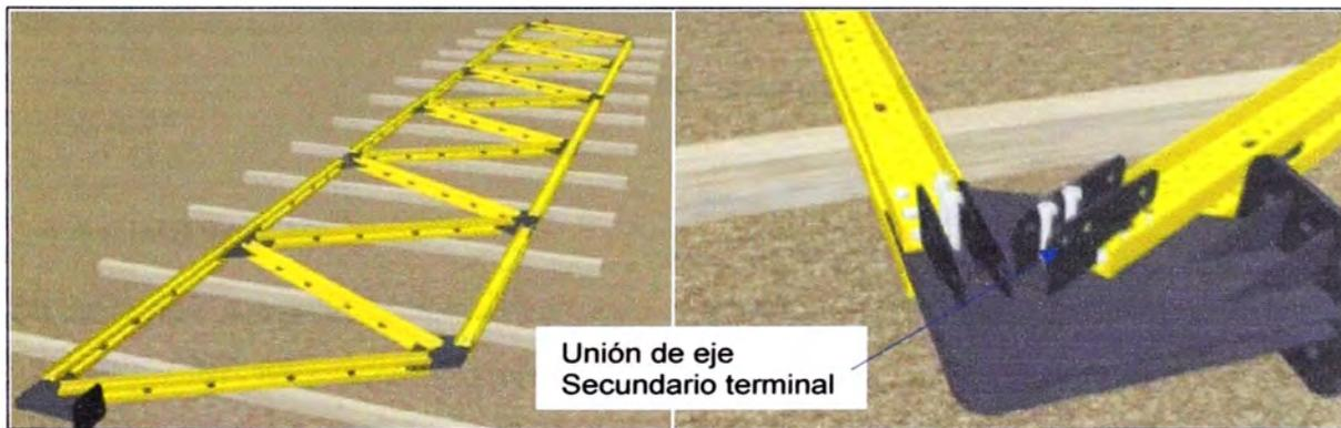
Figura N°3.56.- Colocación de elementos de unión.
