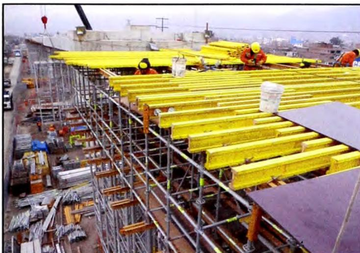
**Foto N°07.- Encofrado de losa inferior (Paneles, Vigas VM20, riostras MK) sobre cimbra Brio.**
