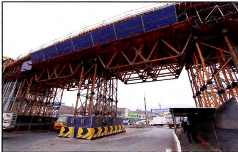
Foto N°11.- Soporte de losa inferior (lado opuesto).
