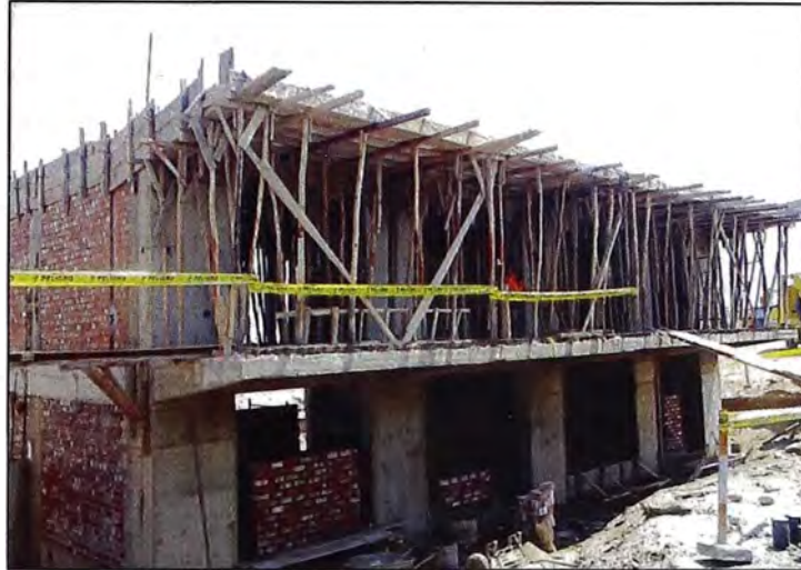
Figura N°3.12.-Vista de uno de los módulos del proyecto. Fuente propia.
