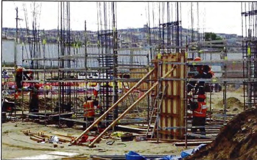
Figura N°3.16.-Operarios trabajando en la obra. Fuente propia.
