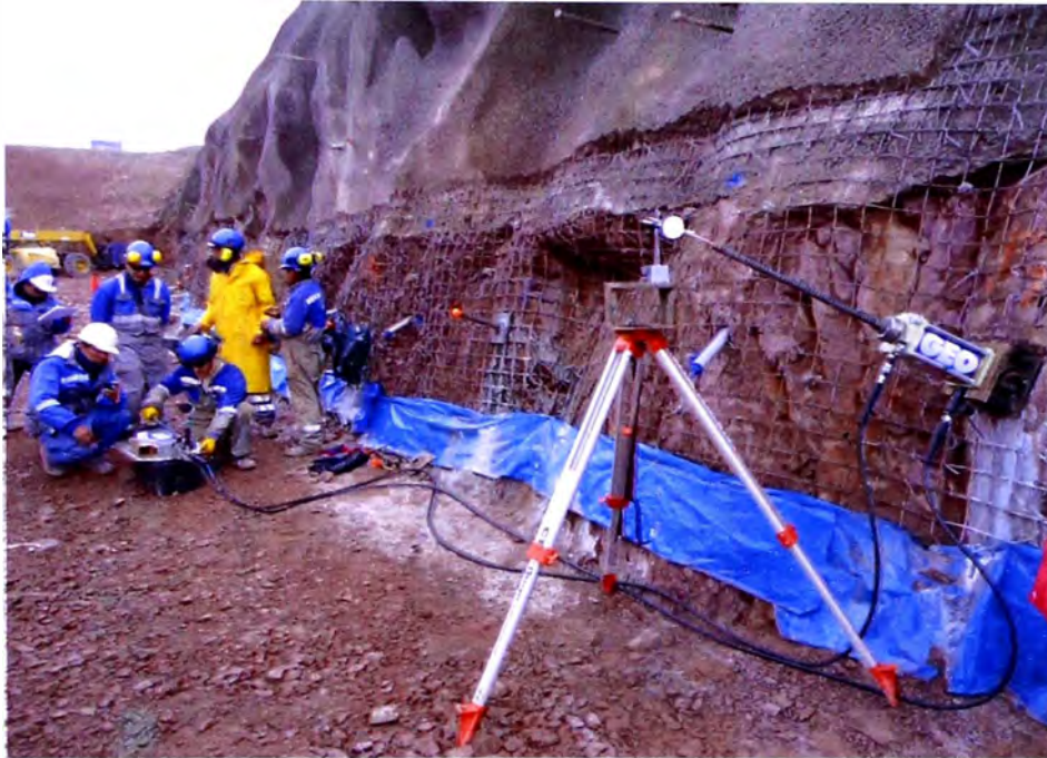
Figura N°4.32.- Ensayo de tensionamiento y relajación de carga.
