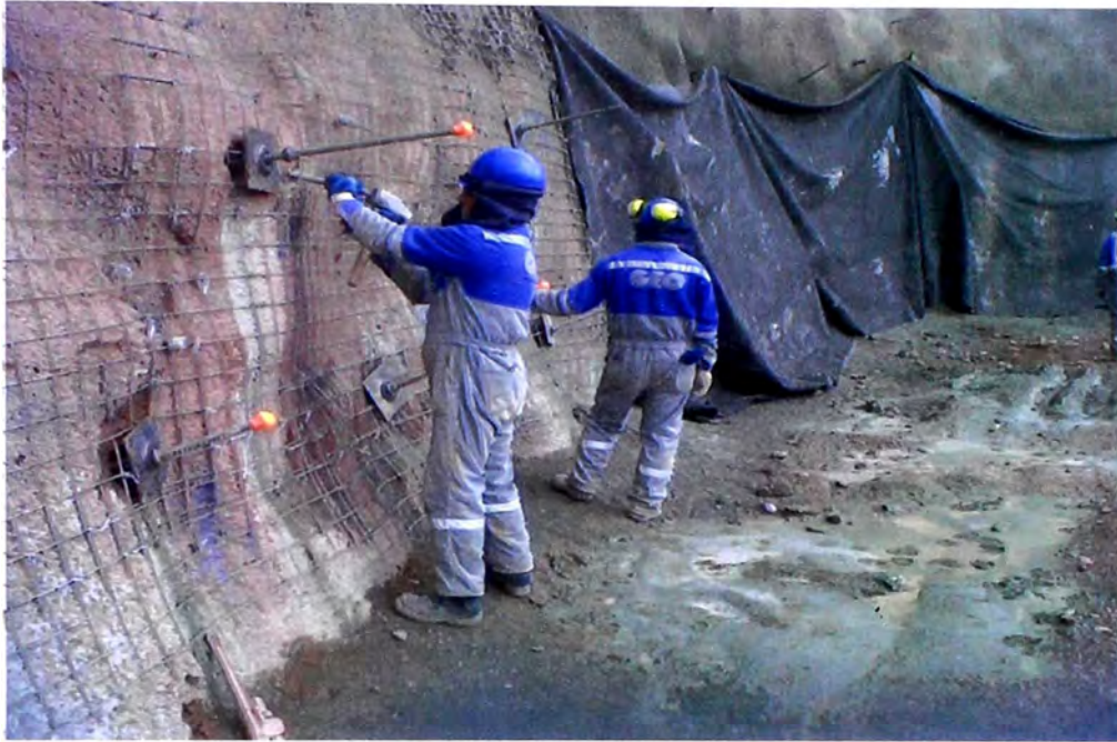
Figura N°4.18.- Colocado de planchuelas y tuercas (Zona B1b).
