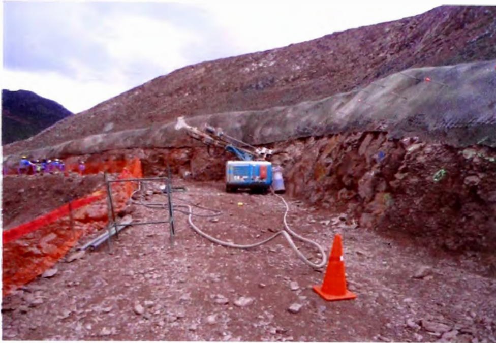
Figura N°4.8.- Perforación sobre terreno natural (Zona B1b)
