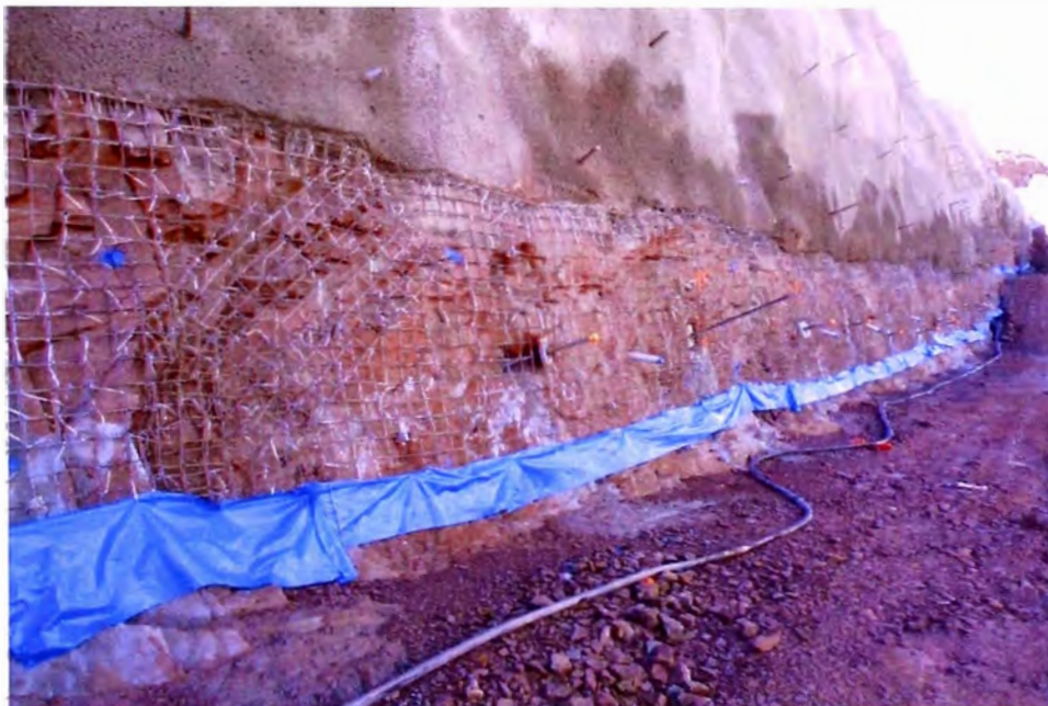
Figura N°4.21.- Talud listo para recibir una sola capa de shotcrete de 50mm (Zona B1b)
