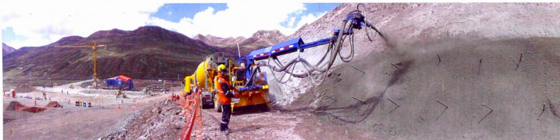
Figura N°4.23.- Primera capa de shotcrete (Zona B1b)
