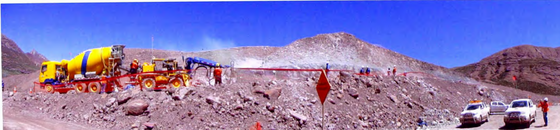
Figura N°4.22.- Inicio de la partida del shotcrete (Zona B1b)
