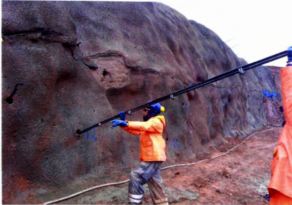
Figura N°4.13.- Colocación del perno sobre Shotcrete de la 1° capa (Zona B3b) Fuente: Elaboración propia
