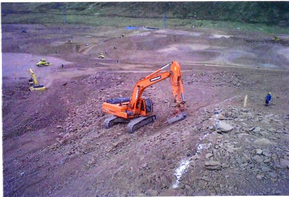
Figura N°4.1.- Corte del talud (Zona B1b).
