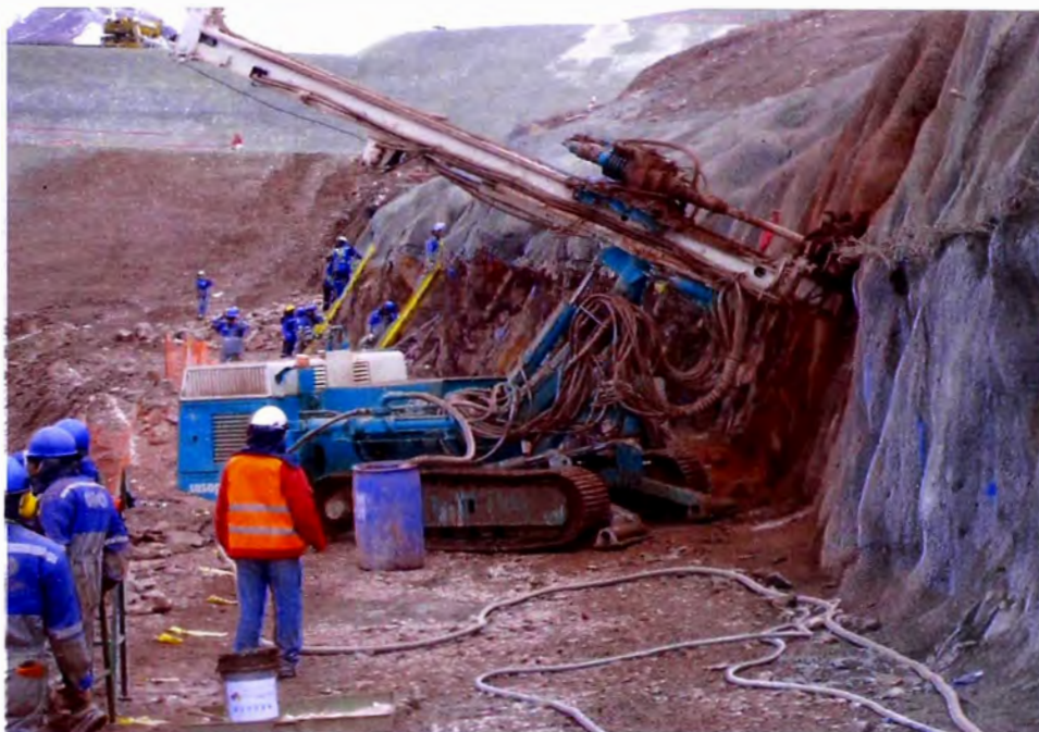
Figura N°4.9.- Perforación sobre 1° capa de Shotcrete del 2° nivel (Zona B3a)
