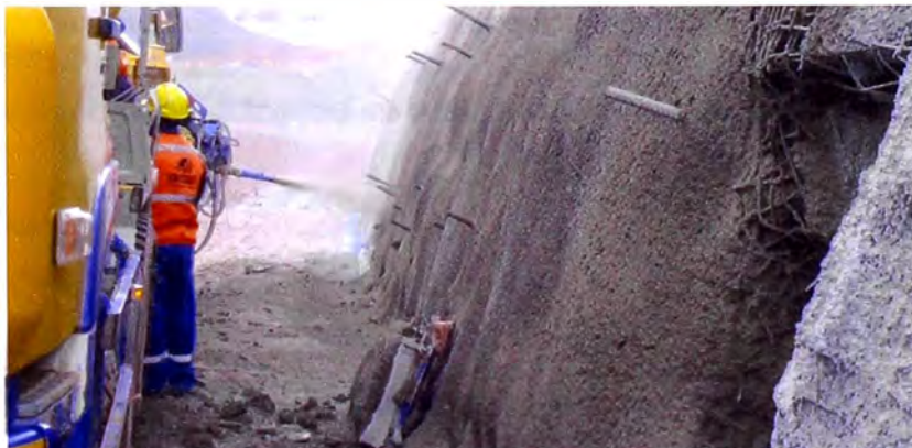
Figura N°4.30.- Muestra de Shotcrete insitu.
