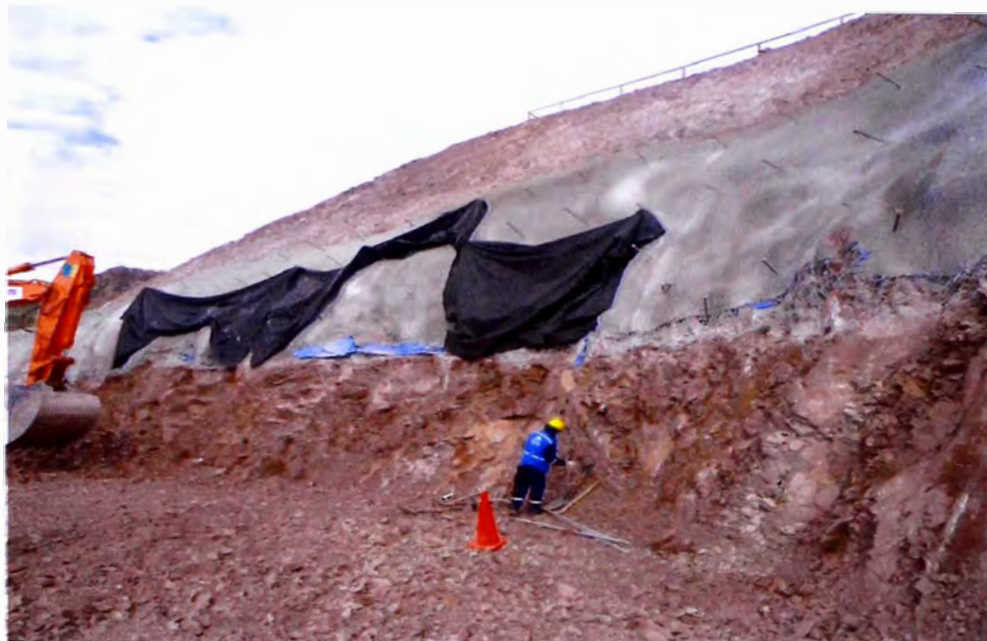
Figura N°4.4.- Desquinchado del Segundo nivel (Zona B1b)
