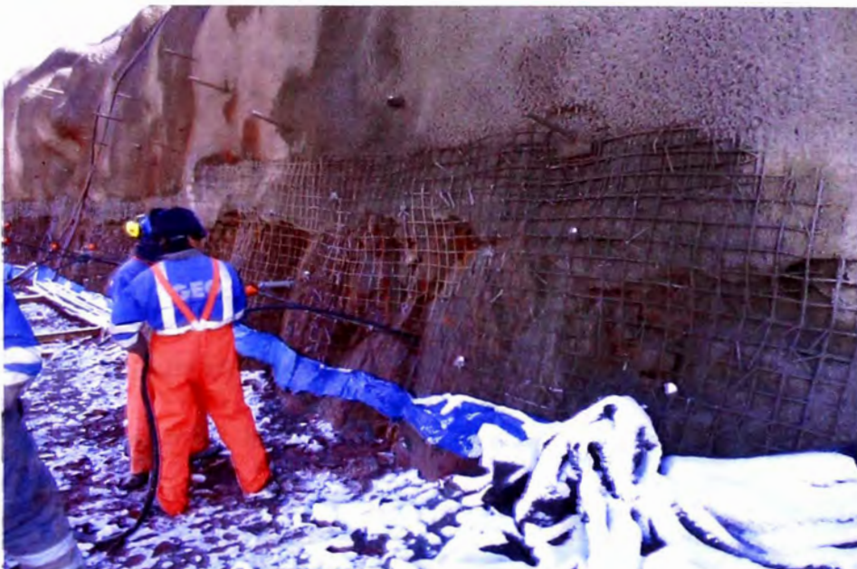
Figura N°4.15.- Inyección del taladro a través de un conductor instalado en el perno (Zona B3a).
