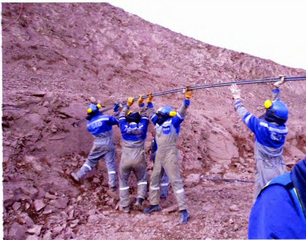
Figura N°4.12.- Colocación del perno (Zona B1b)
