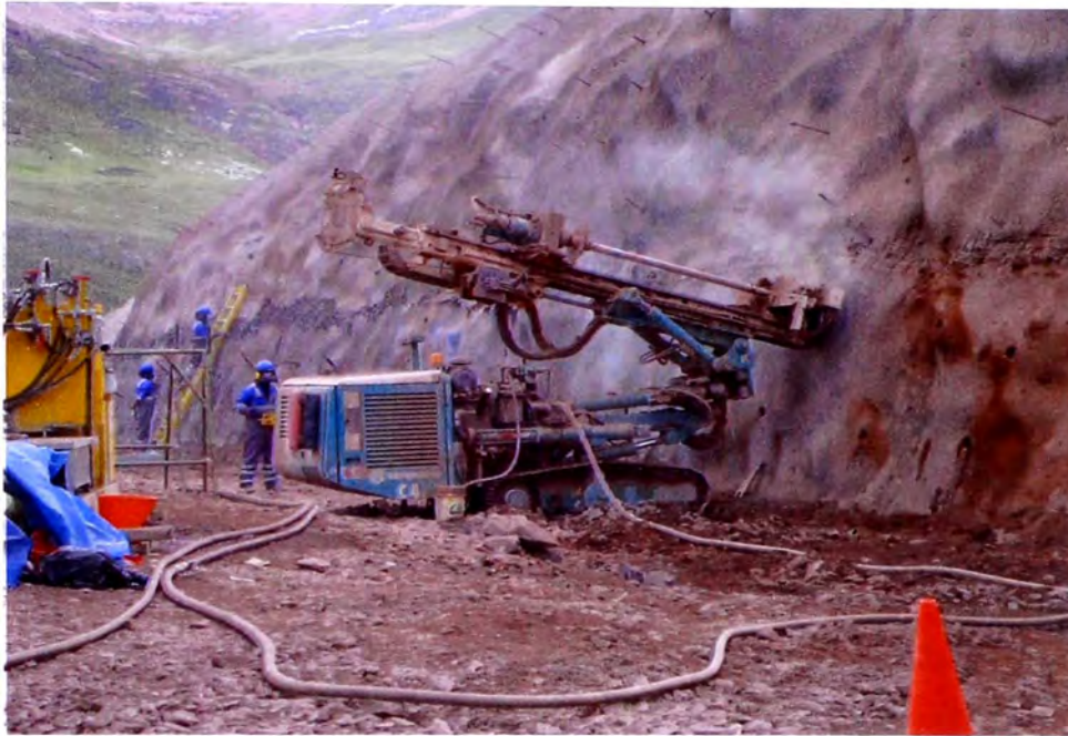
Figura N°4.10.- Perforación sobre 1°capa del Shotcrete del 5° nivel (ZonaB1b) Fuente: Elaboración propia
