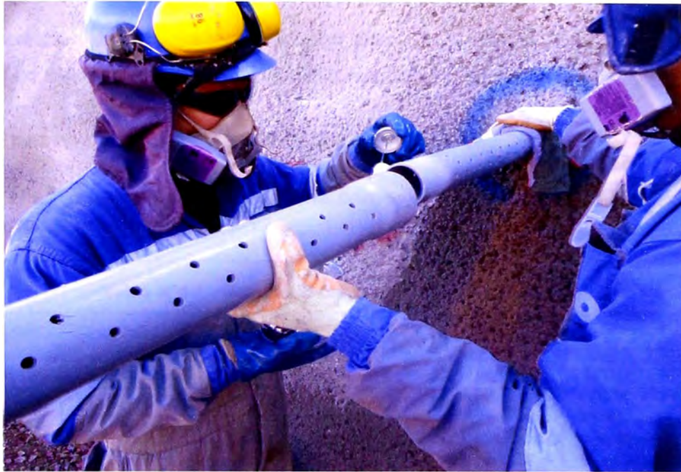
Figura N°4.27.- Colocado de la tubería de PVC para el DHP (Zona B1b)
