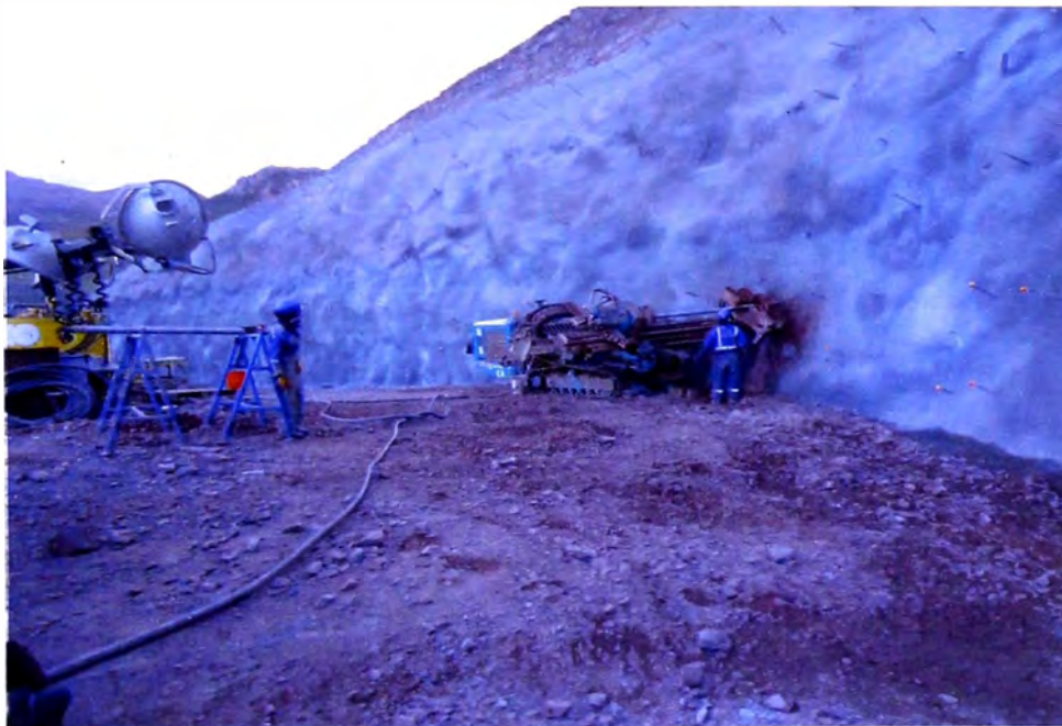
Figura N°4.11.- Perforación para el DHP del 5° nivel (Zona B1b) Fuente: Elaboración propia
