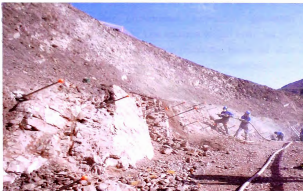
Figura N°4.5.- Limpieza de talud con aire a presión (Zona B1b)
