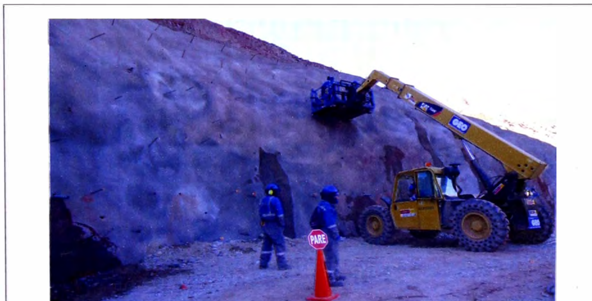
Figura N°4.37.- Extracción de muestra por diamantina (Zona B1b).
