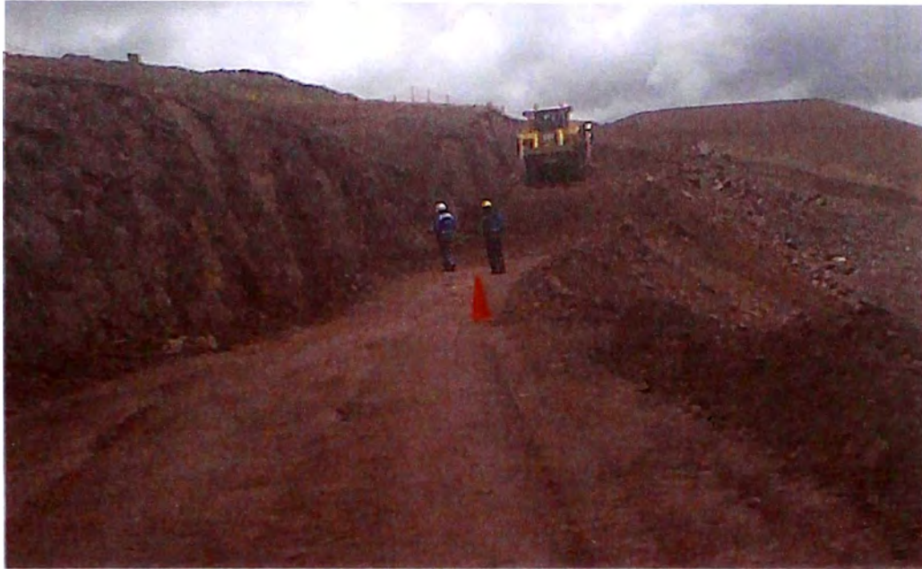
Figura N°4.2.- Habilitado de la plataforma de trabajo (Zona B3b)
