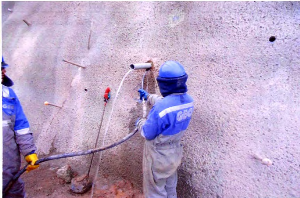
Figura N°4.28.- Limpieza del DHP (Zona B1b)
