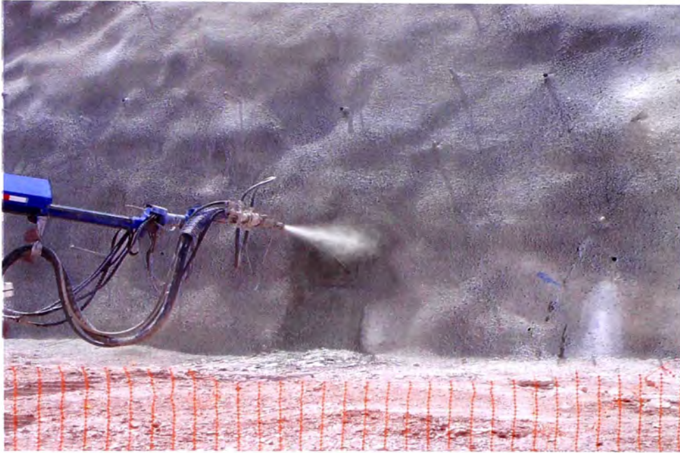
Figura N°4.24.- Colocado de la segunda capa del shotcrete (Zona B1b)
