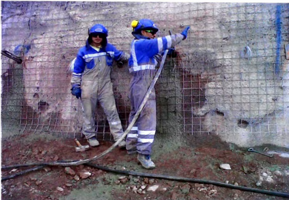
Figura N°4.16.- Reinyección a través del agujero de ingreso del perno
