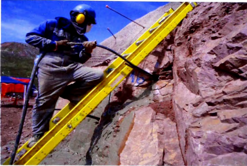
Figura N°4.14.- Inyección del taladro a través de un conductor instalado en el perno (Zona B1b).
