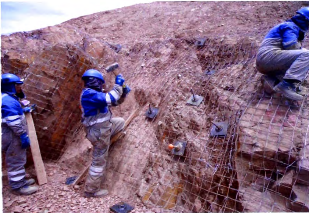
Figura N°4.17.- Reacomodo y colocado de malla (Zona B1b).
