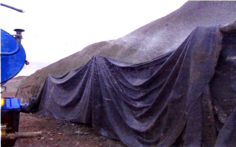
Figura N°4.25.- Curado y cuidado del shotcrete con geotextil (Zona B1b)
