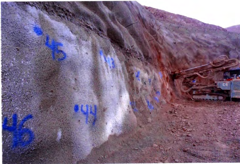
Figura N°4.7.- Ubicación de malla de perforación (Zona B1b)
