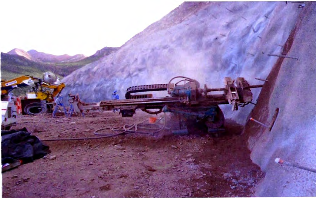
Figura N°4.26.- Perforado del DHP (Zona B1b)
