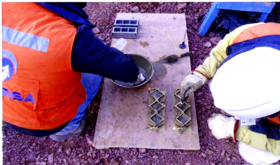
Figura N°4.29.- Muestra de lechada de cemento (Grouting).
