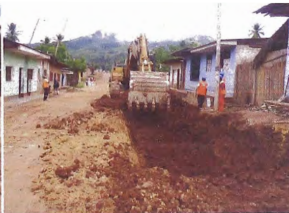
Figura 32: Trabajos de excavación Fuente: Expediente Ppto. Adicional N° 05
