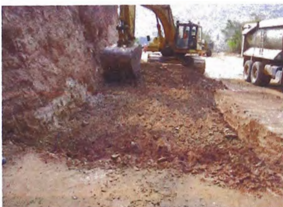
Figura 31: Trabajos de mejoramiento Fuente: Expediente Ppto. Adicional N° 05
