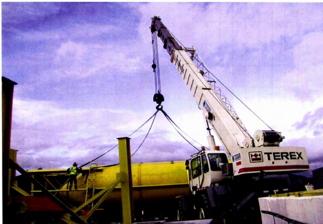
Figura N° 3.9.- Preparativos previos al izaje de silo de cemento (Fuente: Archivo propio)
