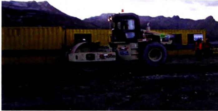
**Figura N° 4.19.- Compactación de terreno en área de control de calidad. (Fuente: Archivo propio)**
