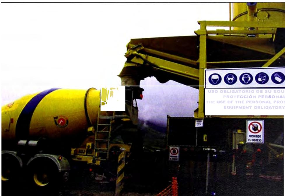
**Figura N° 1.3.- Carguío de concreto a mixer (Fuente: Archivo propio)**
