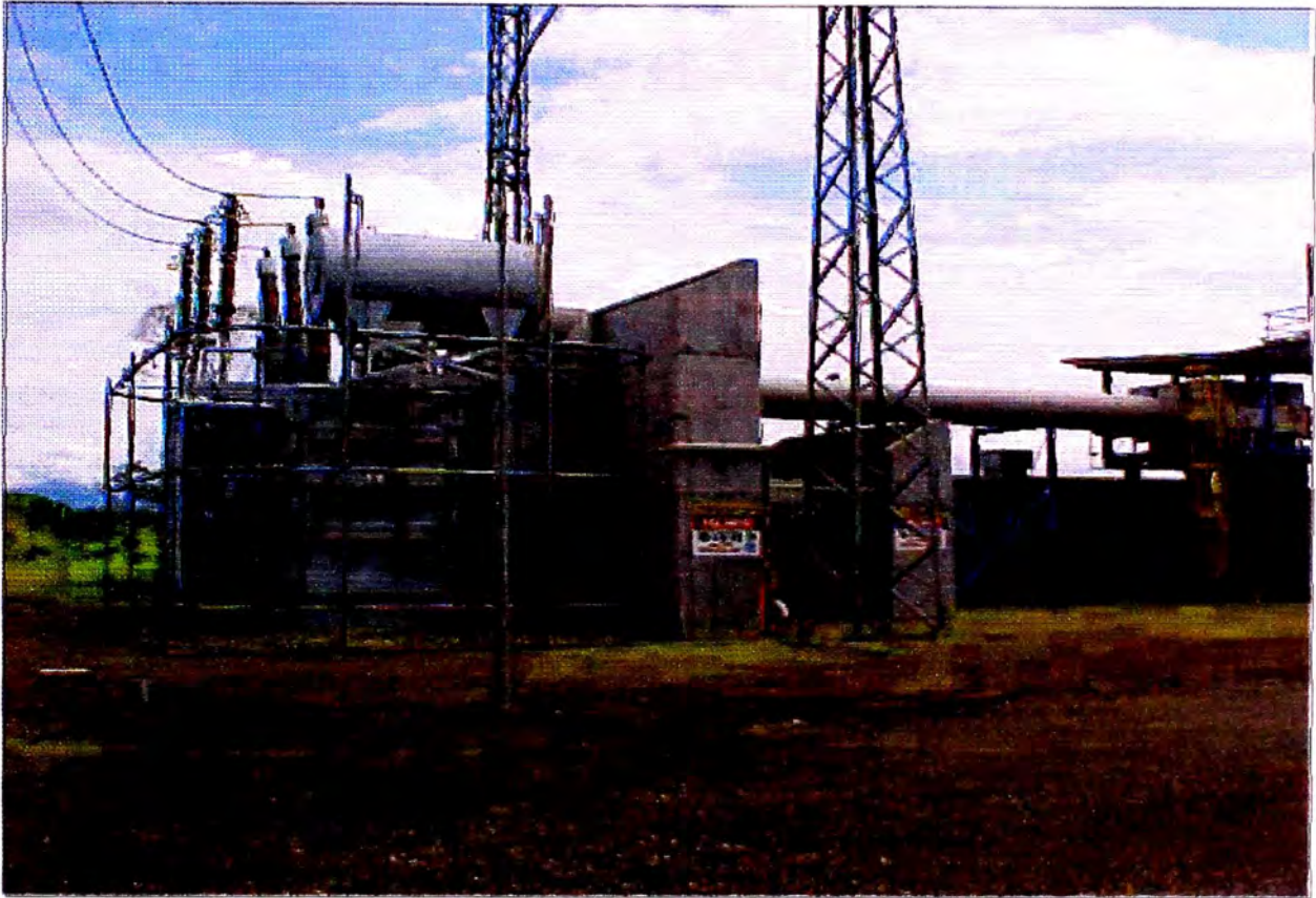
Fotografía #10 Vista de Muro cortafuego
