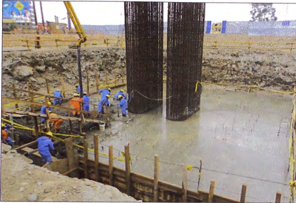
Figura N°3.34: Vaciado de concreto de la 2da etapa de la zapata O17
