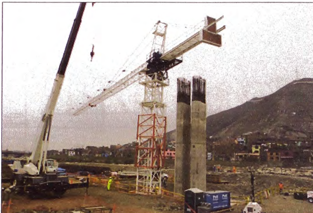
Figura N°3.45: Acople de la pluma a la tornameza – Eje O16.
