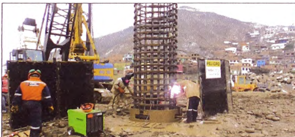
Figura N°3.10: Soldadura en los traslapes que unen 2 armaduras del pilote
