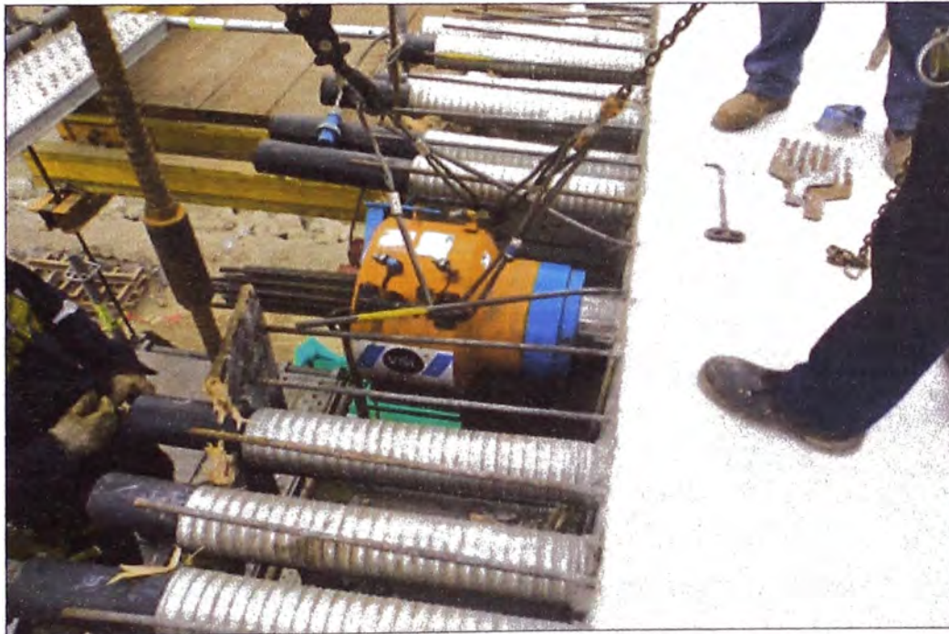
Figura N°3.76: Colocación del gato hidráulico para el tensado.
