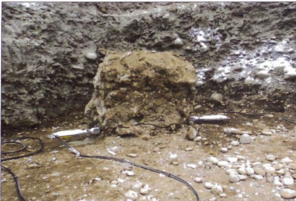
Figura N°3.18: Fracturación de la cabeza del pilote con el quebrantador hidráulico.
