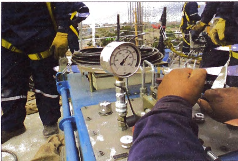
Figura N°3.60: Monitoreo del tensado y de la presión a través del manómetro
