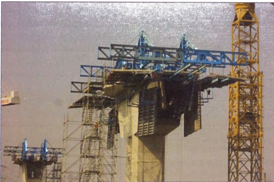
Figura N°3.70: Colocación de la plataforma exterior (outer form) y de la plataforma interior (inner form).
