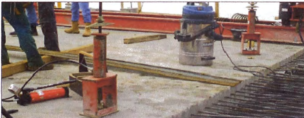
Figura N°2.46: Fotografía de destensado con cilindros huecos.
