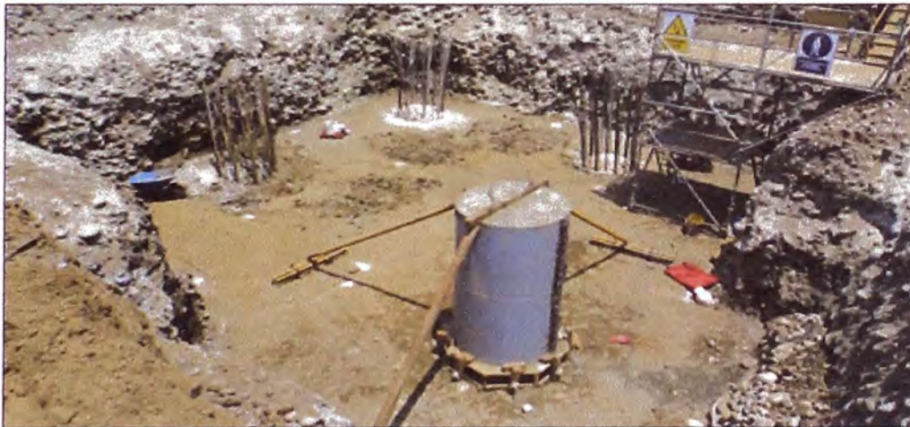
Figura N°3.21: Cabeza de Pilote con superficie de impacto
