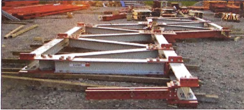
Figura N°2.19: Fotografía Pre Montaje de Estructura Principal.
