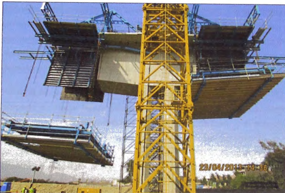
Figura N°3.72: Izaje de la plataforma inferior (bottom form) y de la plataforma de seguridad (safety platform).
