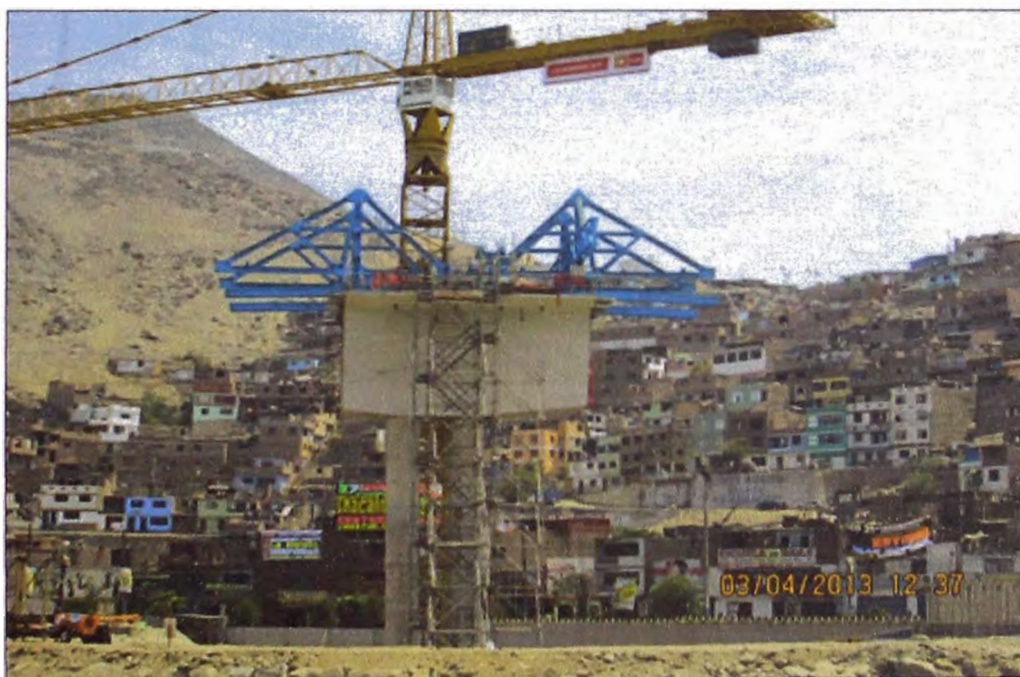
Figura N°3.68: Marcos principales colocados en ambos sentidos.
