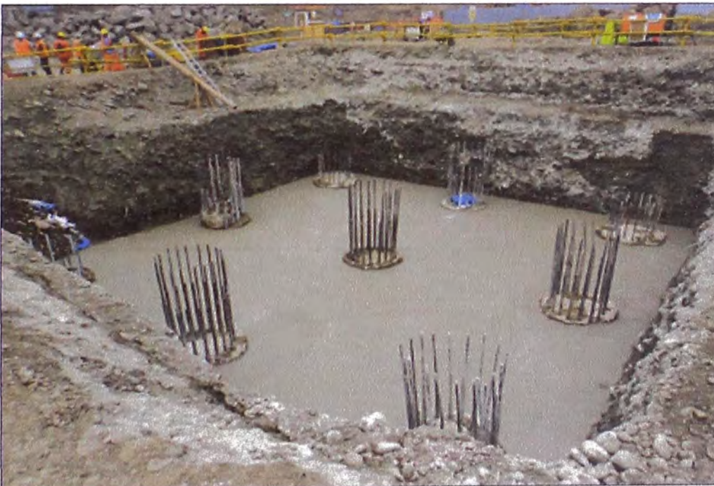
Figura N°3.28 Vaciado del solado
