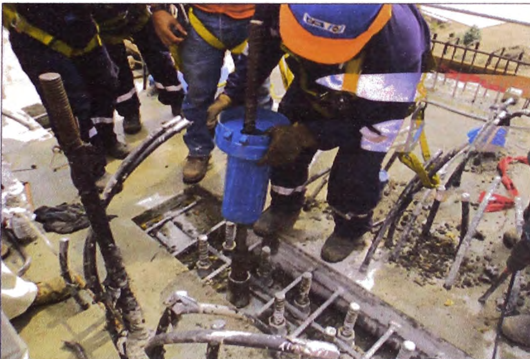
Figura N°3.58: Colocación de la silla
