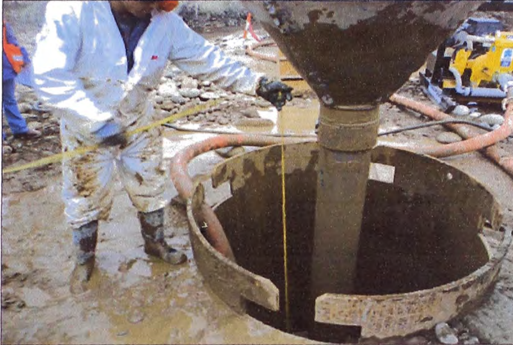
Figura N°3.15: Medición de la ubicación del concreto
