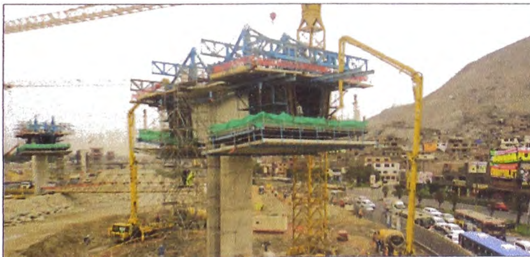
Figura N°3.75: Vaciado de las dovelas 1N y 1S – Eje O17
