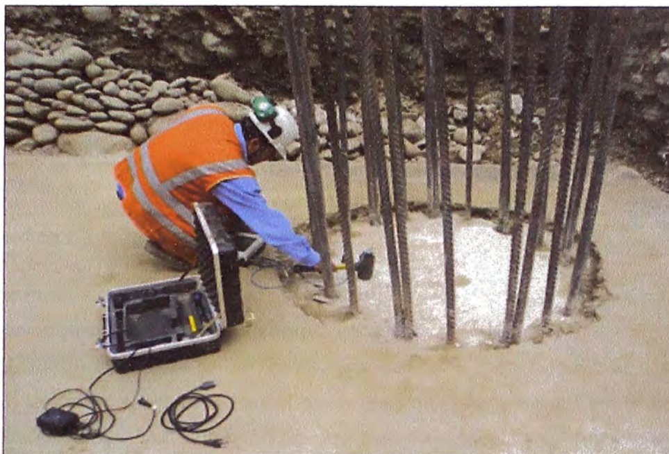
Figura N°3.20: Prueba de Integridad
