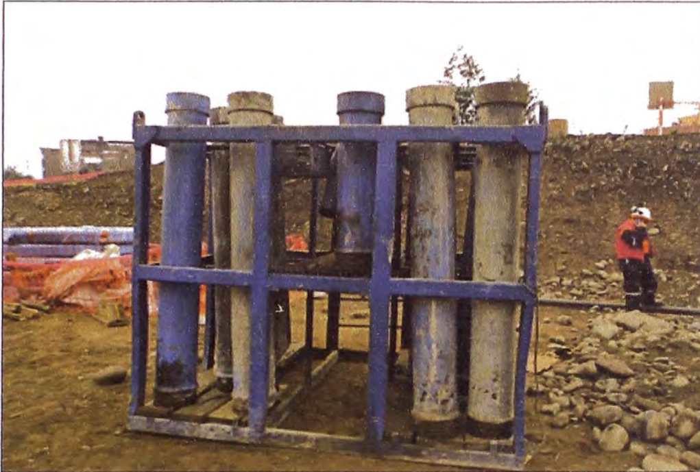
Figura N°3.12: Tuberías Tremie
