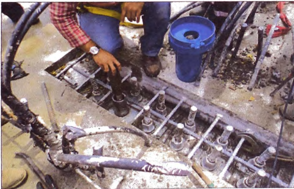
Figura N°3.56: Colocación de la tuerca y el manguito tensor
