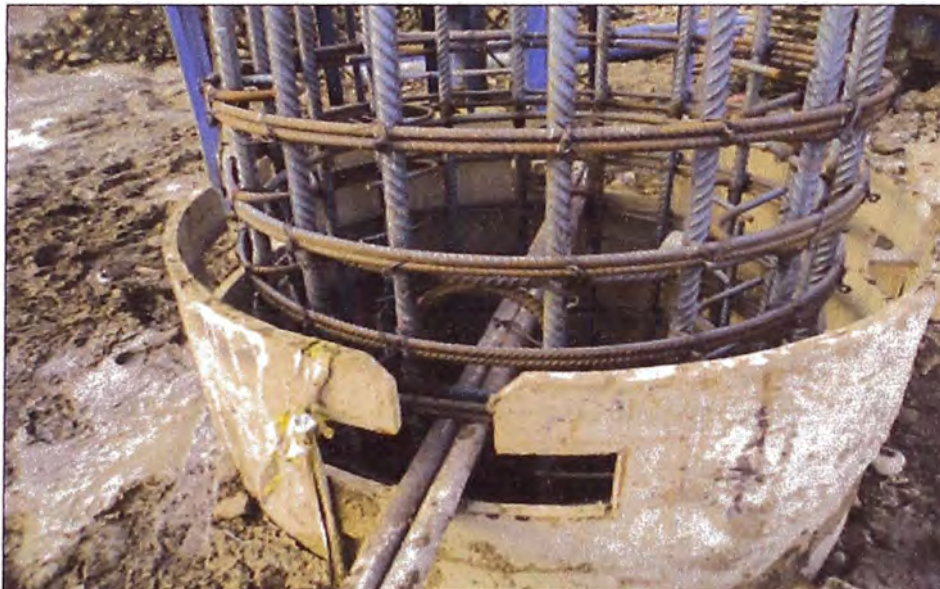
Figura N°3.9: Armadura trabada con la camisa a través de una barra horizontal.
