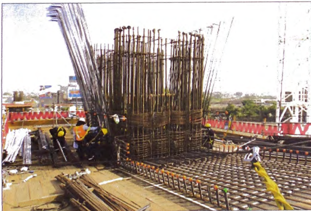
Figura N°3.48: Habilitación y colocación de acero en la losa inferior.
