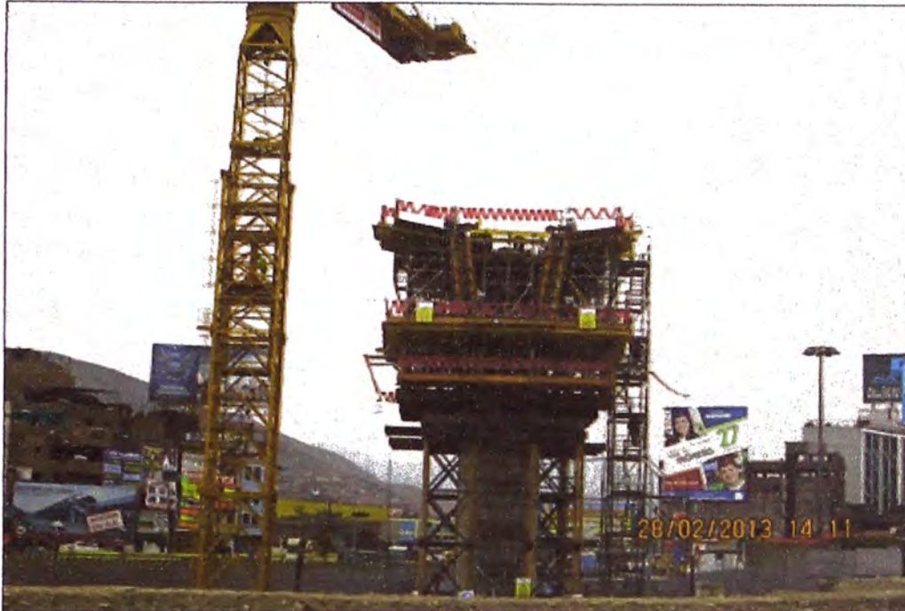
Figura N°3.54: Encofrado de la losa superior de la dovela de arranque.
