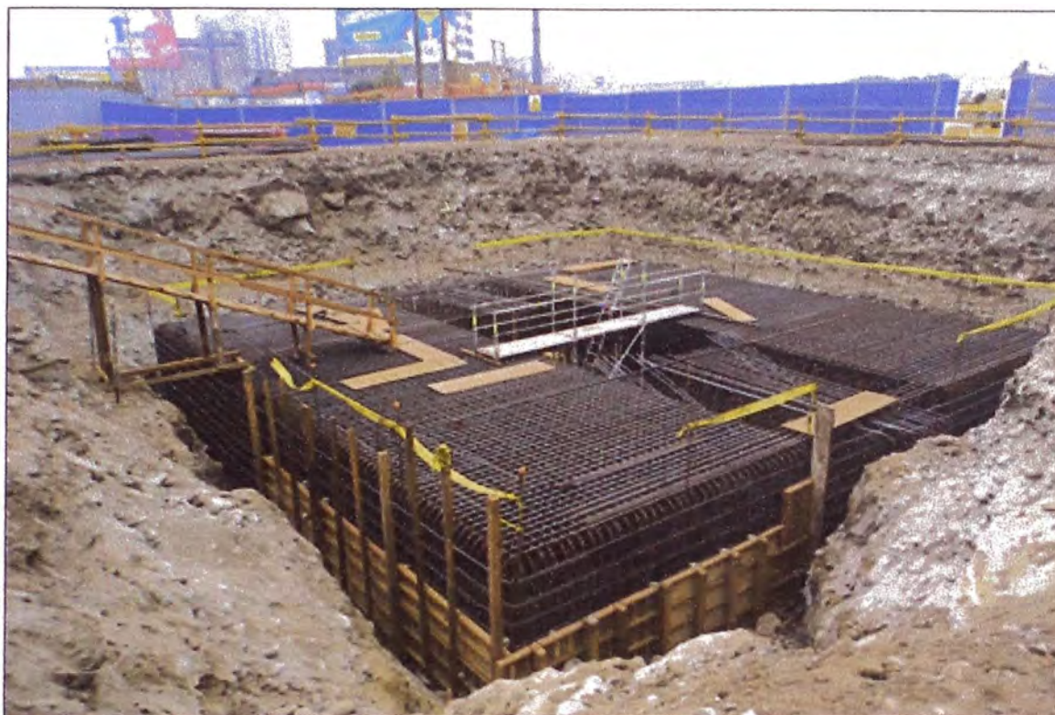
Figura N°3.30: Armadura de la zapata lista para la colocación de la columna
