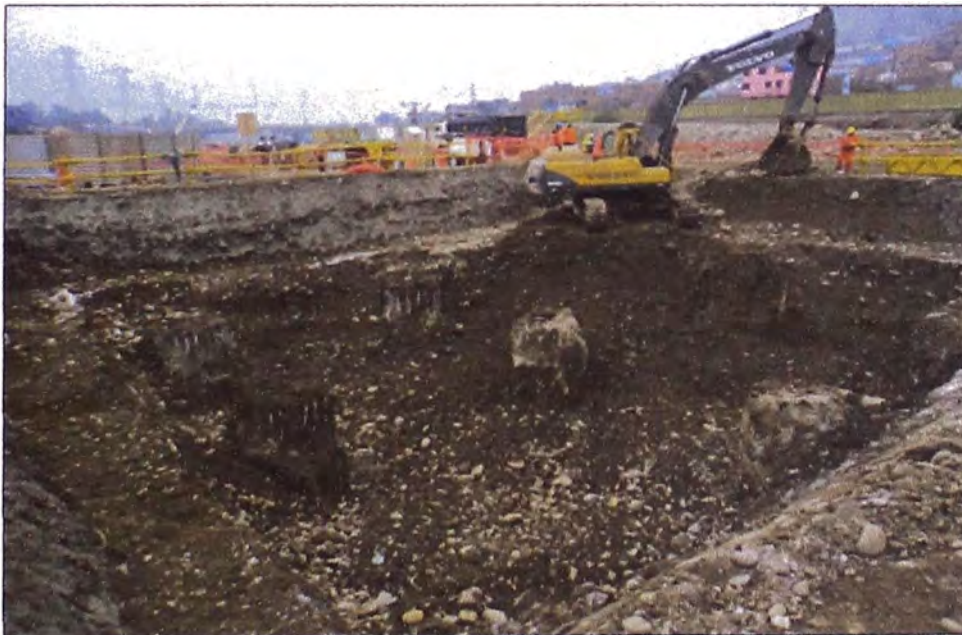
Figura N°3.26: Excavación de la zapata (2da etapa).
