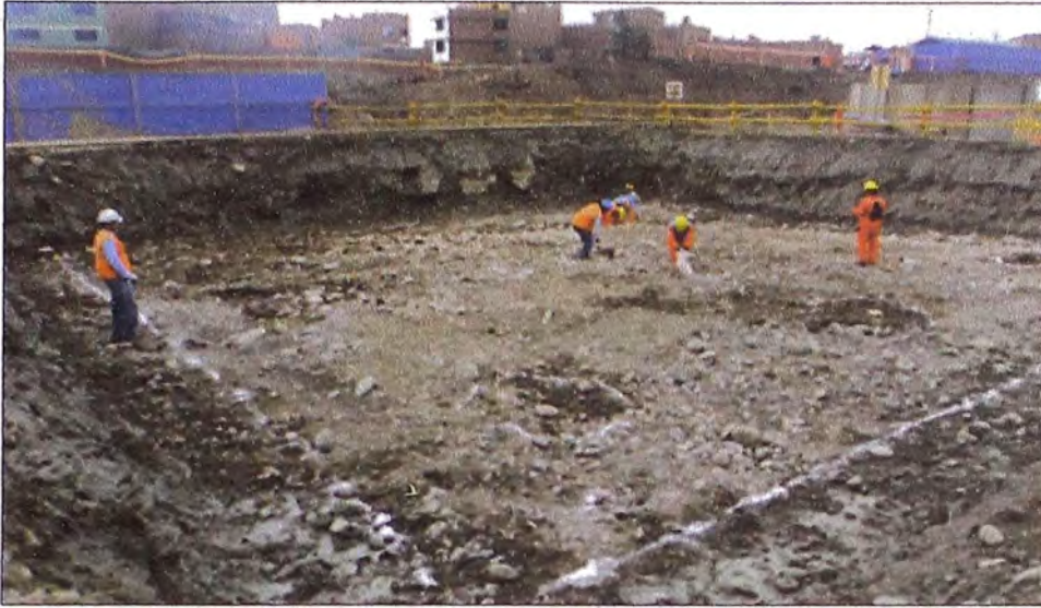
Figura N°3.25: Excavación a nivel de la banquetta
