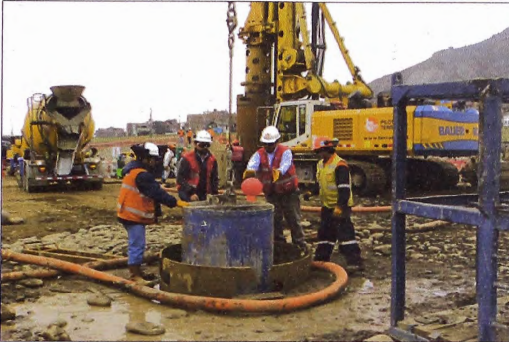
Figura N°3.13: Colocación de la pelota antes de iniciar el vaciado
