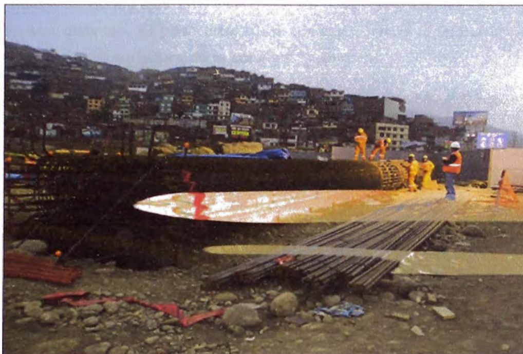
Figura N°3.36: Colocación de acero en la armadura de la columna O17
