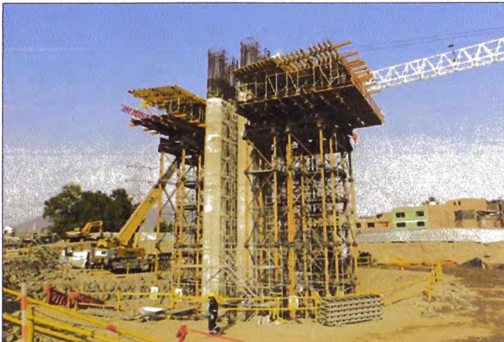
Figura N°3.47: Colocación de losa de fondo de la dovela de arranque
