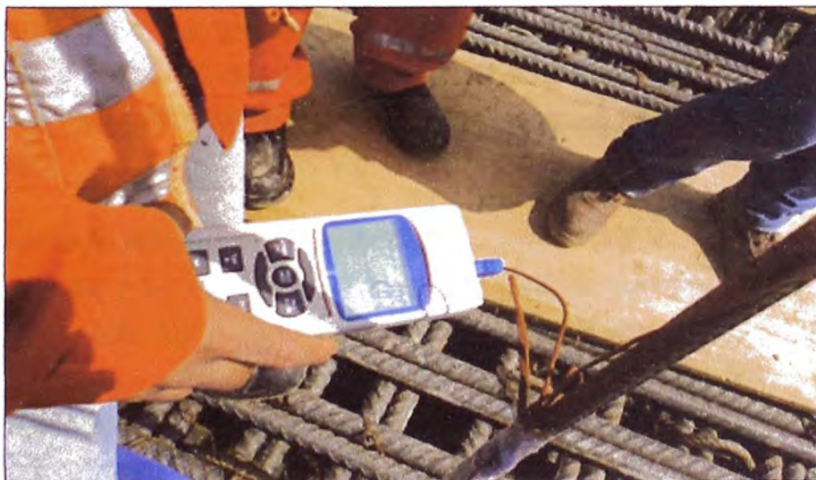
Figura N°3.32: Medición de la temperatura del concreto a través de termocuplas
