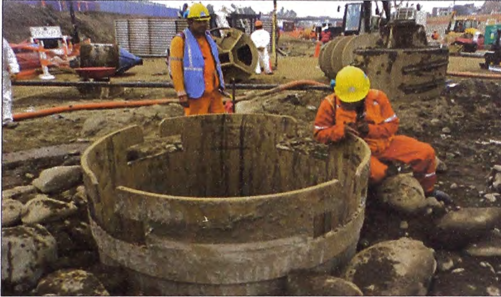
Figura N°3.4: Verificación de la posición de la camisa por parte de topografía
