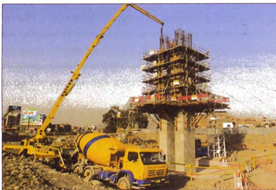
Figura N°3.38: Vaciado de concreto de la 3ra etapa de las columnas.
