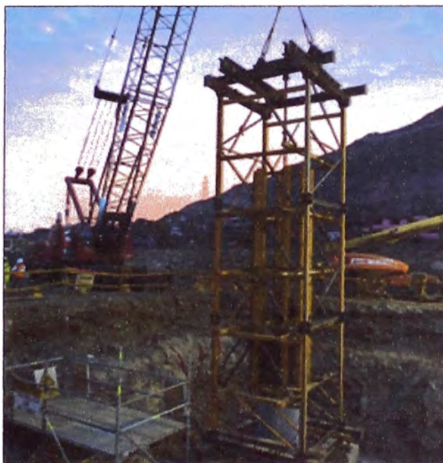
Figura N°3.23: Dispositivo de carga
