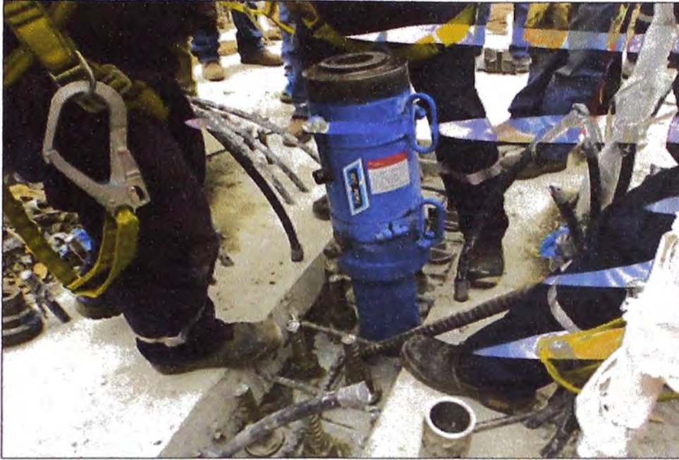
Figura N°3.59: Colocación del gato hidráulico
