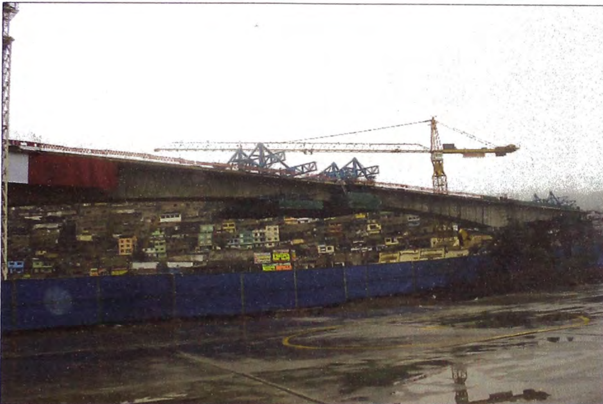
Figura N°3.80: Vaciado de concreto de la dovela de cierre central
