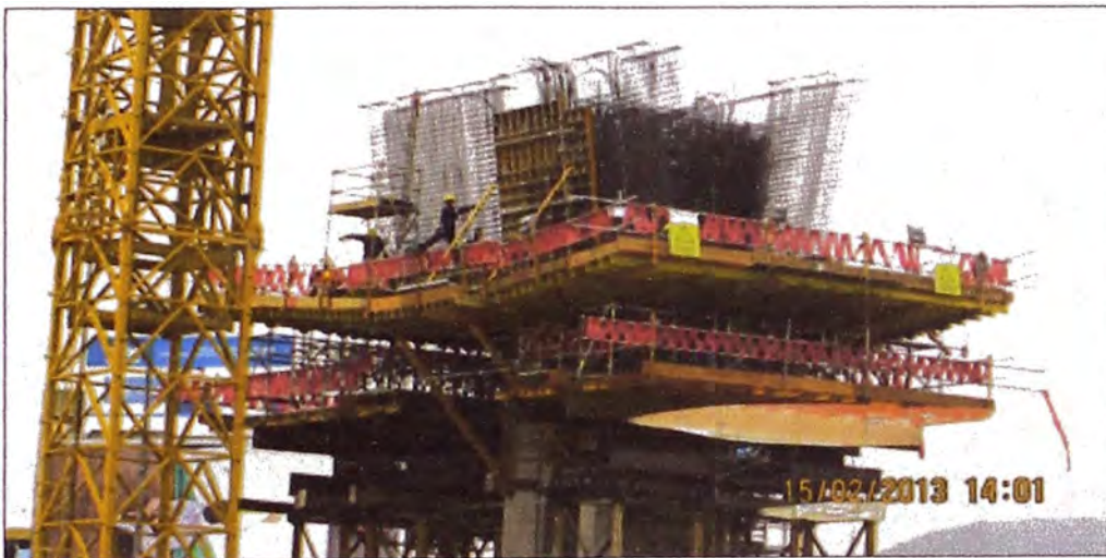
Figura N°3.51: Armadura de las almas de la dovela de arranque.
