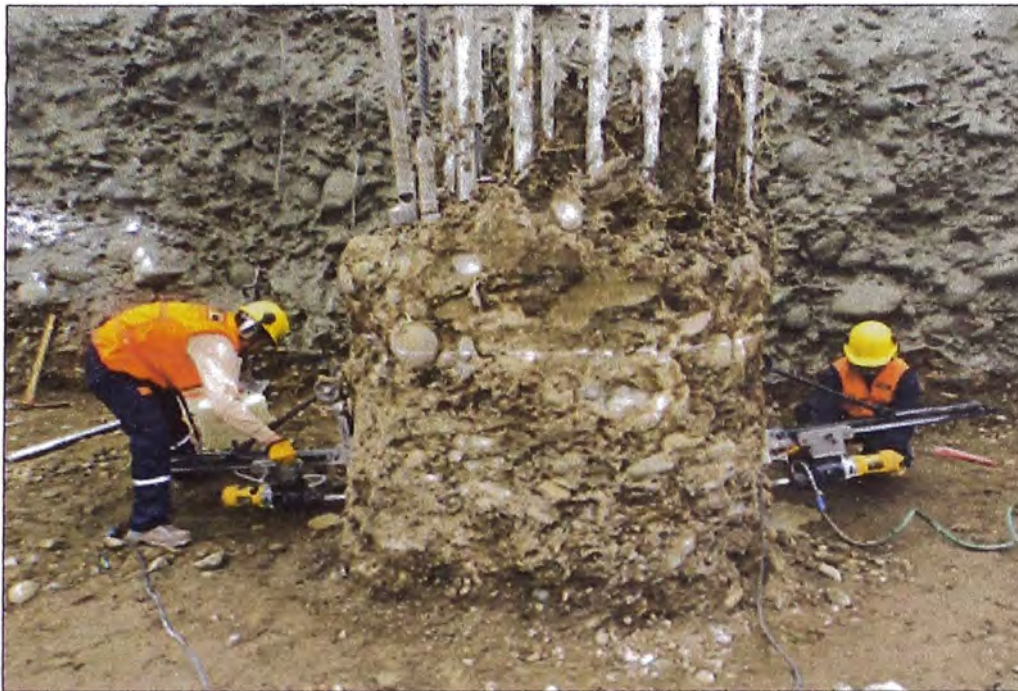
Figura N°3.17: Perforaciones del barreno para el descabezado del pilote
