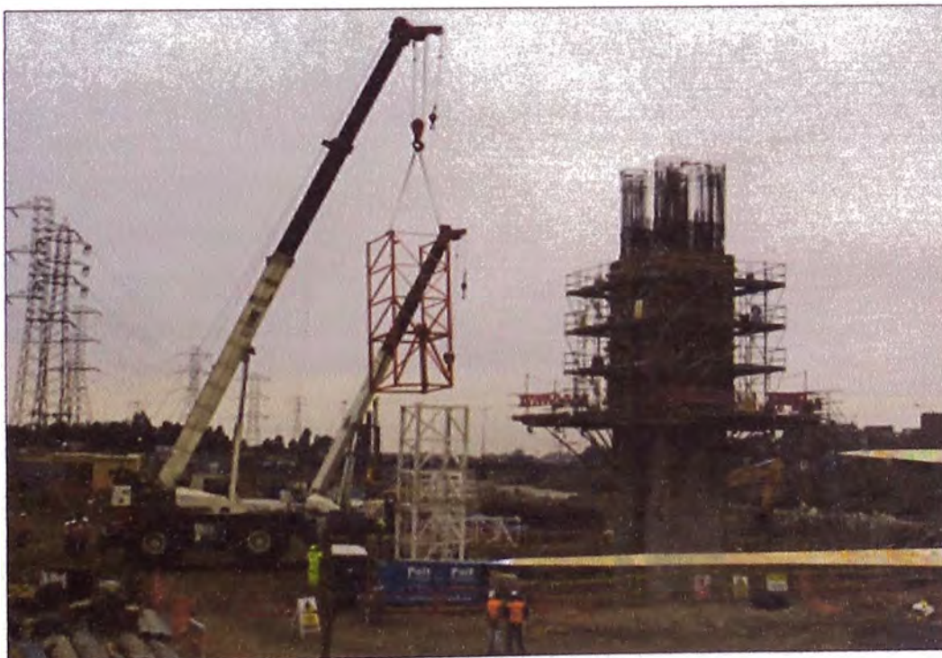
Figura N°3.42: Instalación de los siguientes cuerpos – Eje O16
