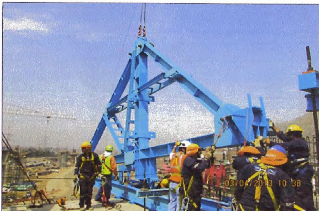
Figura N°3.67: Colocación del marco principal.
