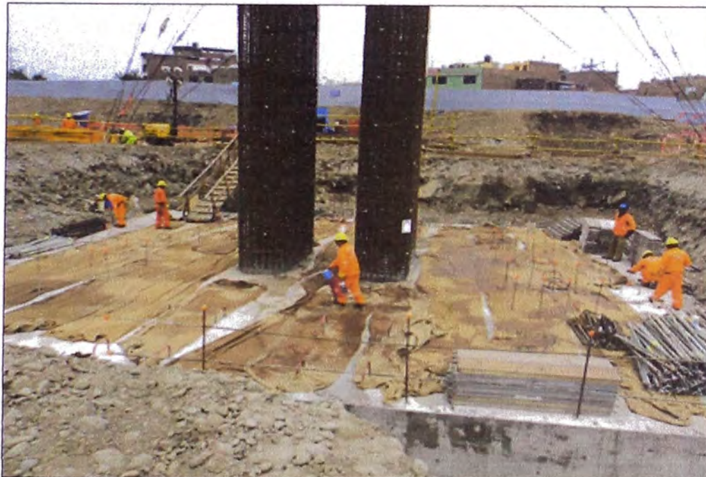
Figura N°3.35: Curado vía húmeda utilizando mantas
