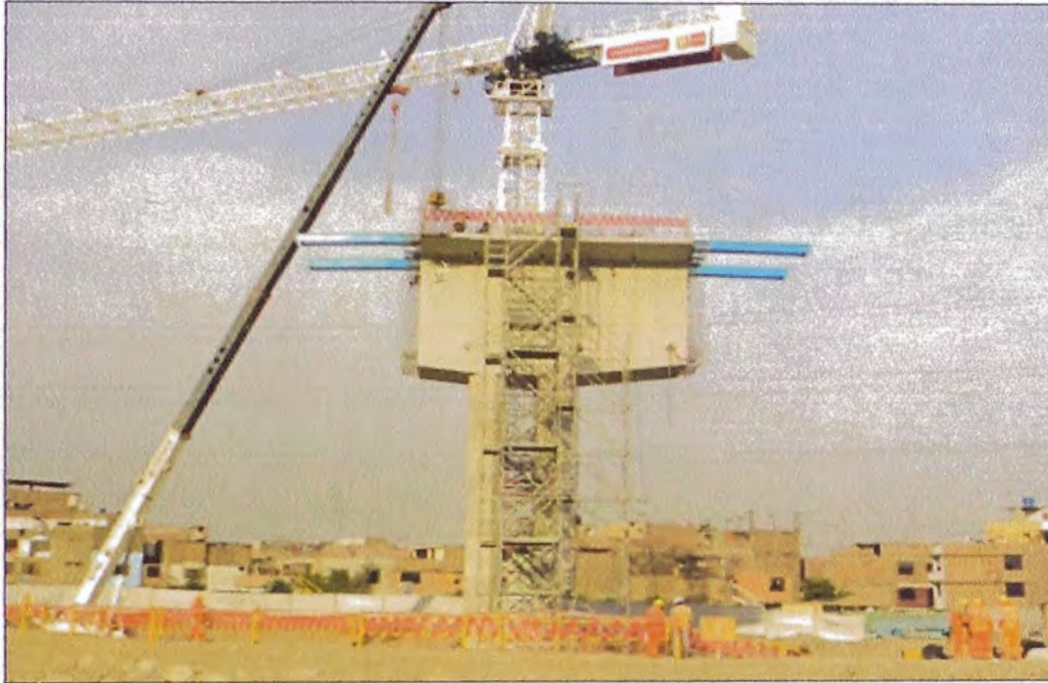
Figura N°3.65: Colocación de los rieles
