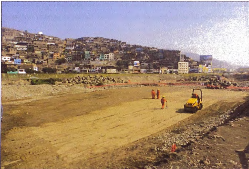
Figura N°3.1: Compactación de la plataforma
