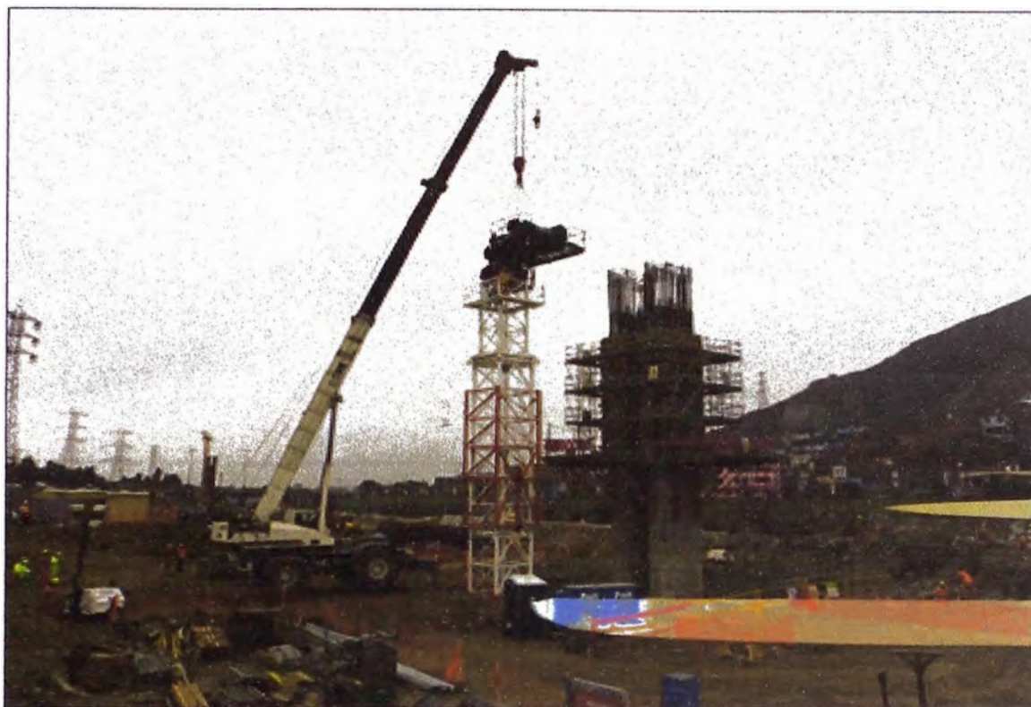
Figura N°3.43: Colocación de la tornamesa – Eje O16.
