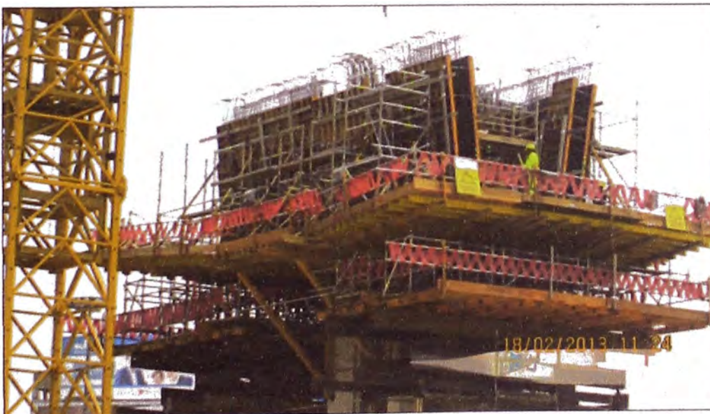
Figura N°3.52: Encofrado de las almas de la dovela de arranque.
