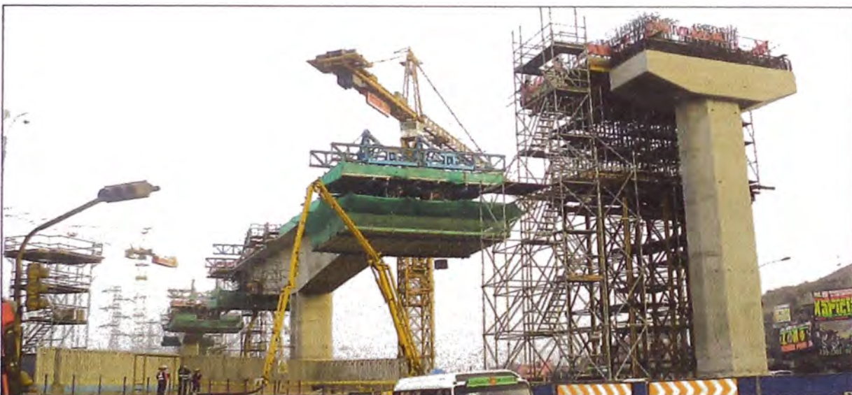
Figura N°3.79: Foto panorámica de la construcción del Puente sobre la vía Evitamiento mediante Dovelas Sucesivas
