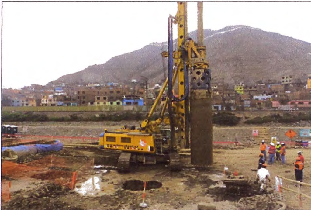
Figura N°3.16: Retiro de la camisa.
