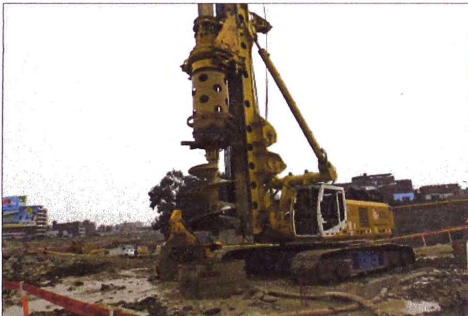
Figura N°3.5: Perforación de un pilote con hélice
