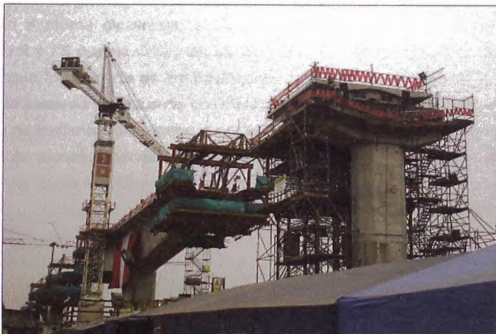
Figura N°3.83: Dovela de cierre extrema – Eje O18
