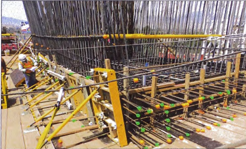
Figura N°3.49: Encofrado de la losa inferior.
