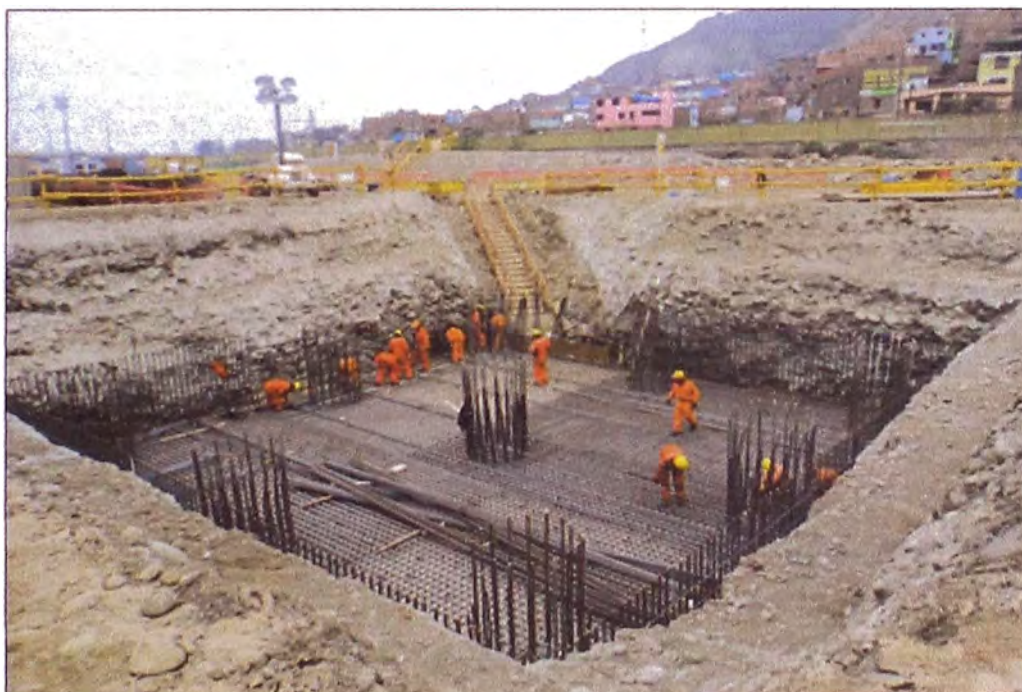
Figura N°3.29: Colocación de acero en la zapata O16
