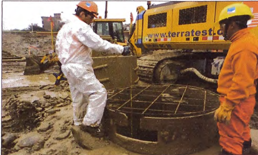
Figura N°3.7: Lectura de la profundidad de la perforación
