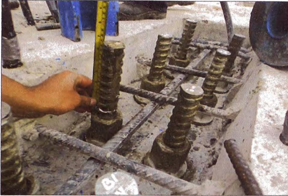
Figura N°3.61: Verificación de la elongación de la barra roscada
