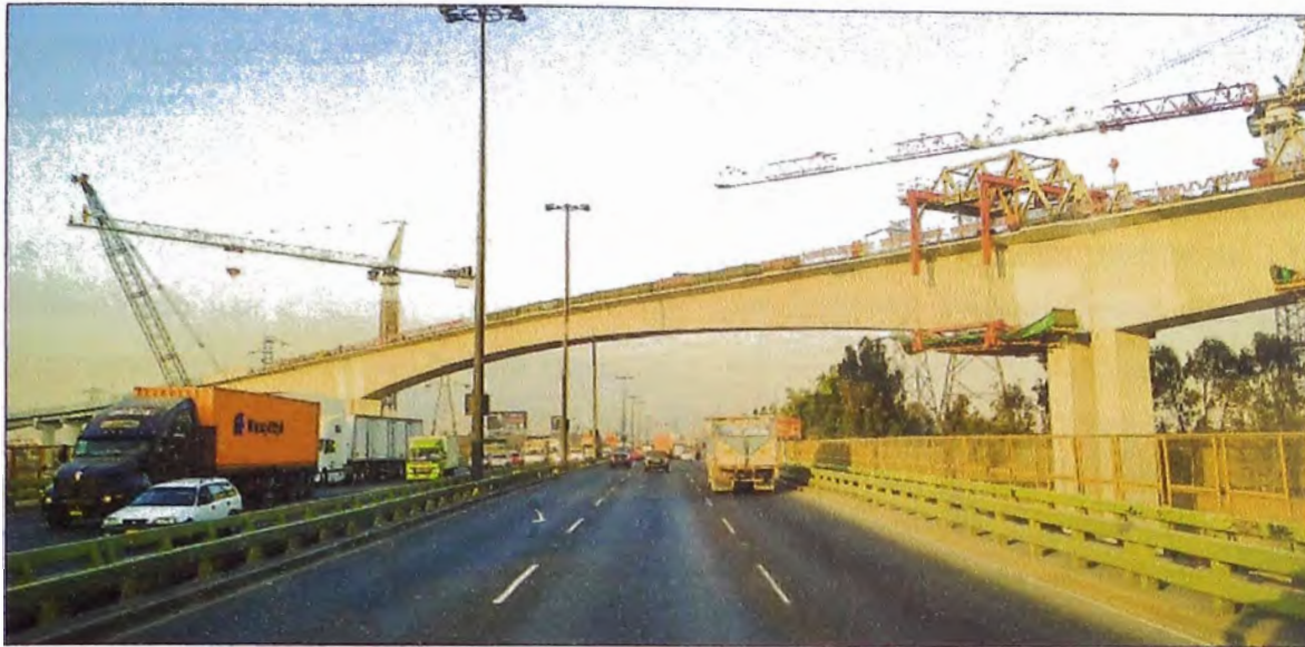
Figura N°3.86: Desmontaje del carro de avance
