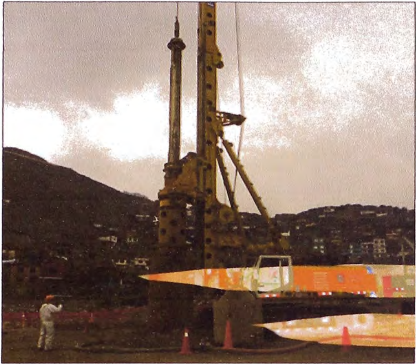
Figura N°3.3: Colocación de la camisa rotando con la KDK
