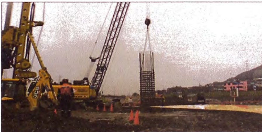
Figura N°3.8: Colocación de la armadura del pilote
