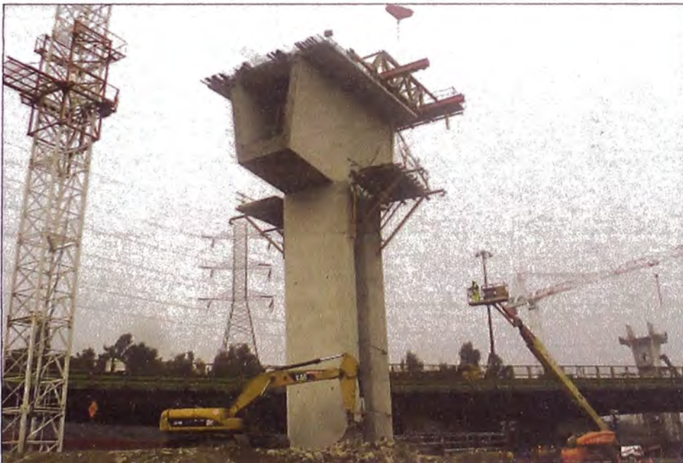
Figura N°3. 55: Desencofrado dovela cero – eje O17
