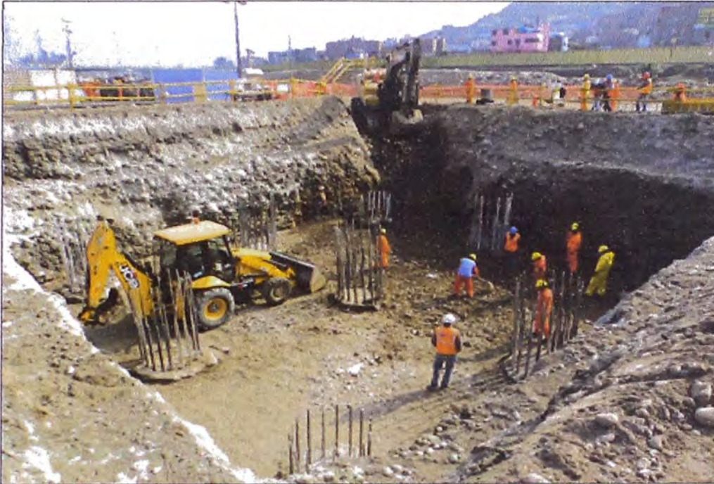
Figura N°3.27: Nivelación del terreno
