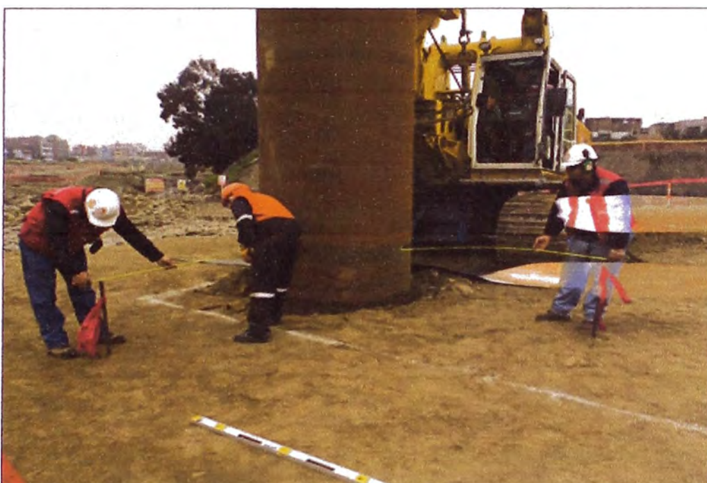
Figura N°3.2: Verificación de la colocación de la camisa mediante unas guías
