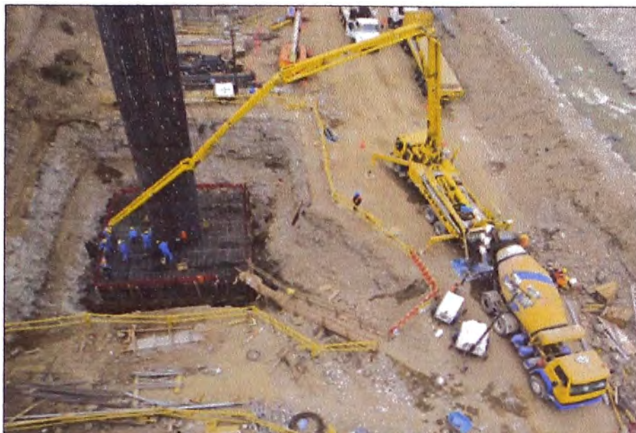
Figura N°3.31: Vaciado de concreto de la 1ra etapa de la zapata O16
