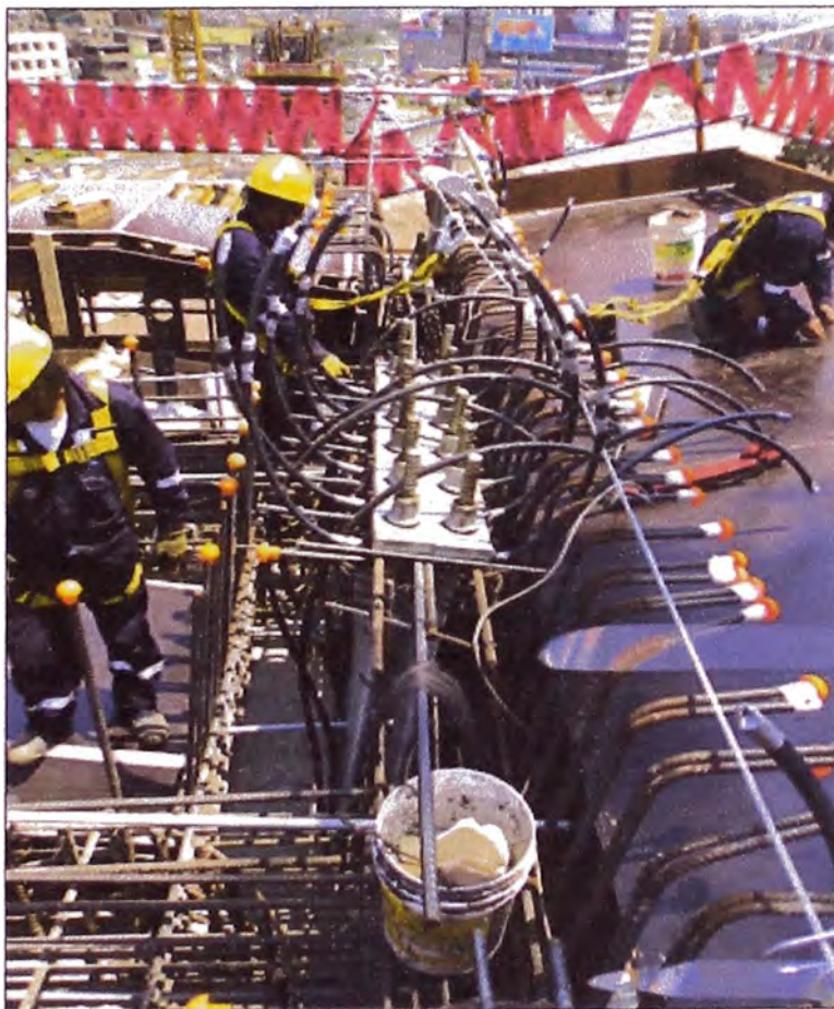
Figura N°3.53: Colocación de los anclajes de las barras roscadas en la losa superior
