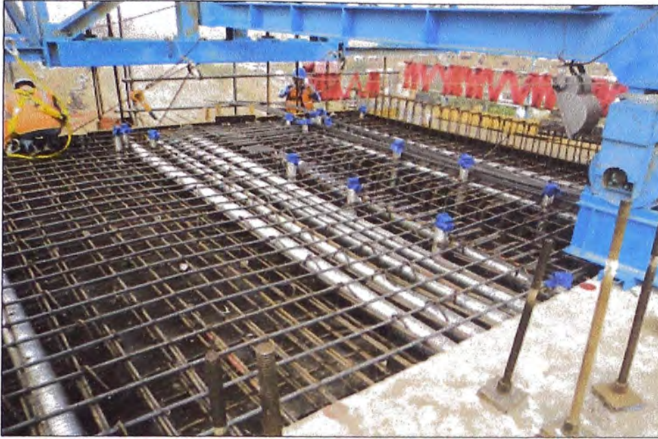
Figura N°3.74: Losa superior de la dovela
