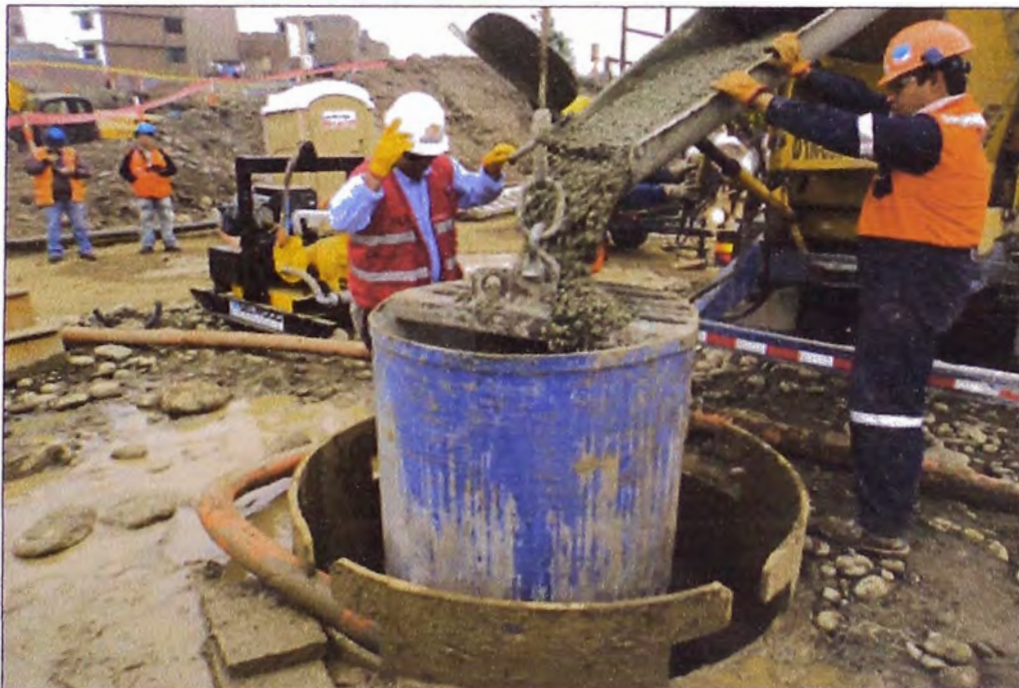
Figura N°3.14: Vaciado del pilote
