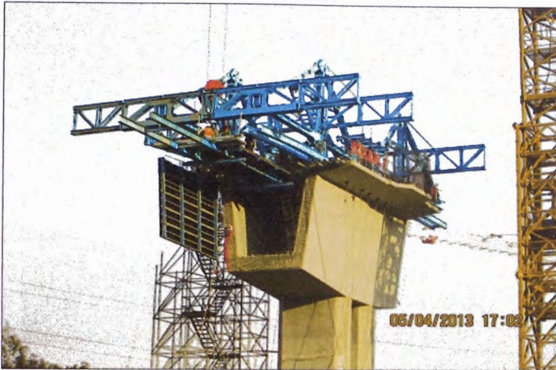
Figura N°3.69: Colocación de la plataforma exterior (outer form).
