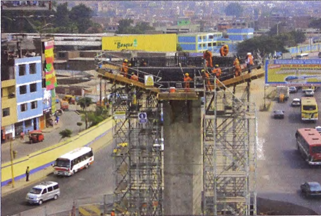
Figura N°3.39: Colocación de acero en la viga cabezal – eje O18.
