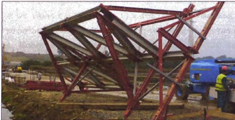
Figura N°2.20: Fotografía Pre Montaje de Estructura Principal con arriostres MK-120.
