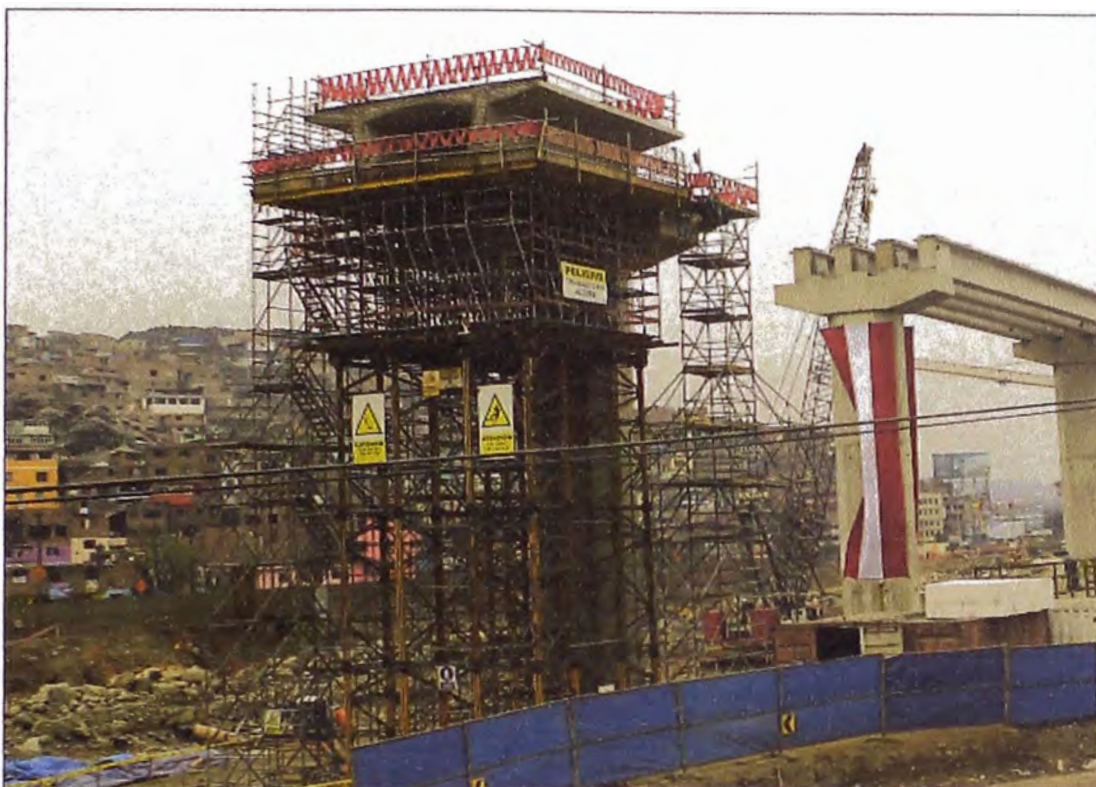
Figura N°3.81: Apoyos temporales para las dovelas extremas – Eje O15.
