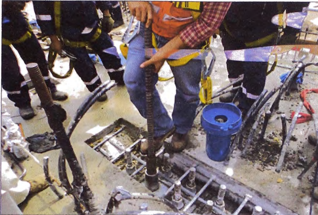
Figura N°3.57: Colocación de la barra de extensión
