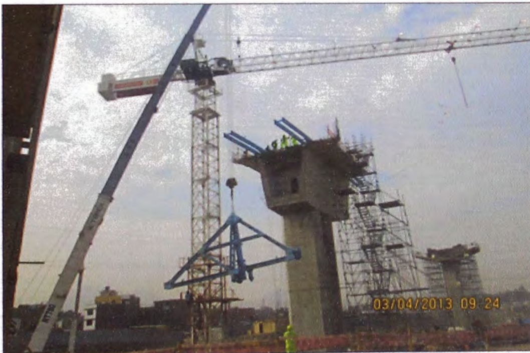
Figura N°3.66: Izaje del marco principal.
