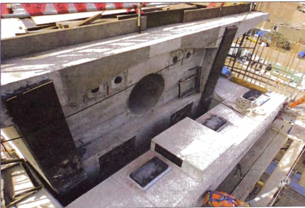
Figura N°3.40: Colocación del grout y neopreno – eje O15.
