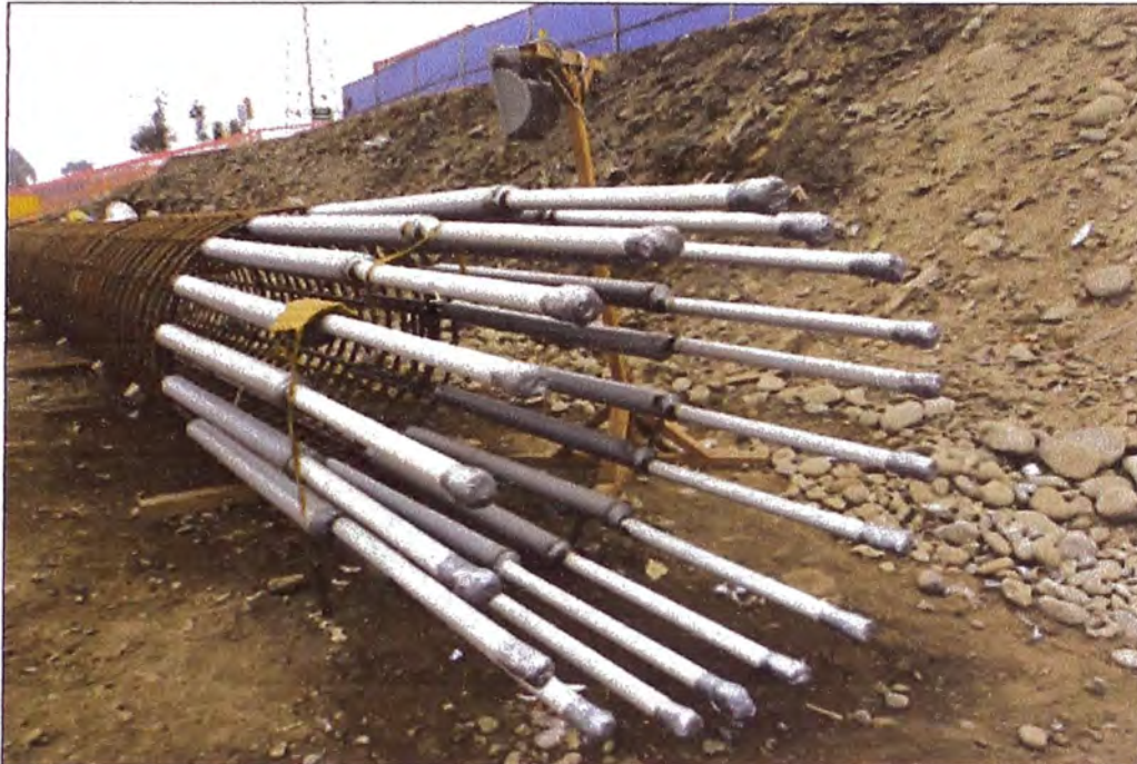
Figura N°3.11: Colocación de tubos de PVC para facilitar el descabezado
