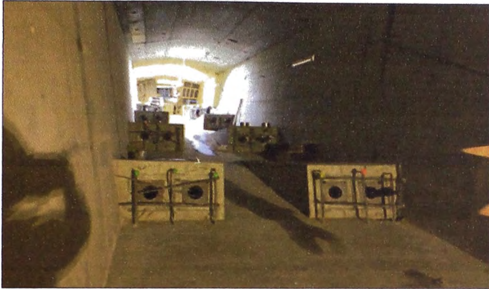
Figura N°3.84: Blister dentro de las dovelas sucesivas
