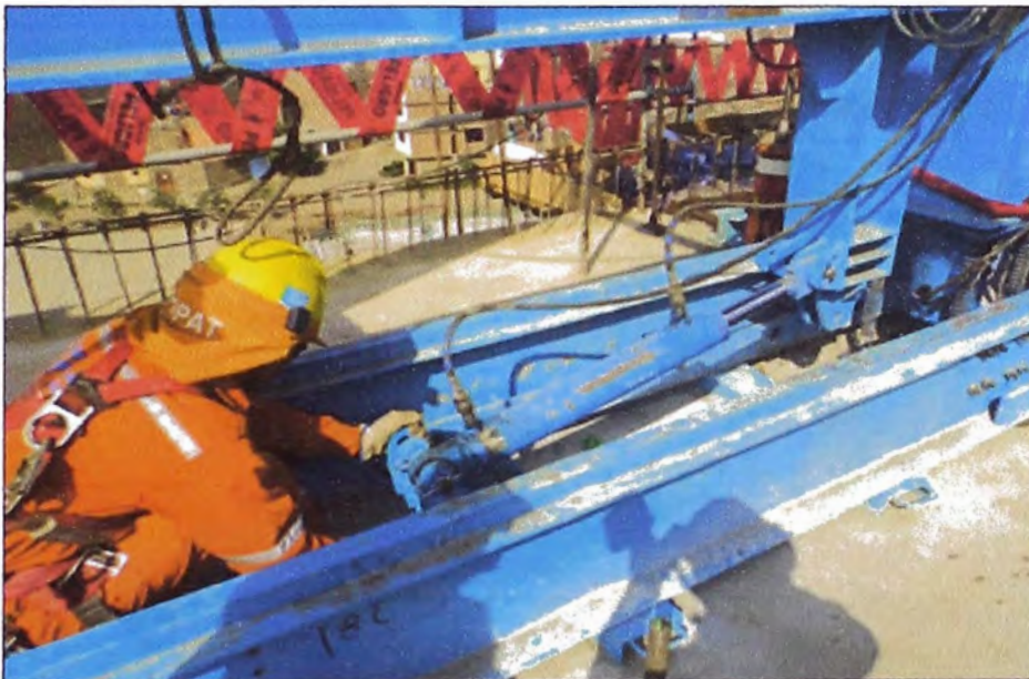
Figura N°3.77: Corrida del carro de avance.
