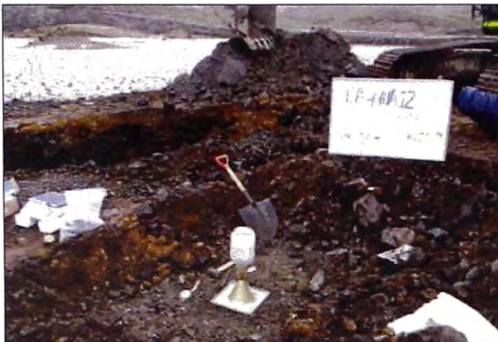
Foto N° 19: Ensayo de densidad de campo (Método del Cono de Arena) en la Calicata CA-307, dique del depósito de relaves 3.
