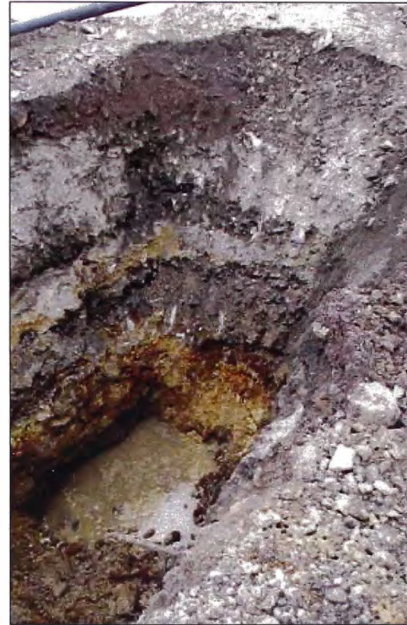
Foto N° 8: Calicata CA-301, dique del depósito de relaves 3.
