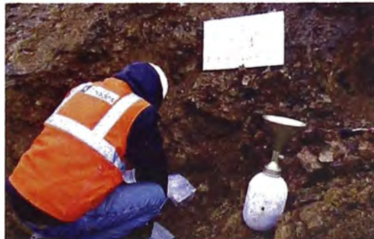
Figura N° 2.3 Vista del ensayo de densidad de campo
