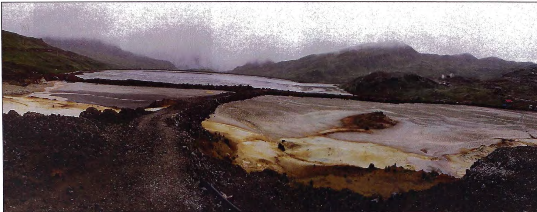
Foto N° 2: Vista Panorámica, aguas arriba del depósito de relaves 3.
