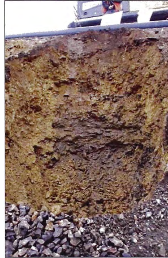
Foto N° 16: Calicata CA-313, dique del depósito de relaves 3.
