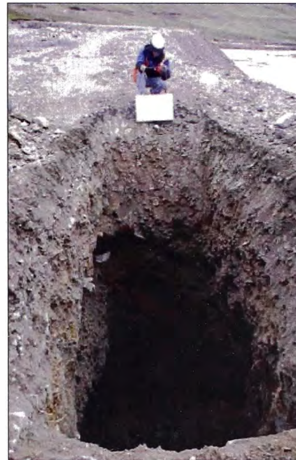
Foto N° 4: Calicata CA-201, dique del depósito de relaves 2.
