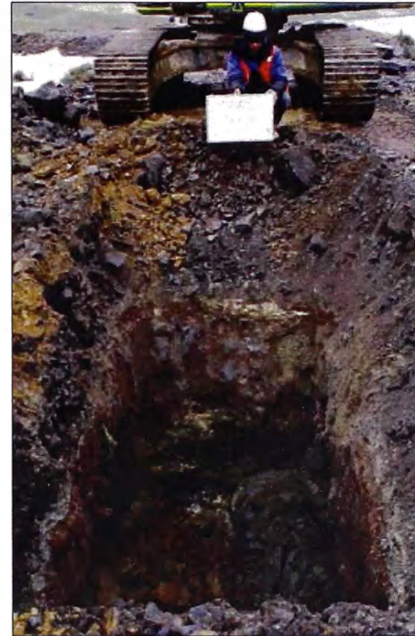
Foto N° 12: Calicata CA-307, dique del depósito de relaves 3.
