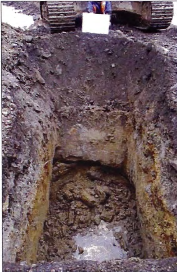
Foto N° 11: Calicata CA-306, dique del depósito de relaves 3.
