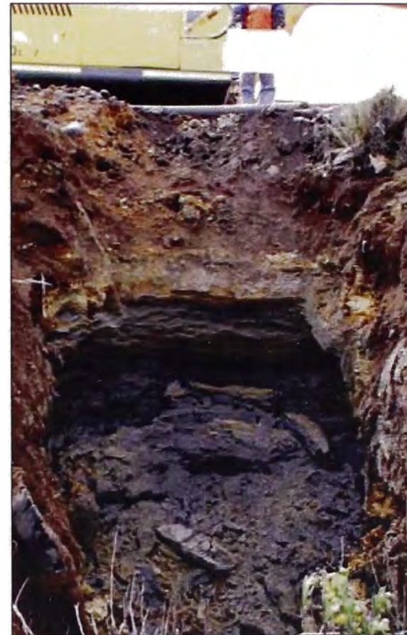
Foto N° 14: Calicata CA-310, dique del depósito de relaves 3.
