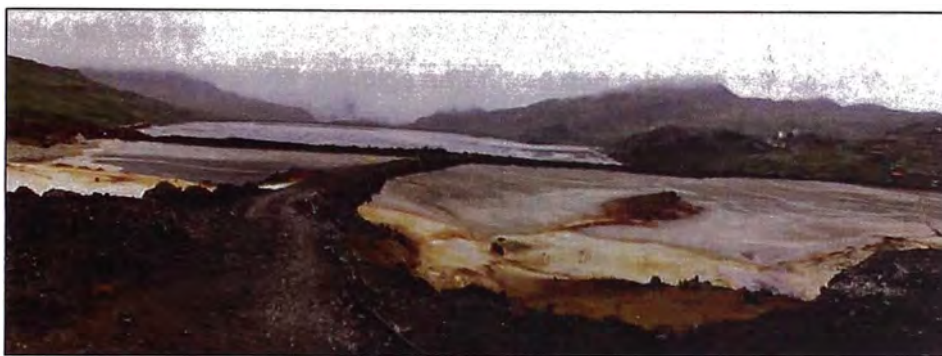
Figura N° 1.2 Área correspondiente al depósito de relaves 3.
