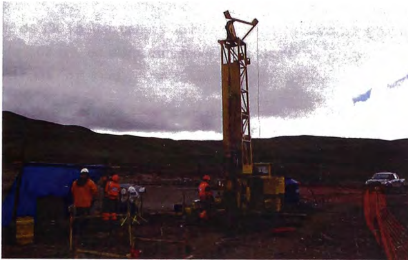
Figura N° 2.5 Vista del equipo de perforación
