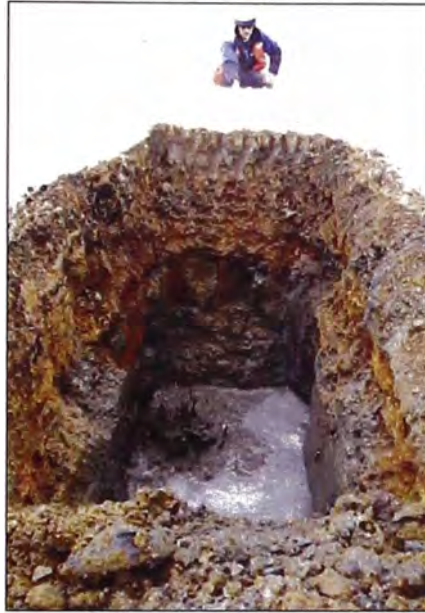
Figura N° 2.2 Vista de la excavación de calicata en el dique 3
