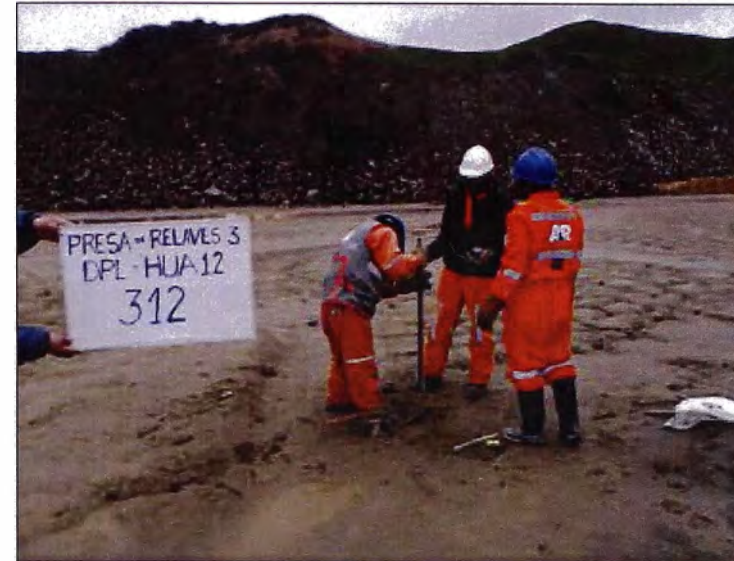
Foto N° 24: Ensayo DPL-312, depósito de relaves 3.
