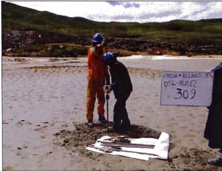
Foto N° 23: Ensayo DPL-309, depósito de relaves 3.
