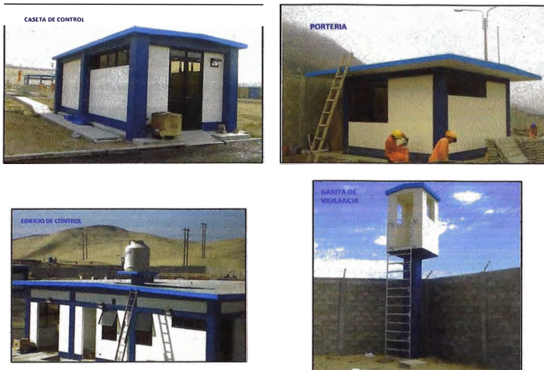
Figura N° 2.6 Edificaciones para sub estaciones.
