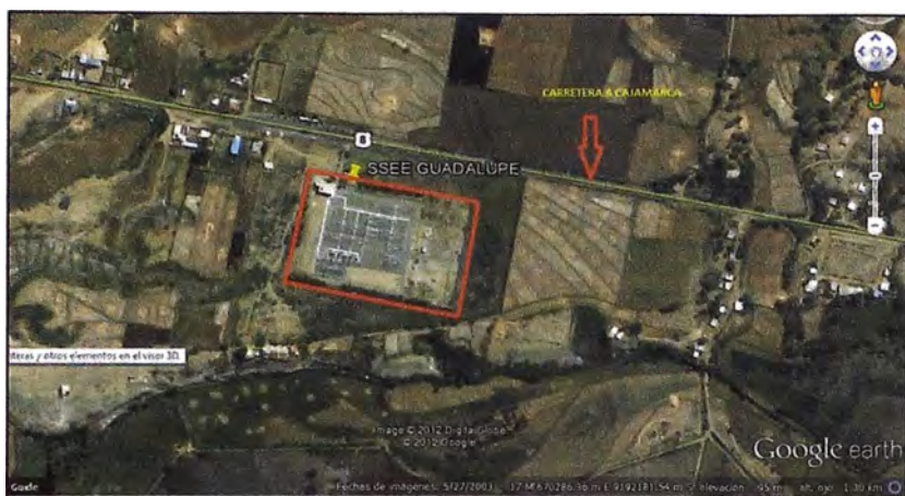
Figura N° 1.7 Ubicación sub estación Guadalupe.
