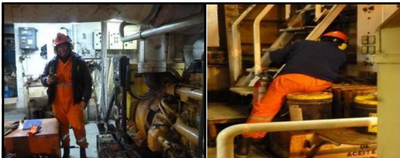
Motorista encargado de las operaciones en la sala de máquina para la operatividad de la embarcación
