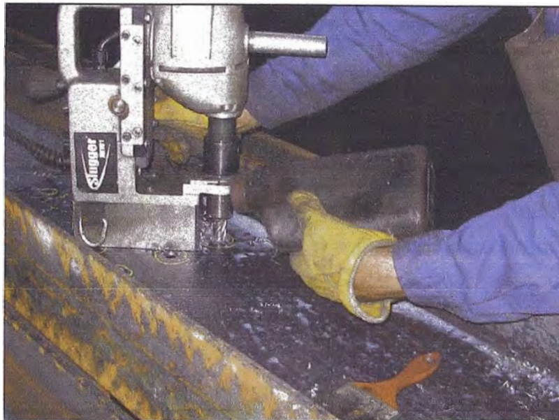
Figura 2.7 Taladro magnético de columna (Fuente: Álvaro Forero)
