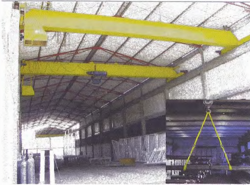
Figura 2.2 Puente grúa y eslinga para transporte de material (Fuente: Álvaro Forero)
