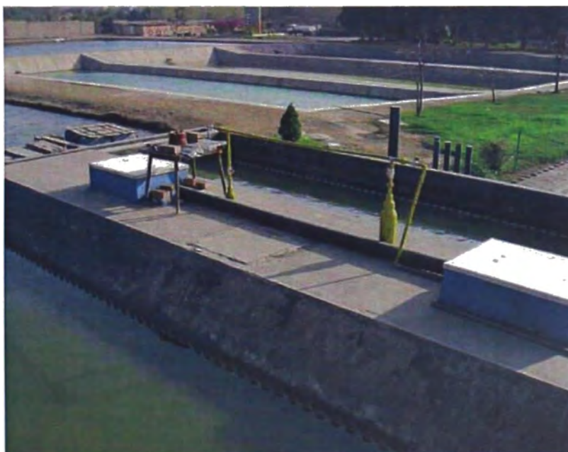
Gráfico N° 1.9 RAFA del Centro de Investigación en Tratamientos de Aguas Residuales y Residuos Peligrosos (CITRAR – UNI)
