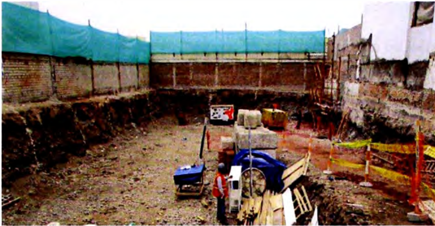
Figura 2.4 Excavación limitada por muros pantalla perimetrales.
