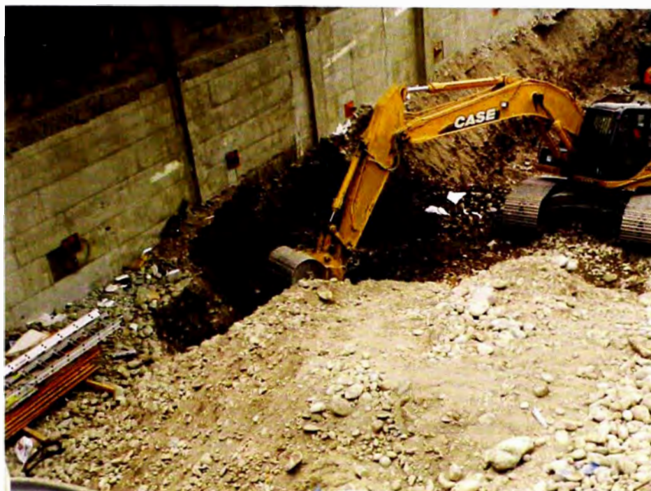
Figura 4.7 Excavación masiva, donde no se involucran actividades productivas.
