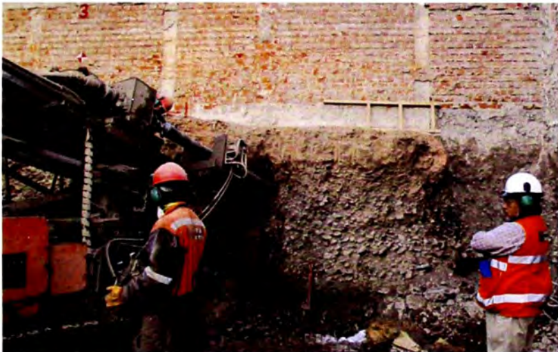
Figura 2.5 Perforación para anclajes de muro pantalla.
