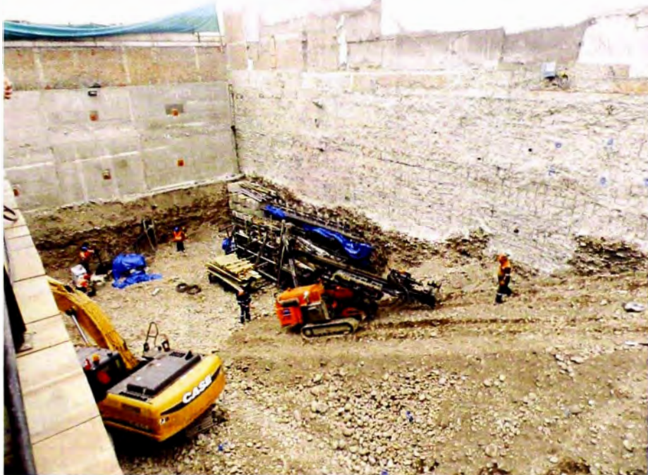
Figura 4.2 Vistas de la rampa ejecutada en obra y uso de la misma, luego del movimiento de tierras.
