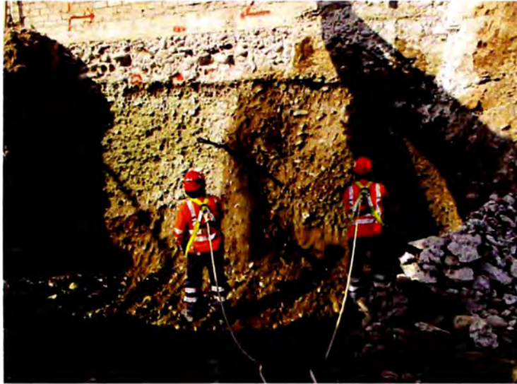
Figura 2.6 Perfilado con herramientas manuales.
