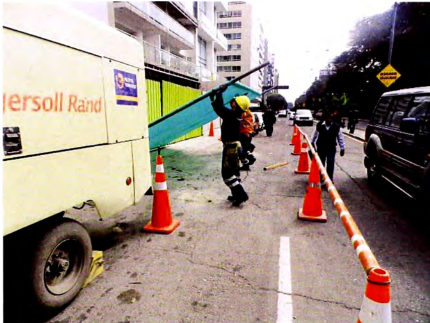
Figura 4.6 Reubicación de la compresora neumática, haciendo uso de vía.
