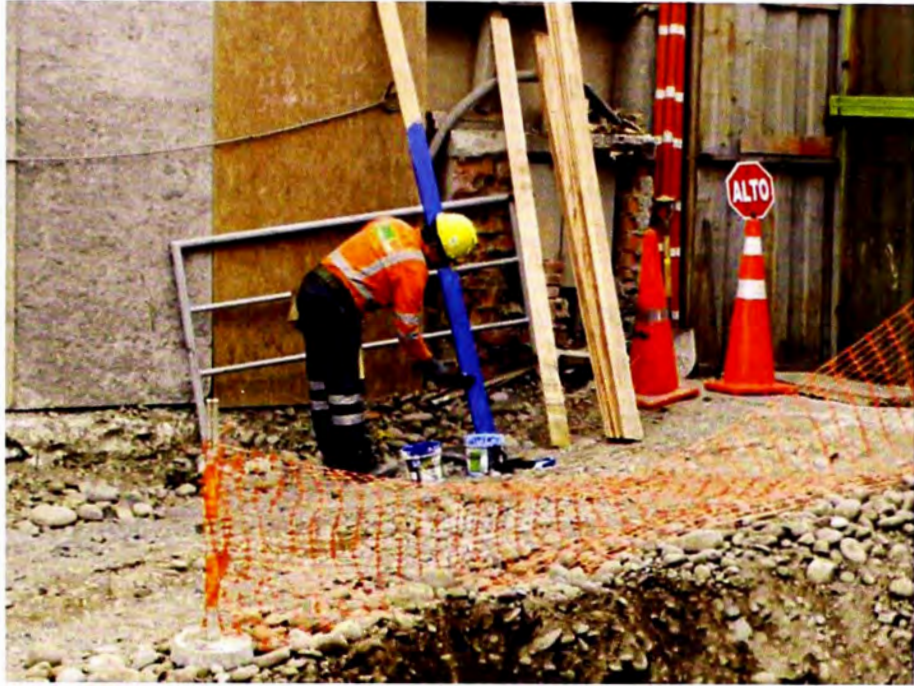
Figura 4.9 Mano de obra en apoyo de obras provisionales, durante etapa de excavación masiva
