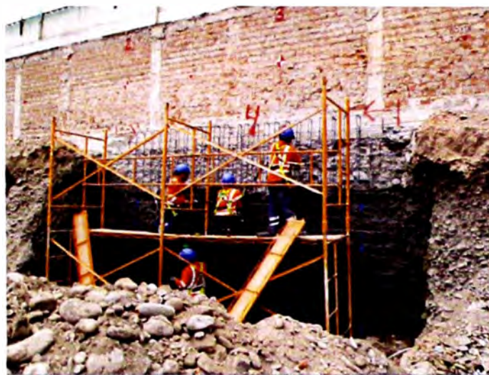
Figura 2.8 Colocación de acero in situ.
