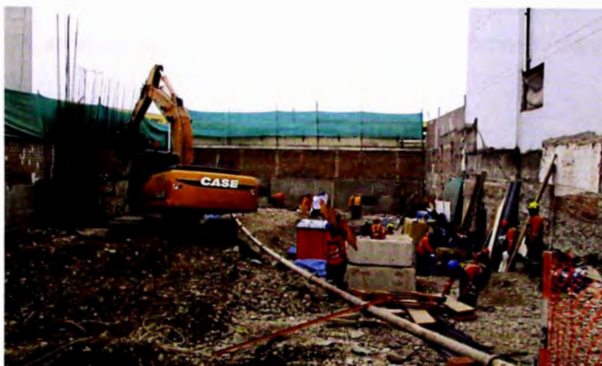
Figura 3.6 Acarreo de andamios de la cuadrilla de acero
