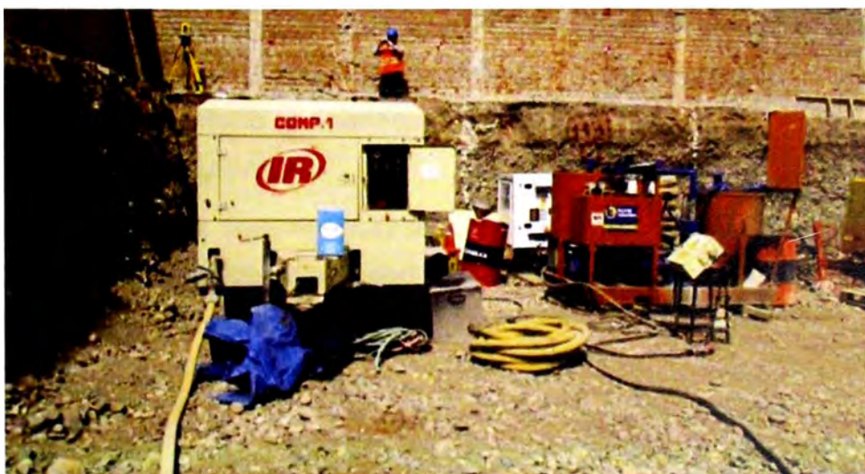
Figura 4.5 Vista ampliada de los equipos mencionados en la Figura 4.4. compresora neumática (izquierda), mezcladora (derecha) y grupo electrógeno (al fondo).
