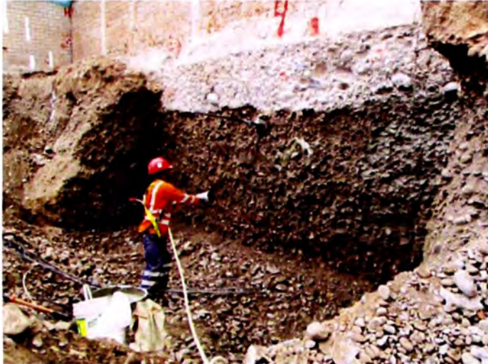
Figura 2.7 Pañeteo en paño de muro pantalla.
