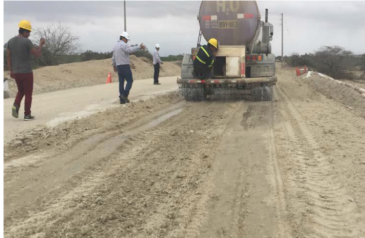
Figura N°2.17 Riego del aditivo Consolid 444. Fuente: Sistema Consolid.
