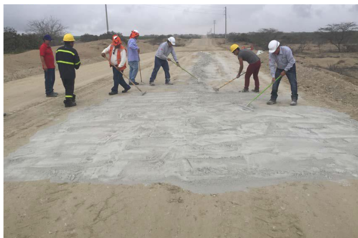
Figura N°2.18 Distribución del aditivo Solidry en todo el área. Fuente: Sistema Consolid.
