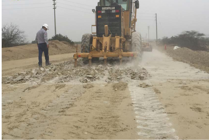
Figura N°2.19 Mezclado de Solidry con la Motoniveladora. Fuente: Sistema Consolid.
