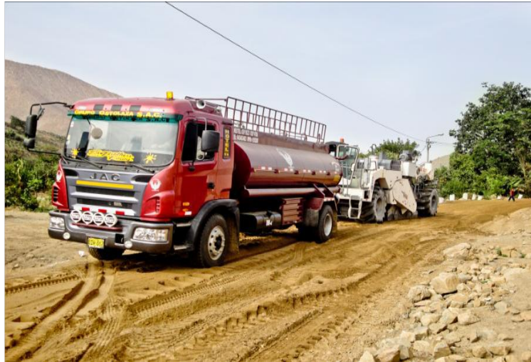
Figura N°2.21 Recicladora conectada a Cisterna con Aditivo Consolid 444. Fuente: Sistema Consolid.
