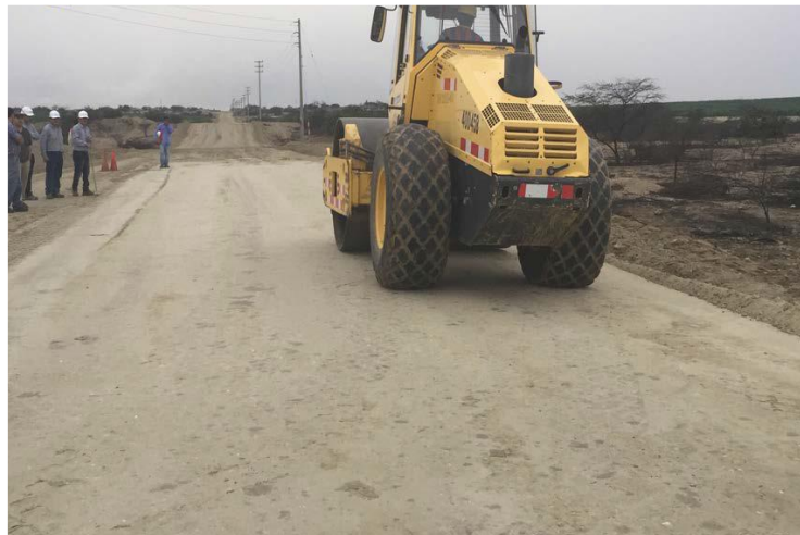
Figura N°2.20 Compactación de suelo estabilizado con el Sistema Consolid. Fuente: Sistema Consolid.
