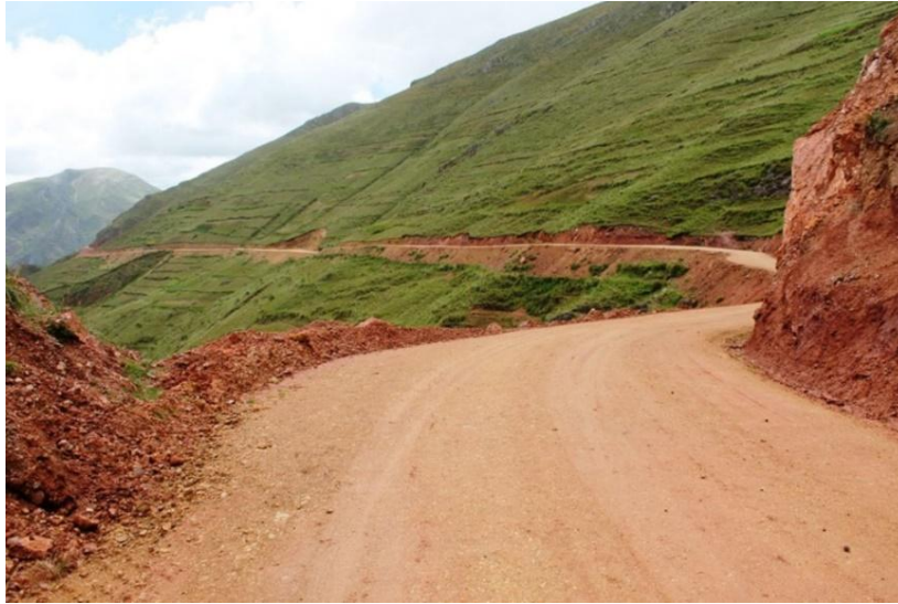
Figura N°2.5 Carretera Afirmada en el departamento de Huancavelica. Fuente: Google.
