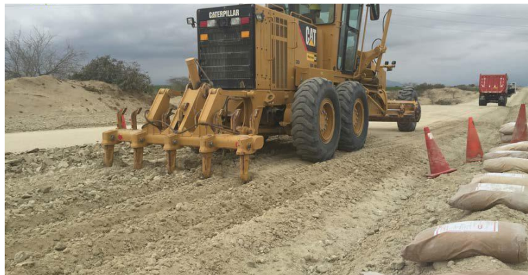
Figura N°2.16 Escarificado de suelo con Motoniveladora. Fuente: Sistema Consolid.
