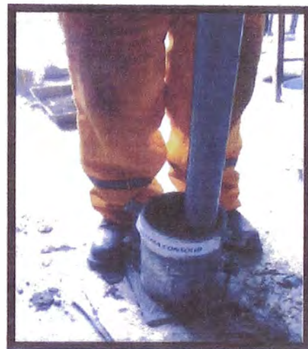
Ensayo de Proctor
