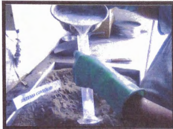
Mezclando Consolid 444 con Agua
