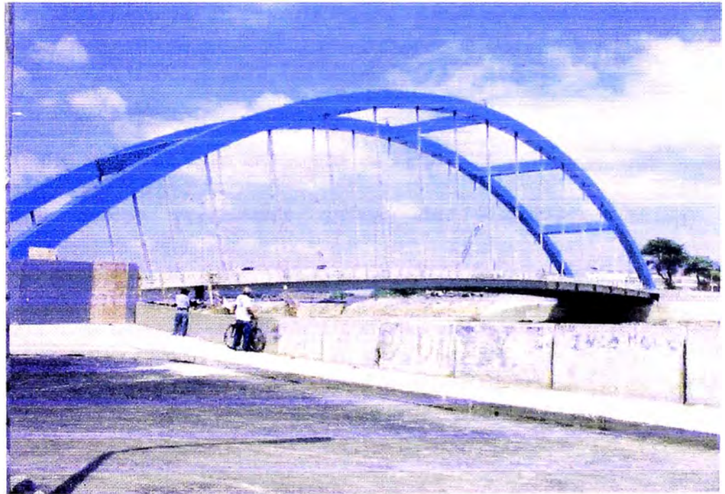
PUENTE BOLOGNESI – PIURA (DIA)
