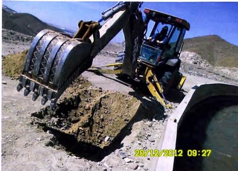
**Fotografía N° 6.- Excavación paralela al canal de cond. con retroexcavadora**
