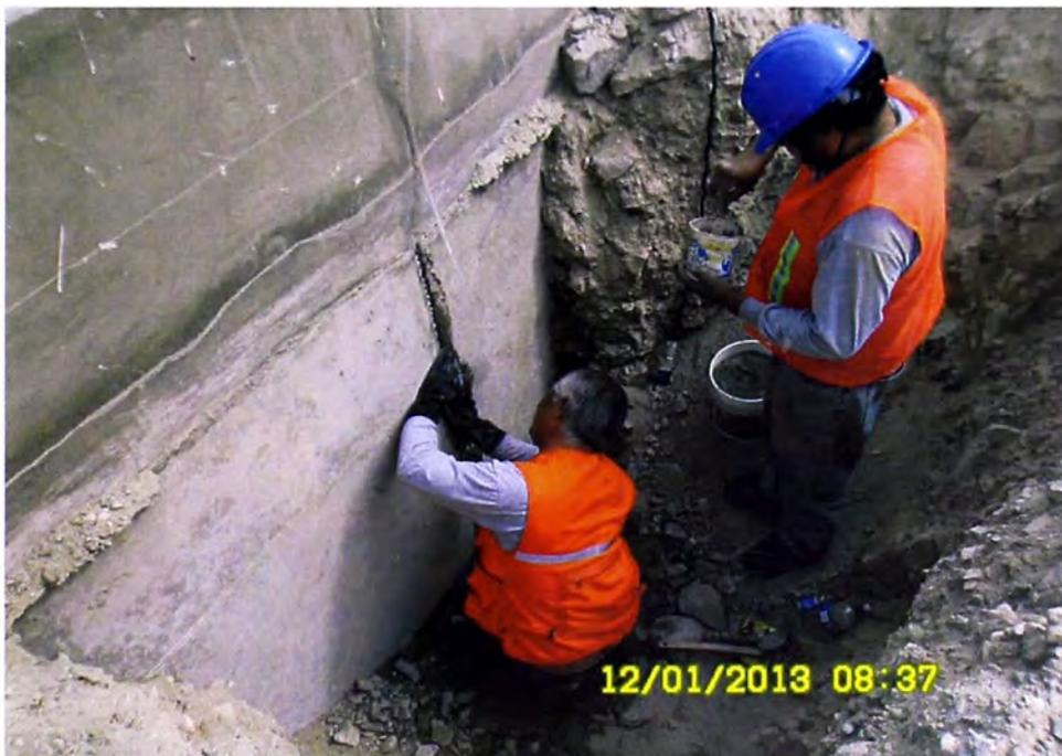
Fotografía N° 17 Colocación de la mezcla del mortero de fraguado rápido, a lo largo de la junta para sellarla superficialmente.
