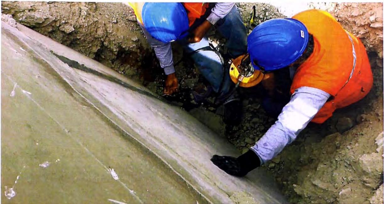
**Fotografía N° 28** al presenciarse fugas de resina en el punto de inyección adyacente, se coloca el siguiente alemite y se inicia el ciclo de bombeo.
