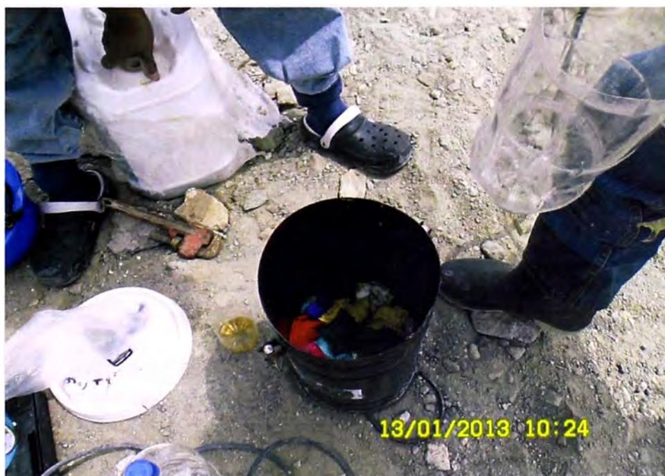
Fotografía N° 23 Contenedor de la bomba manual, el cual se le coloca trapo industrial para darle estabilidad al recipiente de la resina.
