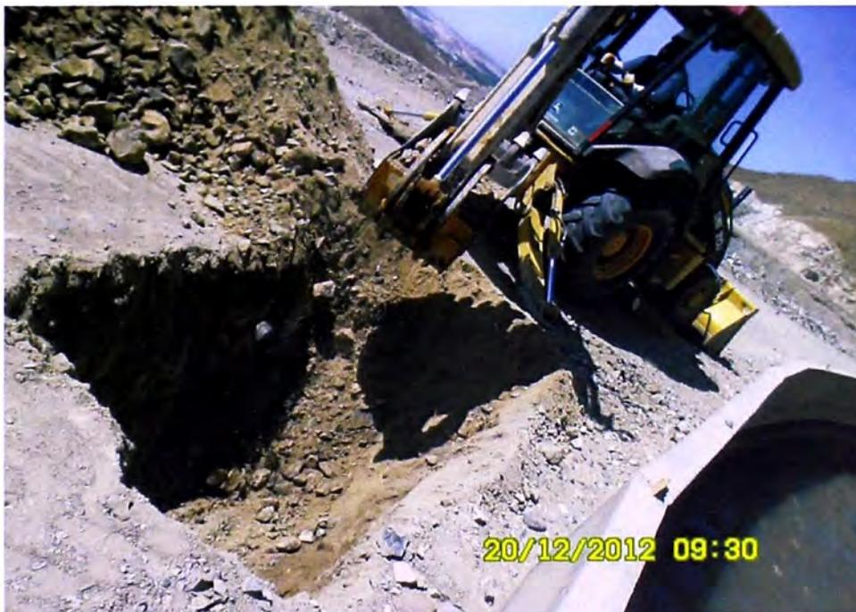
Fotografía N° 8 Excavación con retroexcavadora. Toma 2
