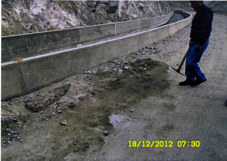
Fotografía N° 1 Filtraciones en el Canal de Conducción. Prog. 4+385Km.
