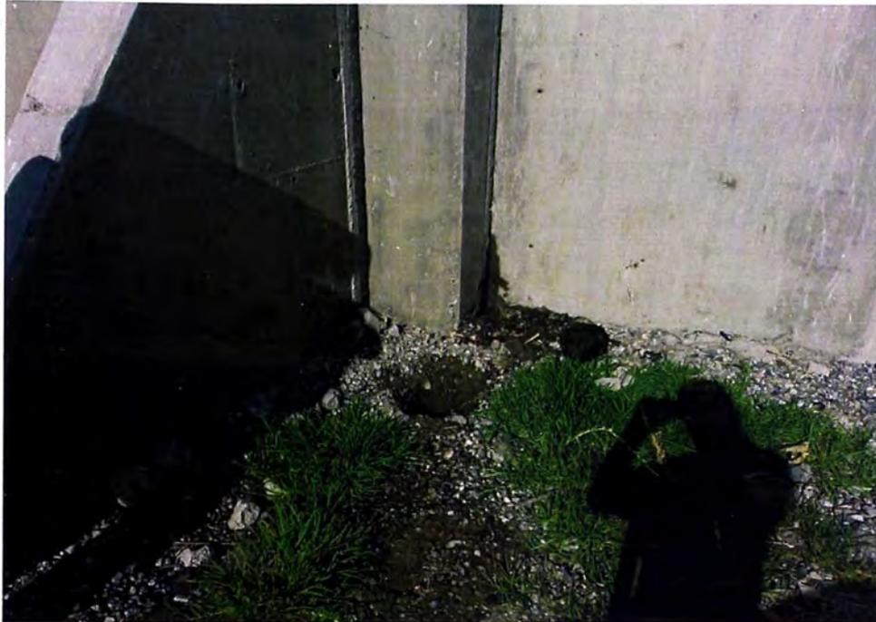
Fotografía N° 5 Filtraciones en el Desarenador. Primer contrafuerte, respecto del ingreso.
