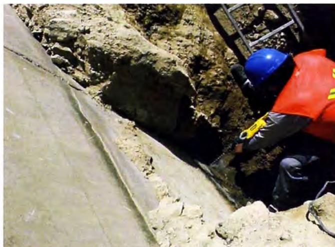
**Fotografía N° 7.- Perforación de los Puntos de Inyección**
