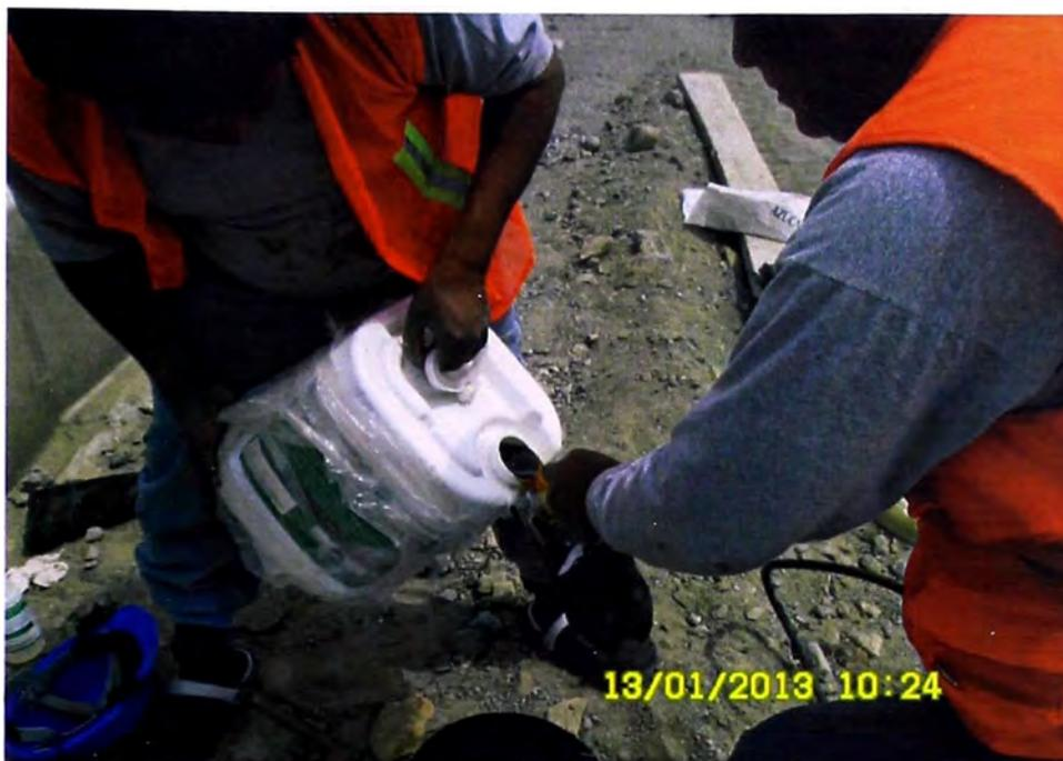
Fotografía N° 24 Llenado del recipiente de la resina. La mezcla está compuesta por la resina de poliuretano más el catalizador.
