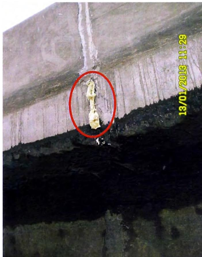
**Fotografía N° 17.- Aparición de resina en el lado interno del canal**
