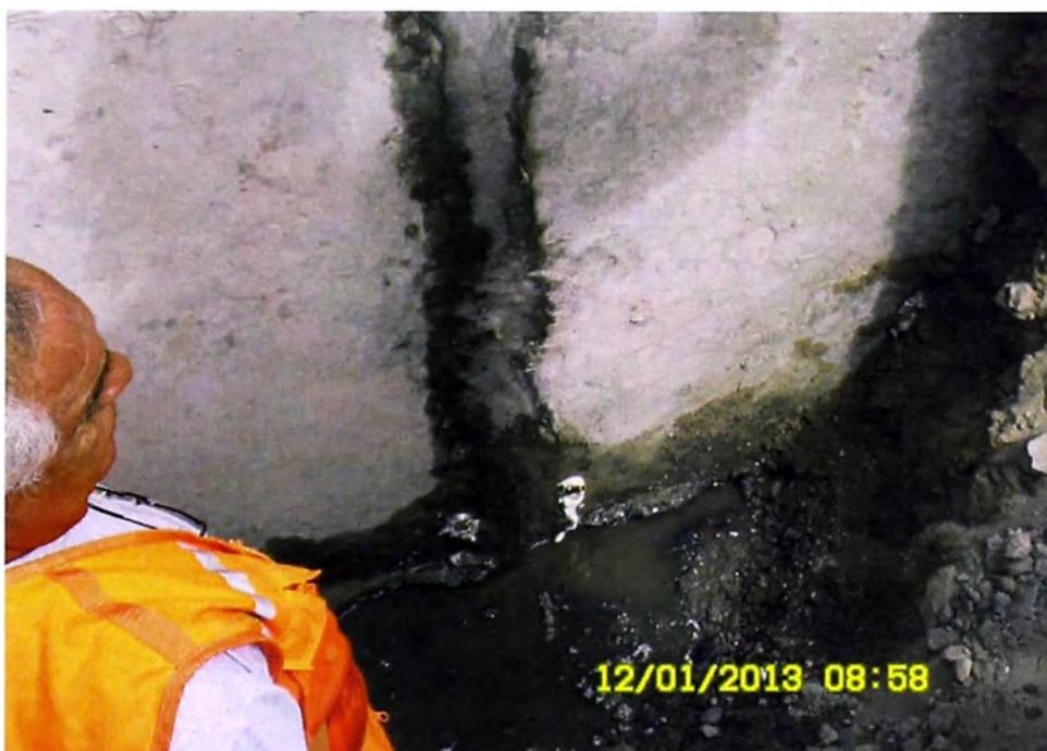
Fotografía N° 19 Filtraciones que persisten en la base del muro.
