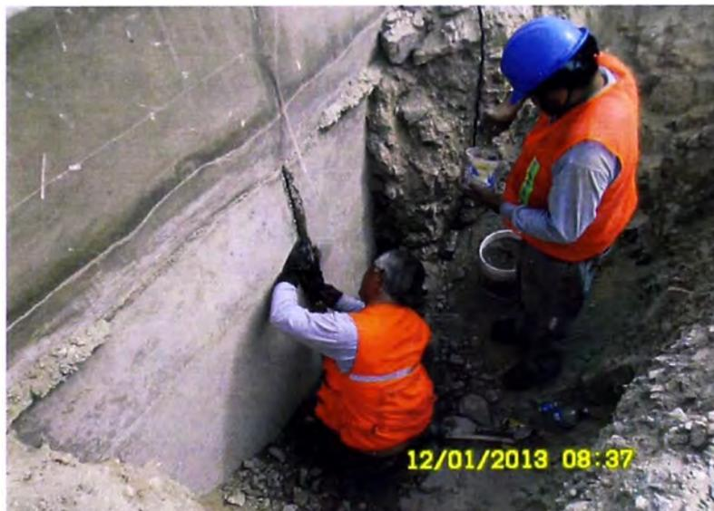
**Fotografía N° 10.- Colocación del mortero hidráulico**
