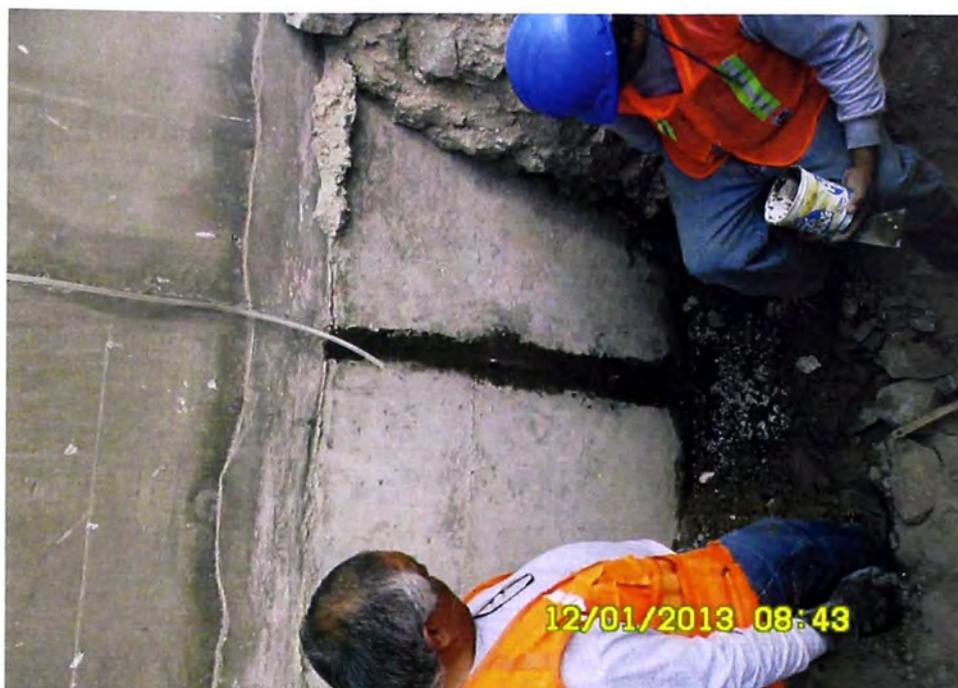
Fotografía N° 18 Junta sellada con mortero.
