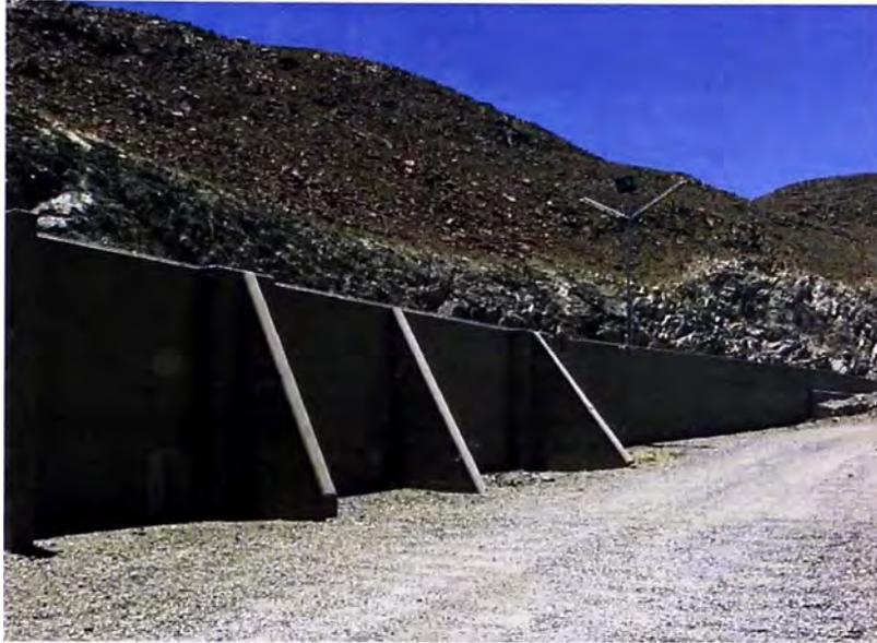
**Fotografía N° 5.- Vista de los contrafuertes del ingreso al desarenador**
