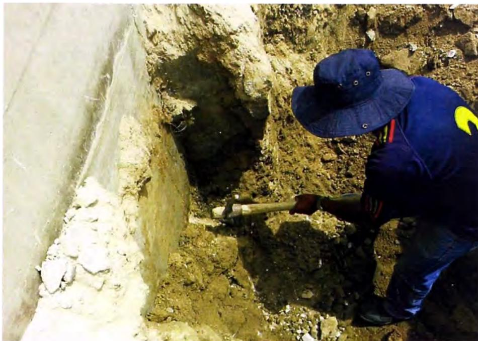
Fotografía N° 9 Excavación con manual para el Canal de Conducción. Posterior a la excavación con Maquinaria.
