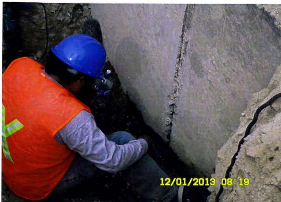
Fotografía N° 13 Limpieza del polvo en los orificios perforados.
