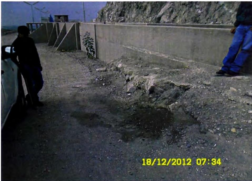
Fotografía N° 2 Filtraciones en el Canal de Conducción, entrada al desarenador. Prog. 4+700Km
