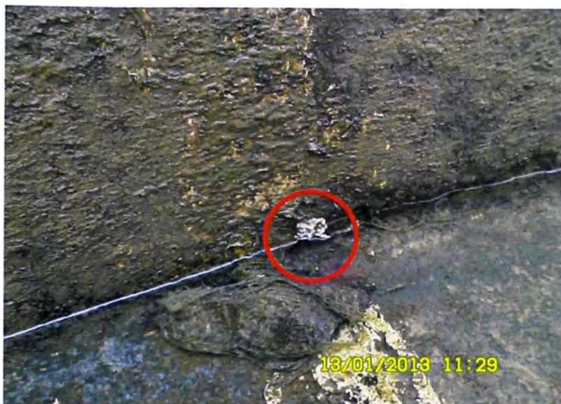
**Fotografía N° 18.- Aparición de resina en la junta de muro con losa**
