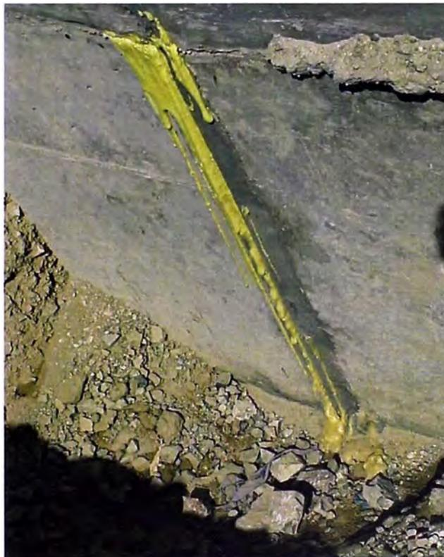
**Fotografía N° 15.- Aparición de resina en la junta de construcción**
