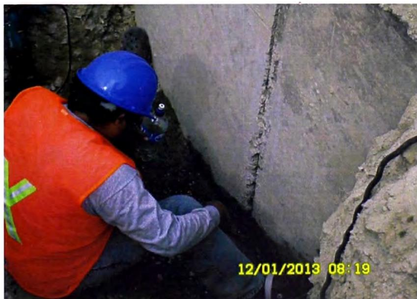
Fotografía N° 9.- Vista de la junta de construcción a reparar
