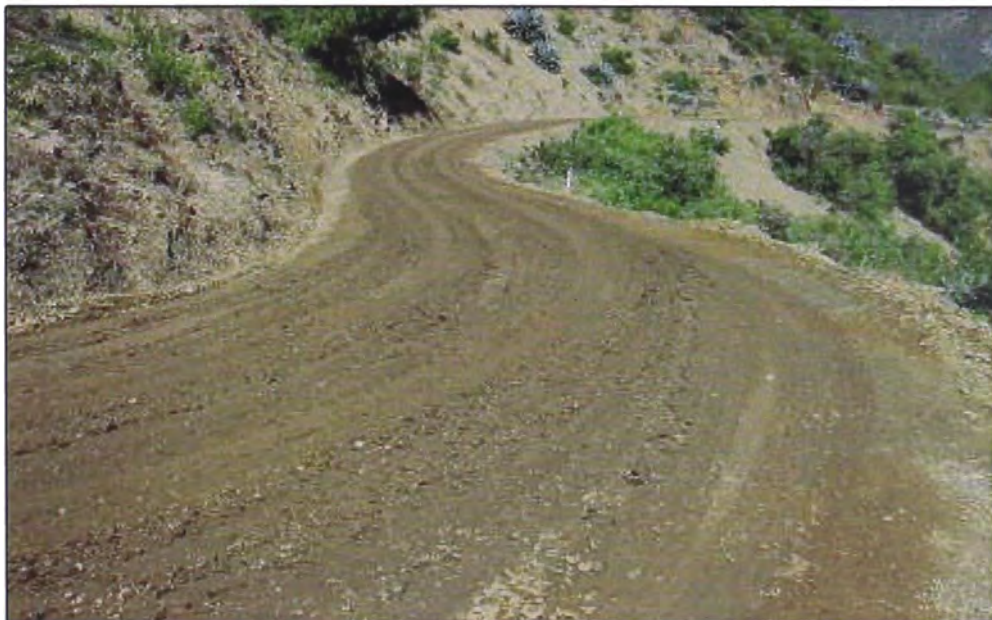
Figura N°5.9.- Estado en que queda después del mezclar homogéneamente
