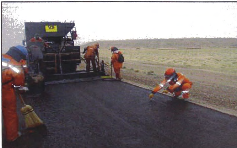
Figura N°5.15.- Aplicación de Slurry Seal sobre la plataforma
