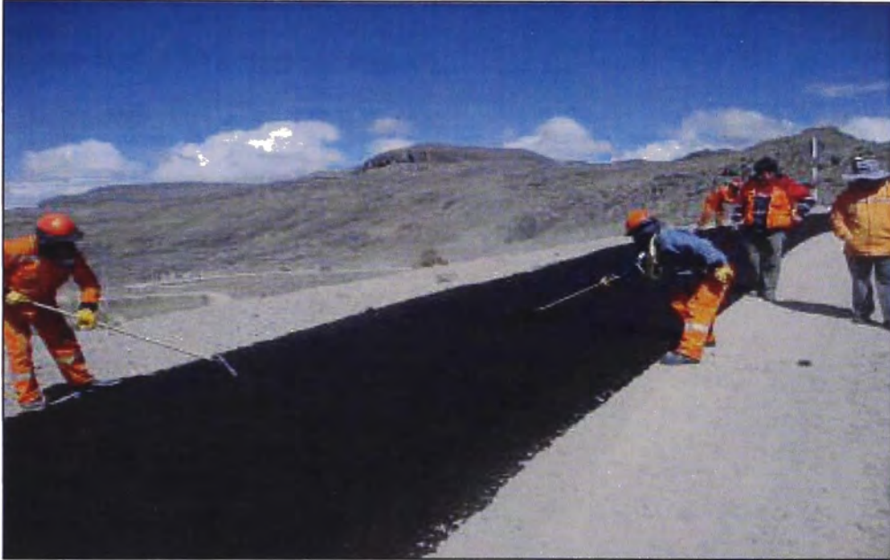
Figura N°5.16.- Corrigiendo irregularidades puntuales
