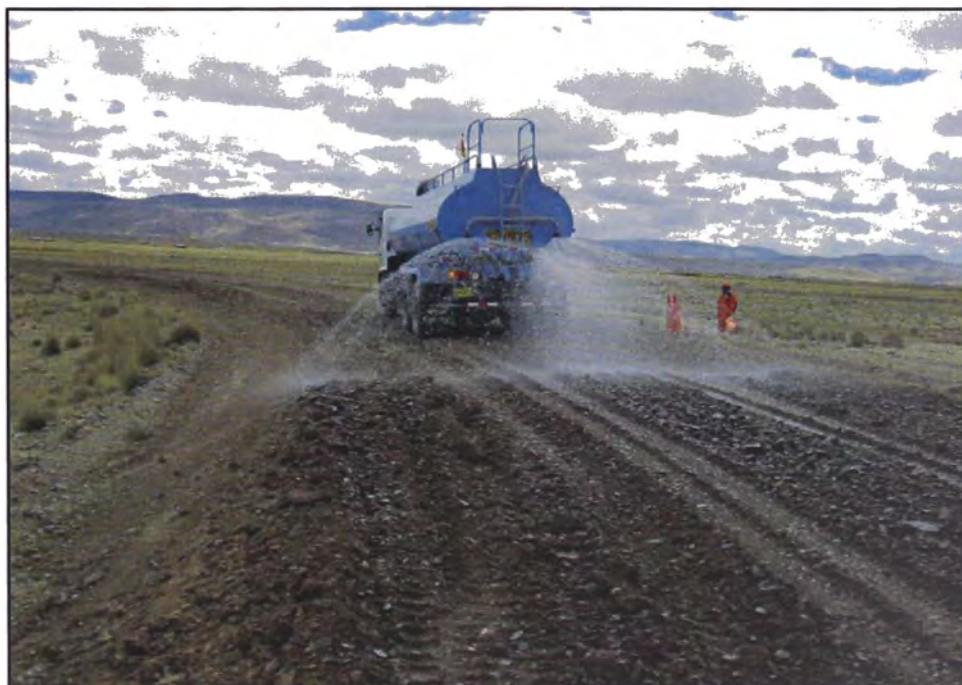
Figura N°5.7.- Riego de agua - aditivo
