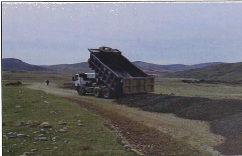
Figura N°5.2.- Descarga de material afirmado
