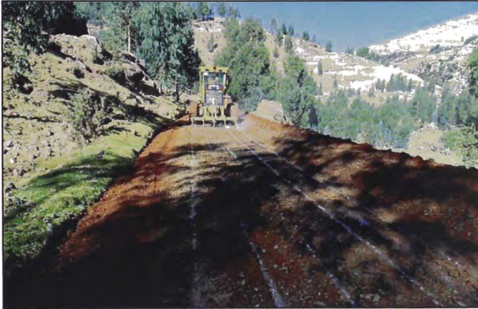
Figura N°5.1.- Escarificado de la superficie existente
