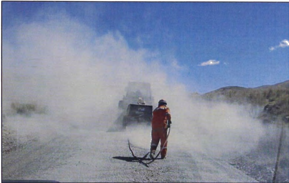
Figura N°5.14.- Limpieza de la plataforma
