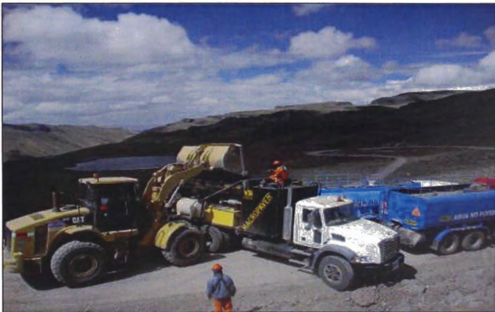
Figura N°5.13.- Carguío de arena hacia el camión Macropaver
