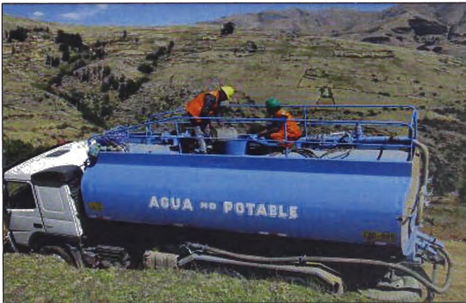
Figura N°5.5.- Aplicación del estabilizador químico en la cisterna
