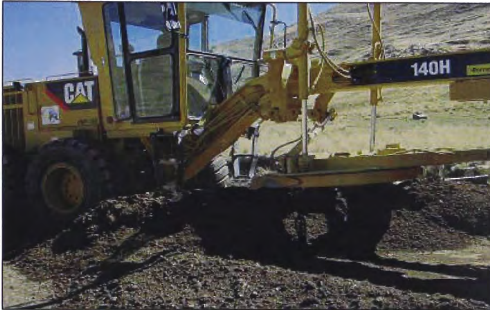
Figura N°5.8.- Batido del material y el aditivo - agua
