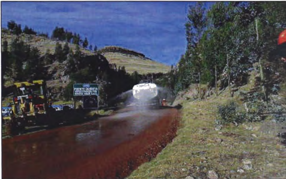
Figura N°5.11.- Curado de la plataforma
