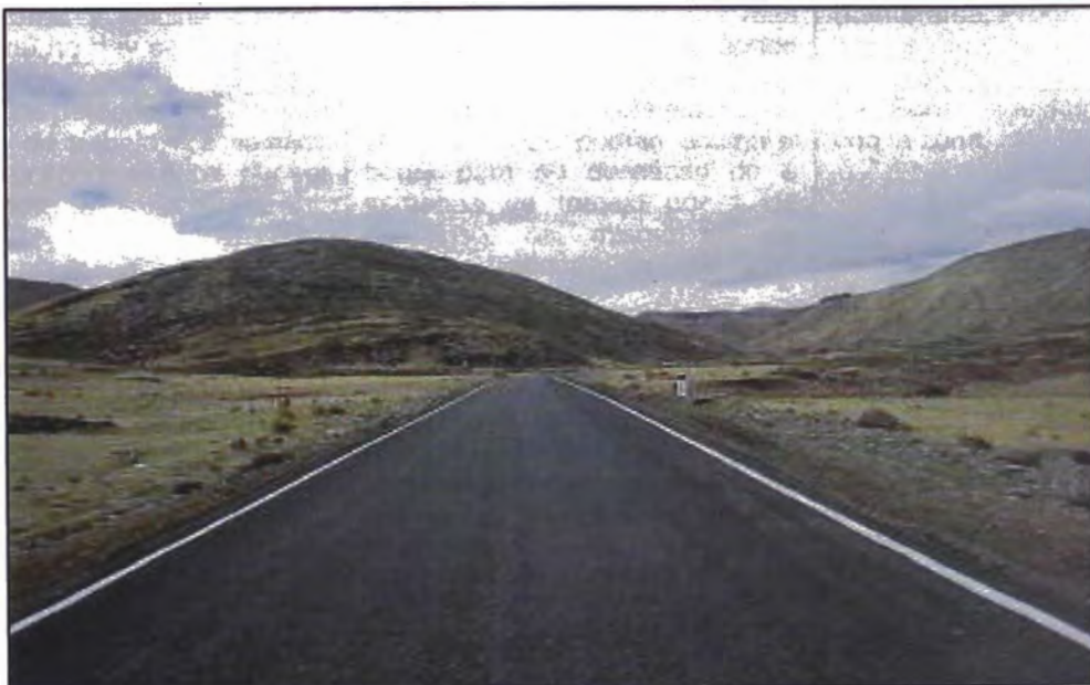
Figura N°7.2.- Estado final con marca en el pavimento
