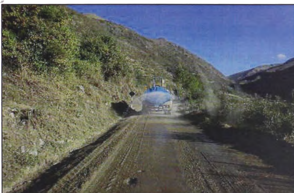
Figura N°5.4.- Riego del material con agua
