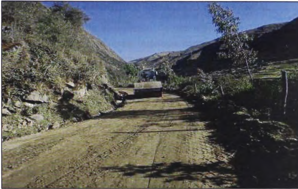
Figura N°5.10.- Compactación de la mezcla homogénea
