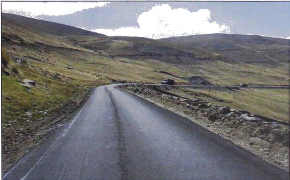
Figura N°5.17.- Estado después da la aplicación del Slurry seal
