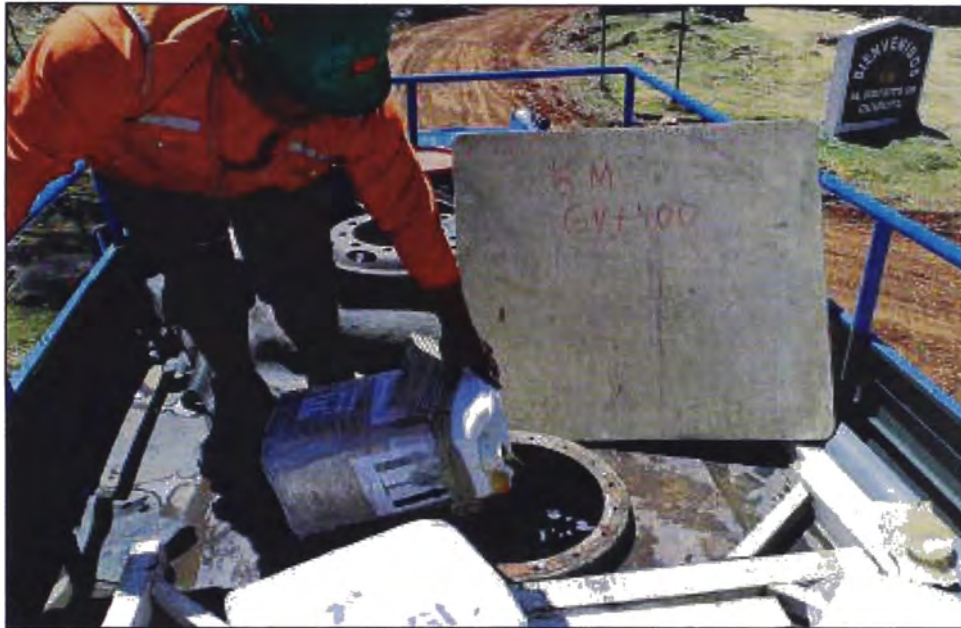
Figura N°5.6.- Estabilizador químico ingresando a la cisterna con agua
