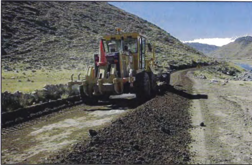
Figura N°5.3.- Extendido del material
