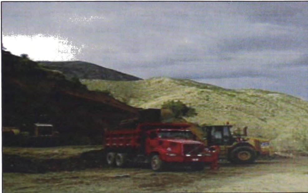
Figura N°5.19.- Carguío de material
