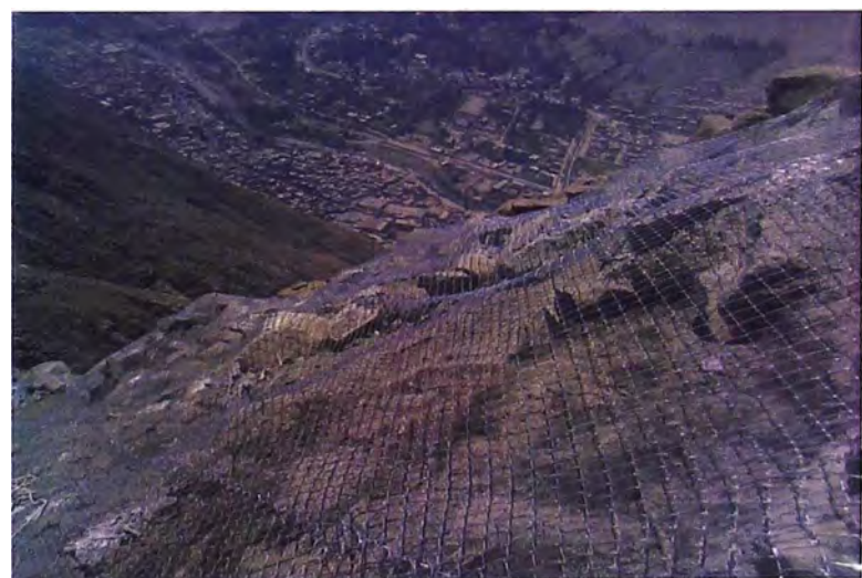
Vista de viviendas que protege la estabilización con mallas.
