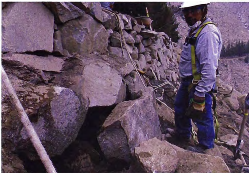
Vaciado de concreto en juntas.
