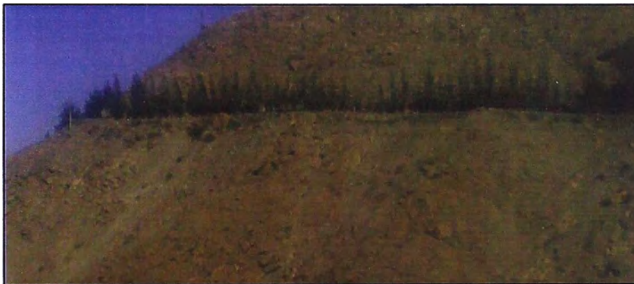
Laderas vulnerables al desprendimiento de materiales y rocas
