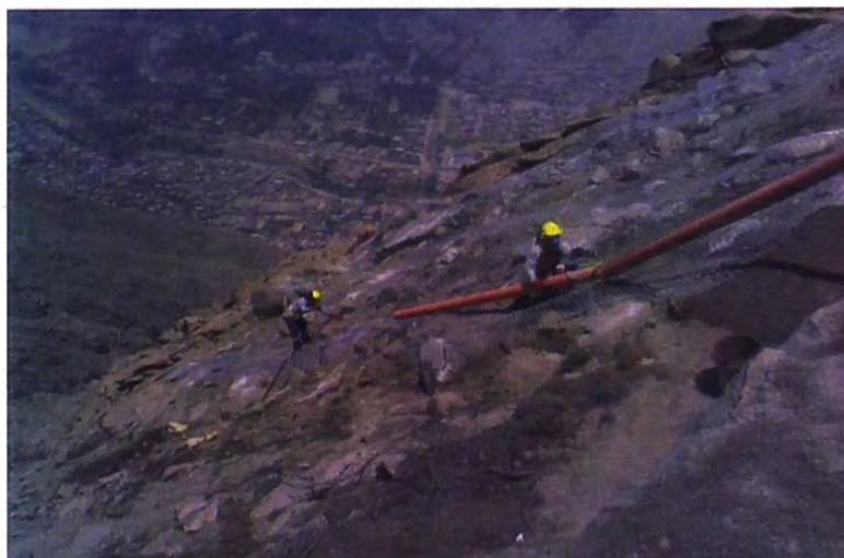
Vaciado de concreto por mangas en anclajes de acero.
