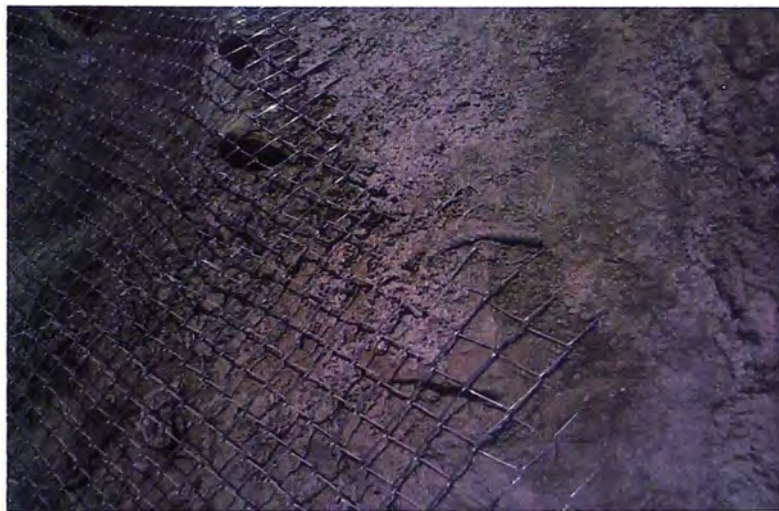
Mallas en parte superior cercanas a camino protegida con concreto
