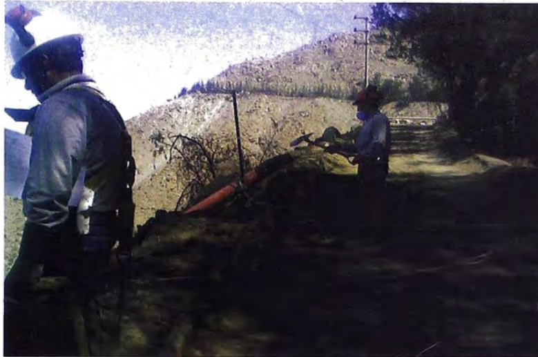
Habilitación de concreto a vaciar en mallas de laderas
