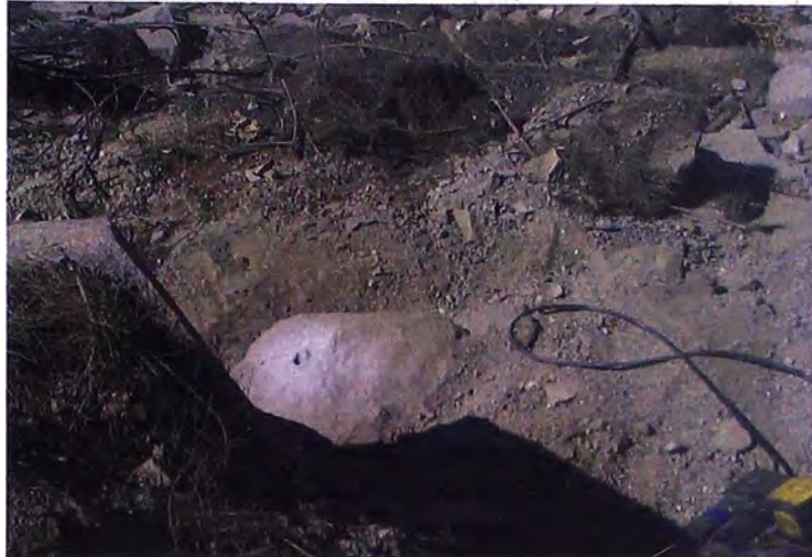
Perforación para recepción de anclajes en roca
