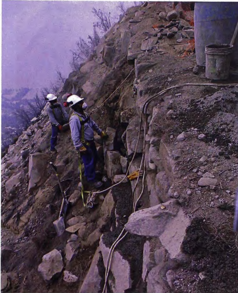
Estabilización de pircas a lo largo de camino de acceso taza
