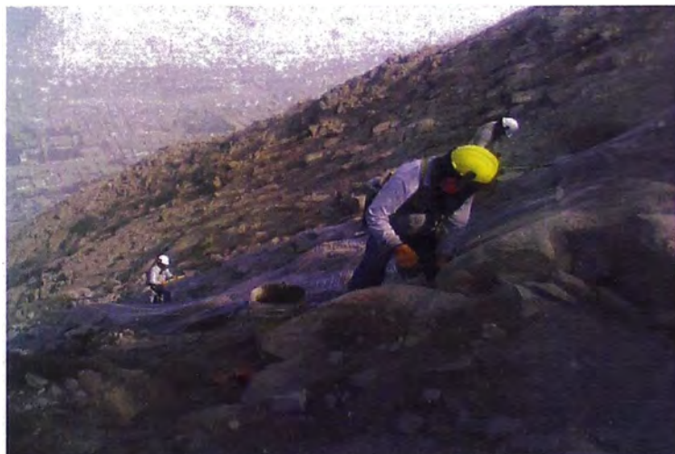
Sujeción de mallas de acero en anclajes de acero
