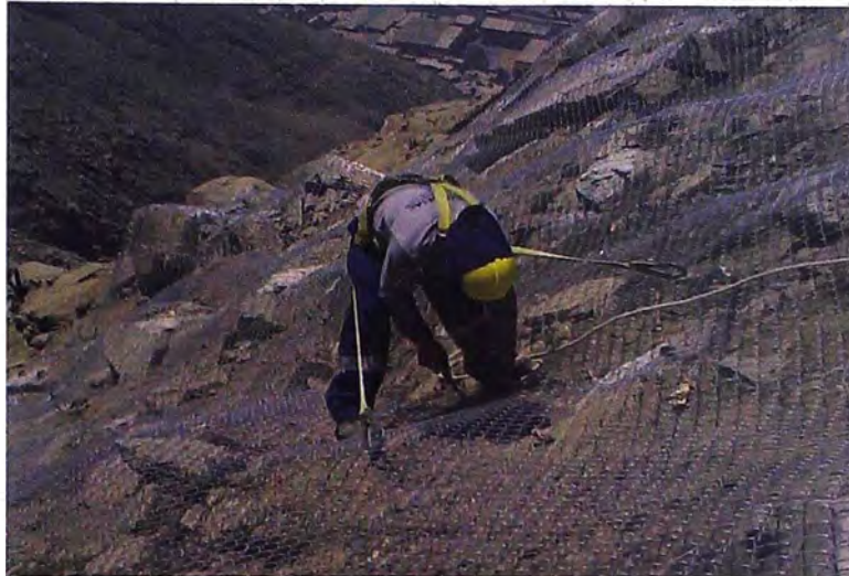
Amarre de mallas con alambre galvanizado.
