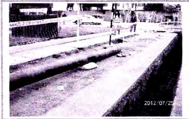
Tuberías de acero revestidas almacenadas sobre terreno natural.
