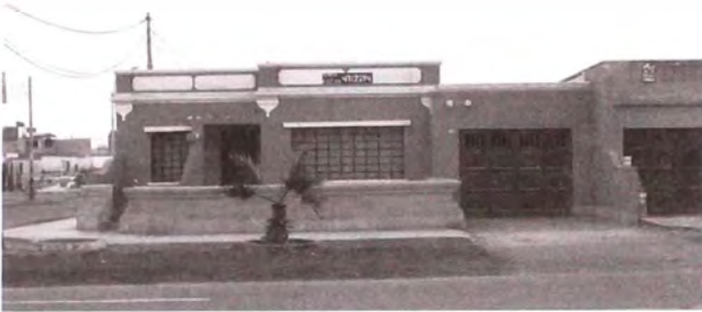
22. Lote 4 Mza. C Cornisas molduradas soportadas por ménsulas planas y molde del parapeto lo asocian a esta versión tradicional. Extensos voladizos laterales parecen contradecir la idea anterior
