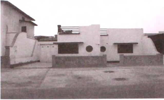
20. Lote 16 Mza. J Un franco y limpio “estilo buque” recordando las líneas de la Municipalidad de San Bartolo
