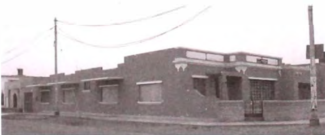
22. Lote 4 Mza. C Cornisas molduradas soportadas por ménsulas planas y molde del parapeto lo asocian a esta versión tradicional. Extensos voladizos laterales parecen contradecir la idea anterior
