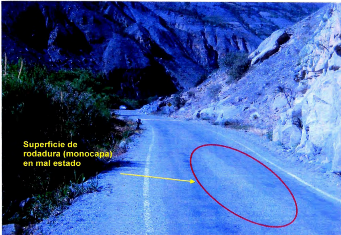
Figura N° 4.27: Estado de la superficie de rodadura (monocapa).
