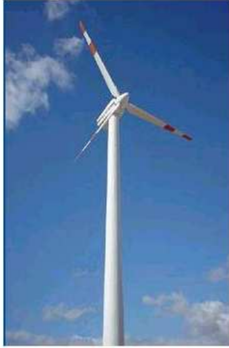
Figura 1.5: Vista del aerogenerador ACSA, que utiliza el sistema de regulación por paso variable
