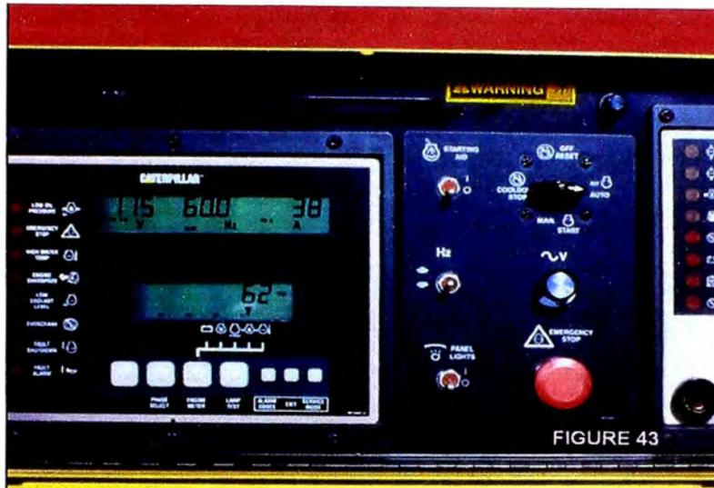
Fig. 63.- Módulo de control electrónico.
