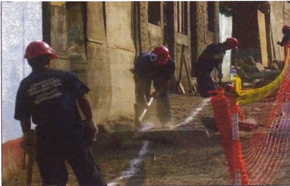
Foto 3.1: Excavación de Zanja de la Red Condominial
