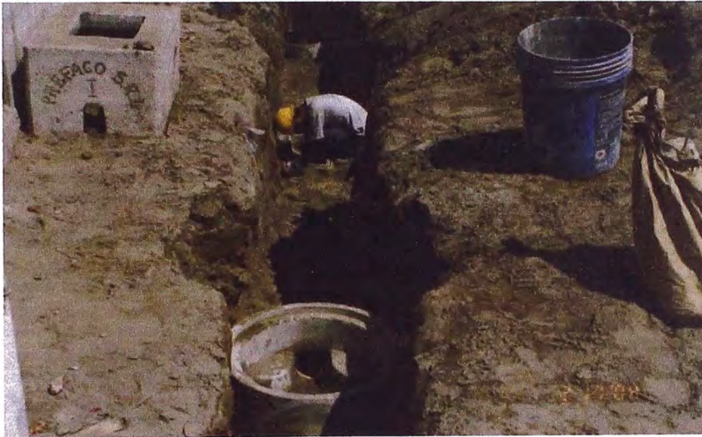
Foto 3.3: Instalación de las Cajas y Tuberías Condominiales
