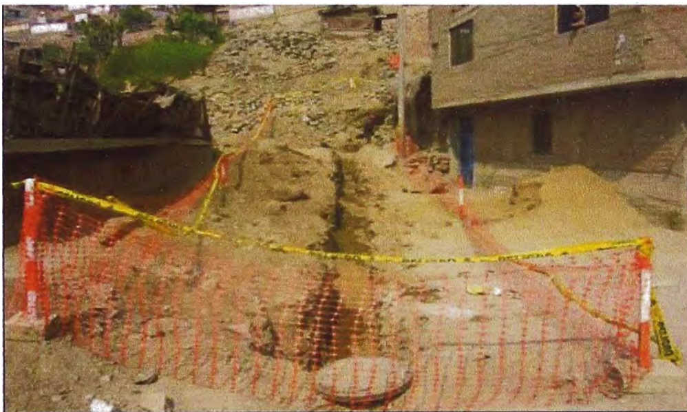
Foto 3.4: Relleno y Compactación de Zanjas
