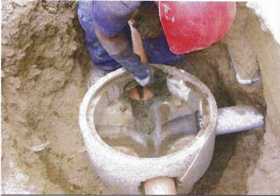
Foto 3.2: Instalación de la Caja Condominial
