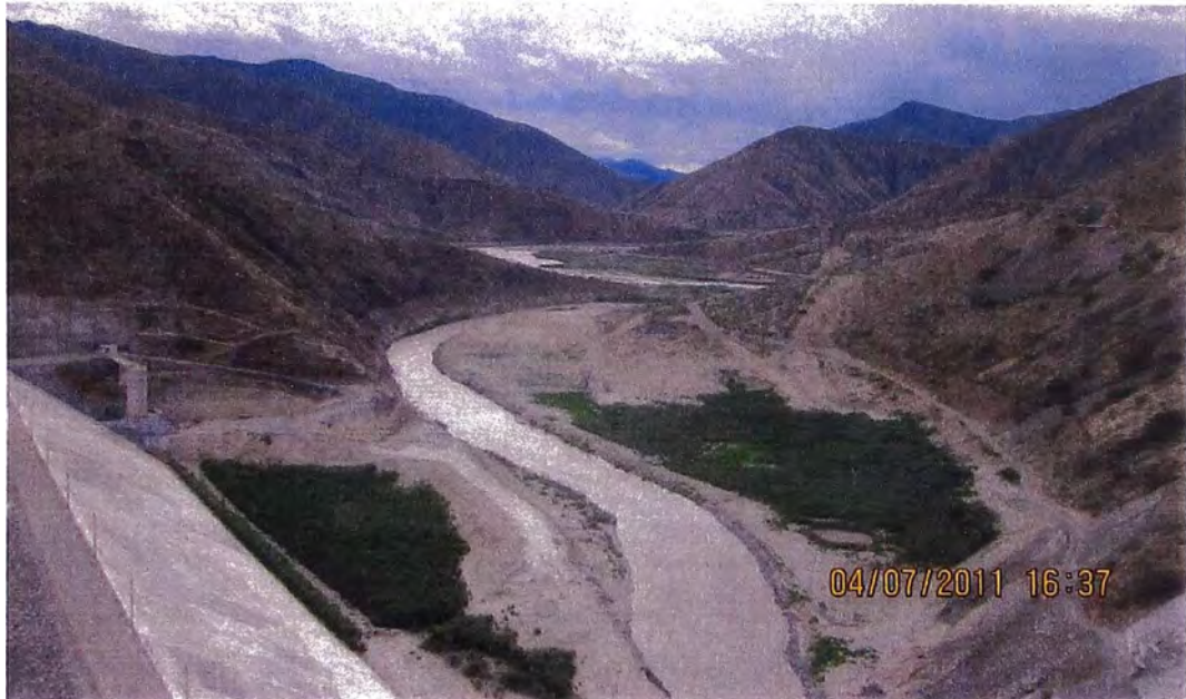
Foto 01: Vista Presa Limón, capacidad de almacenamiento de la presa para la primera etapa es de 44 millones de metros cúbicos de agua.
