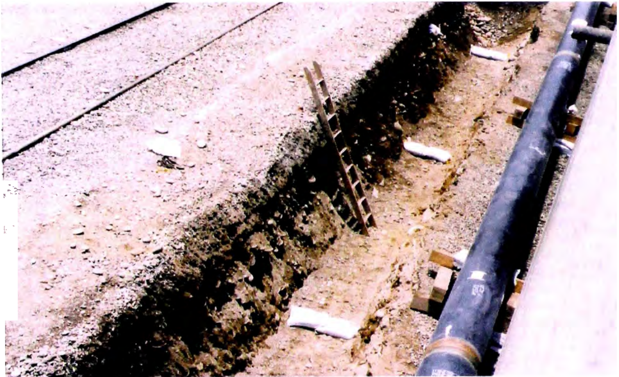
Fig. 10. Tubería revestida gas natural DN 20" soldada y sin mangas – Al lado la zanja que la albergará
