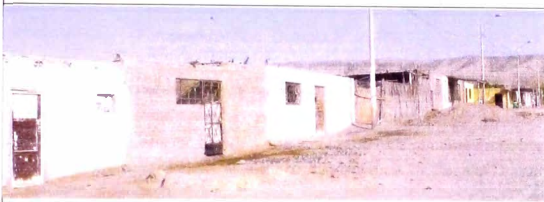
Fotografía N° 2.4: Viviendas con paredes de ladrillo
