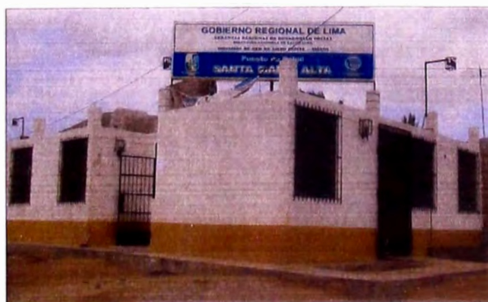
Fotografía N° 2.6: Puesto de Salud
