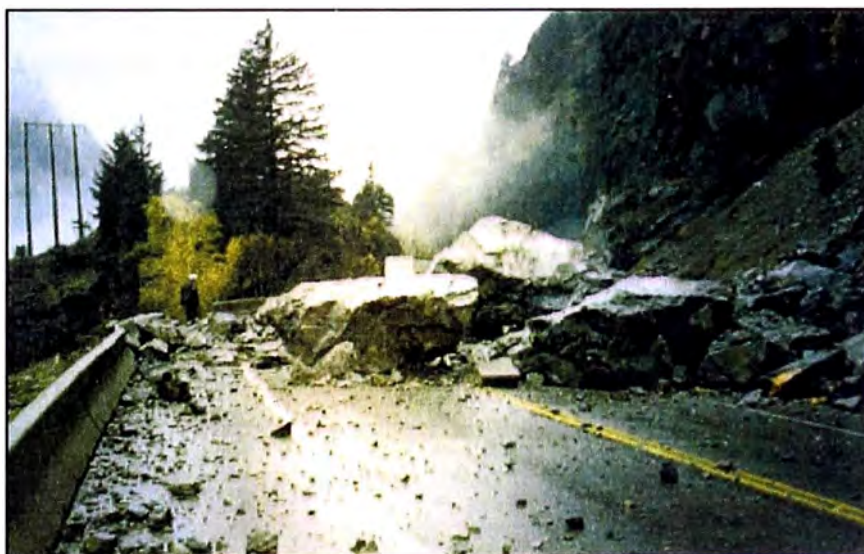
Fig. 3.2 Desprendimiento de rocas sobre una carretera en Canadá
