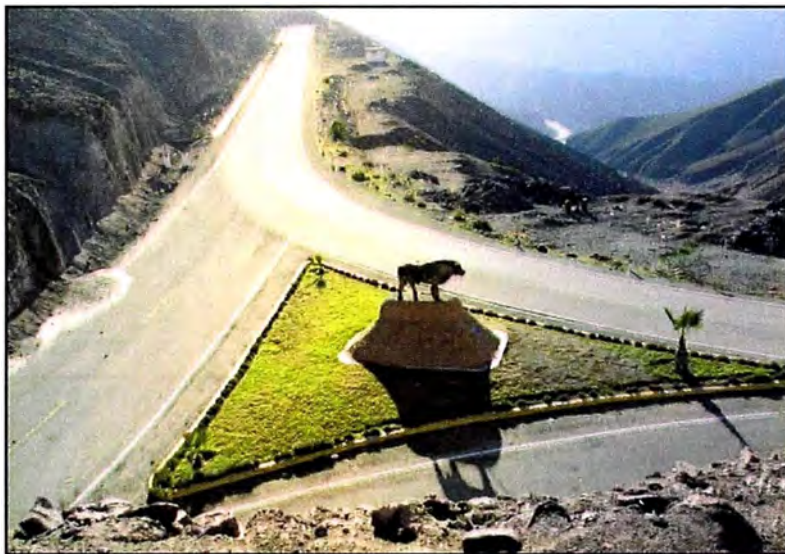
Fig. 5.5 Empalme con Carretera Moquegua – Cuajone
