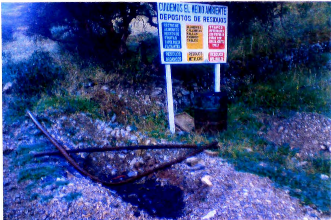
Figura N° 4.4, Al lado de un letrero ambiental se ha contaminado el terreno con desecho de asfalto, campamento Siria.
