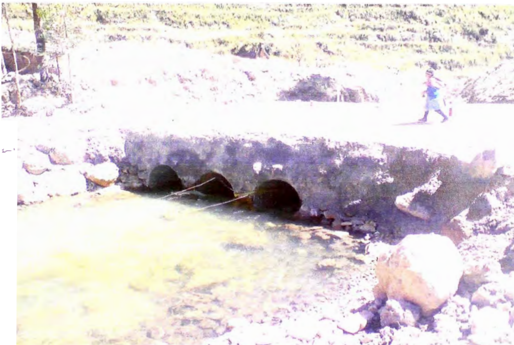
FOTO 8. PONTON EN KM 177+700
