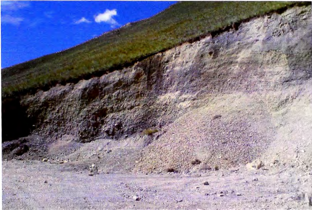
FOTO 15. OTRA CANTERA SIN PROTECCION.
