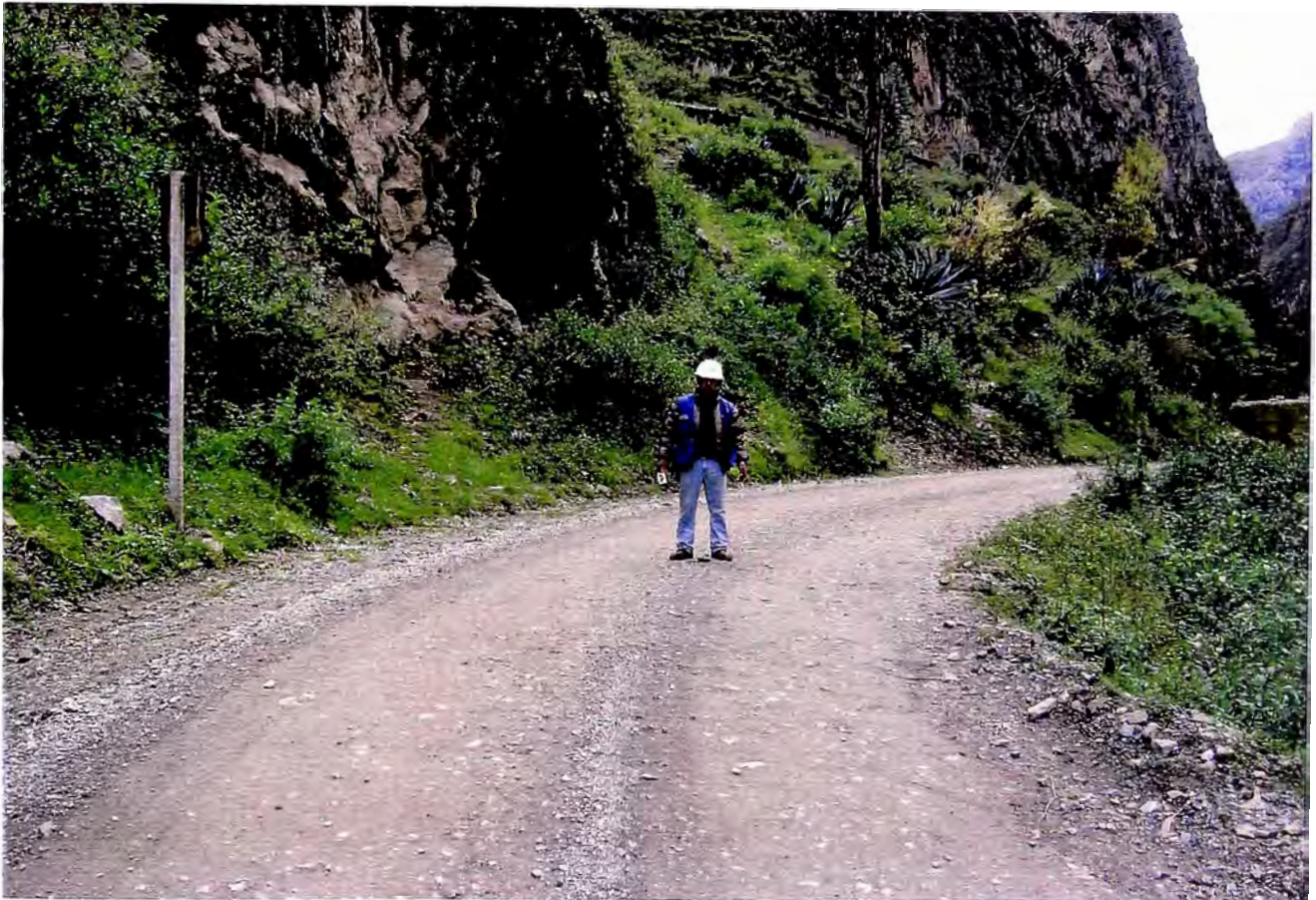
El tramo en estudio se encuentra a nivel de afirmado.
