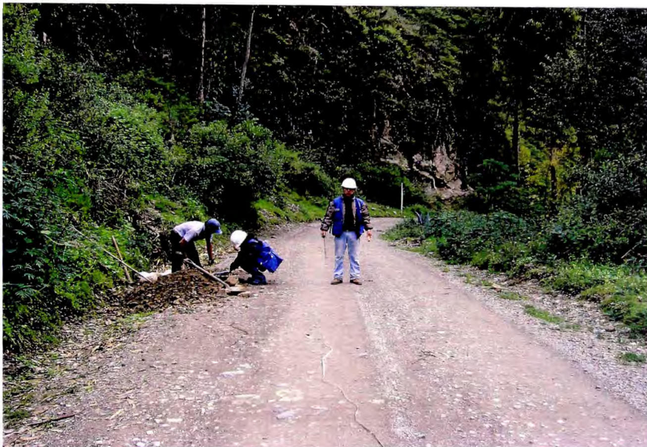
Elaboración de calicatas.
