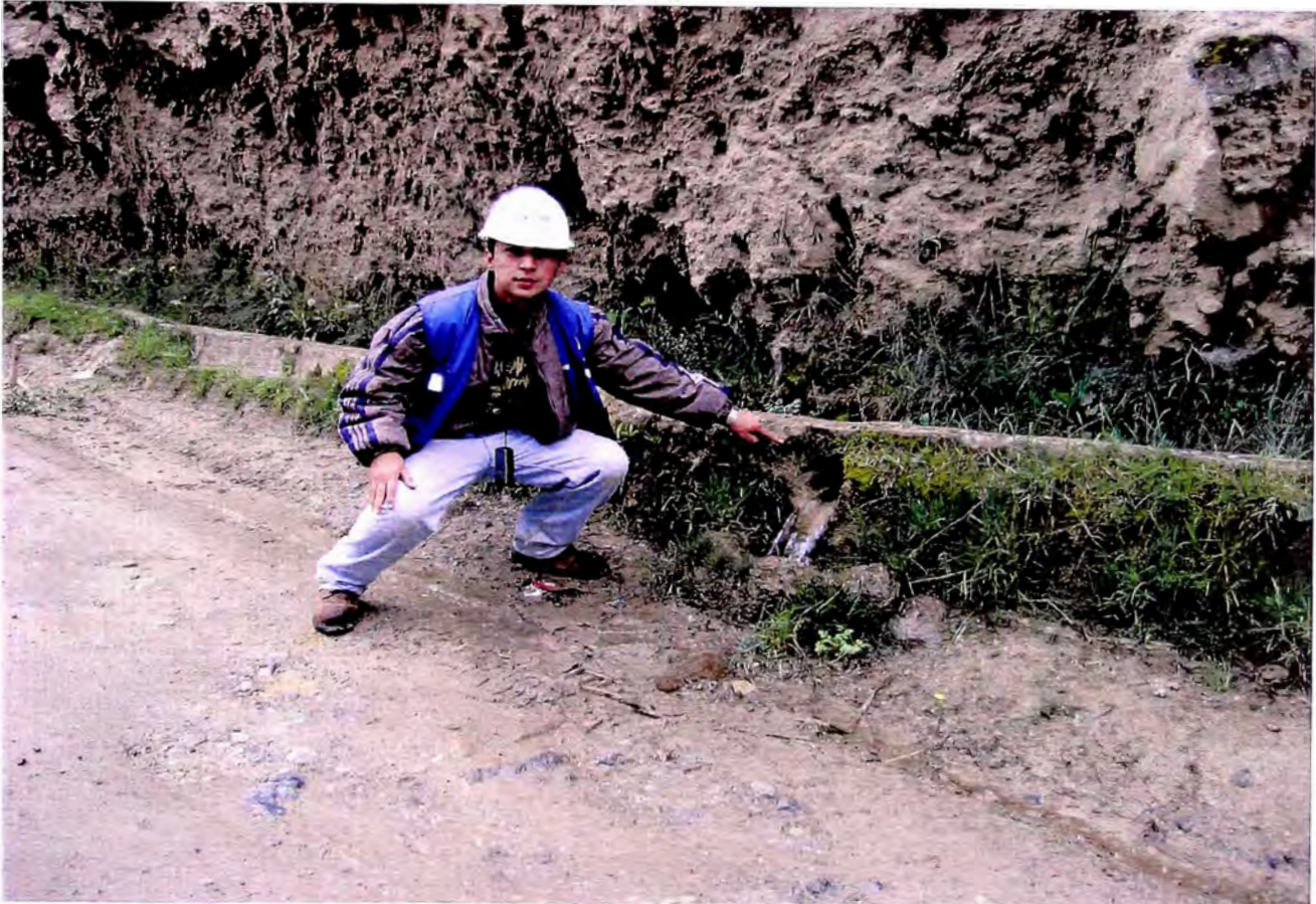
Ubicación de futura alcantarilla.
