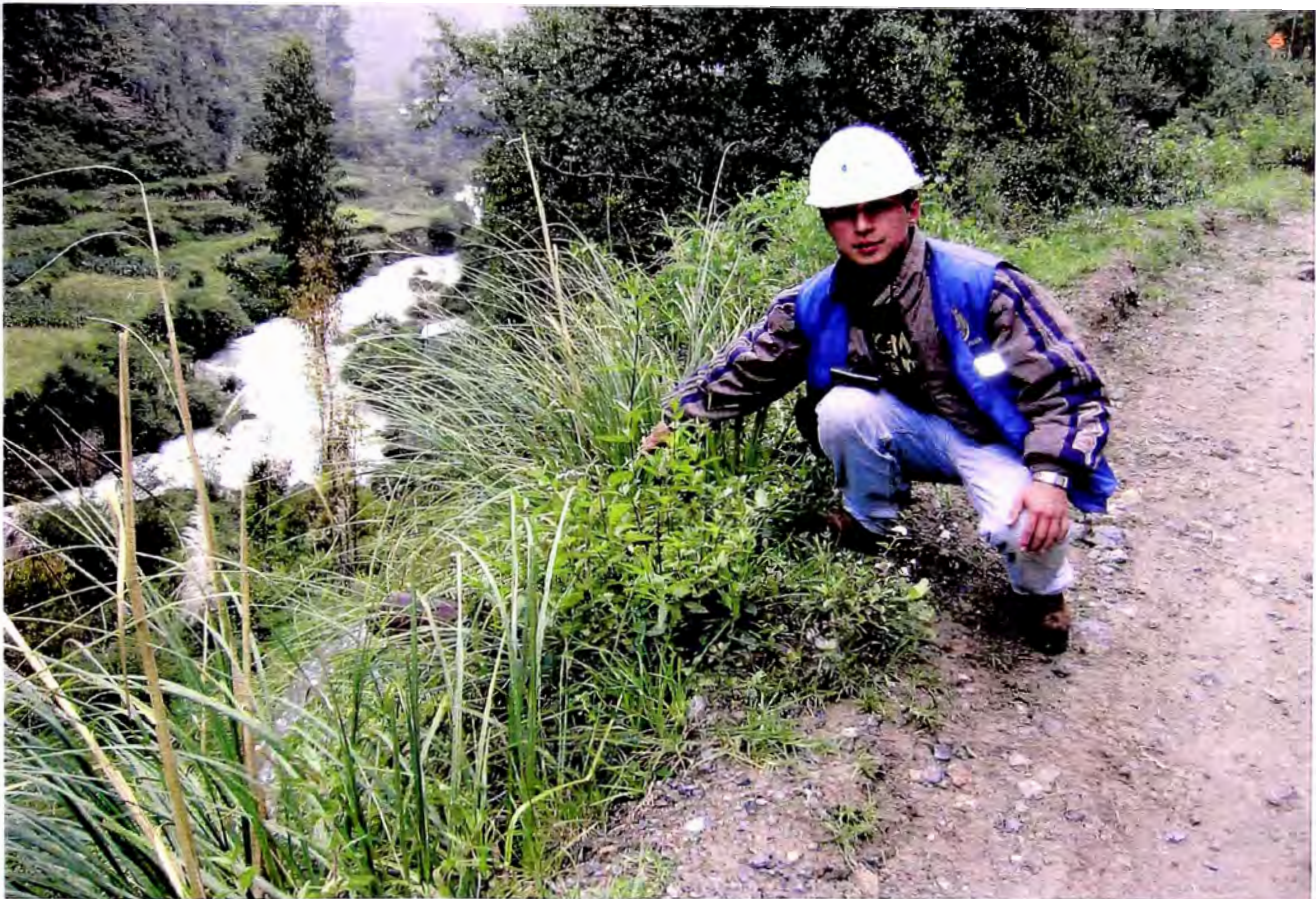
Salida de futura alcantarilla hacia río.
